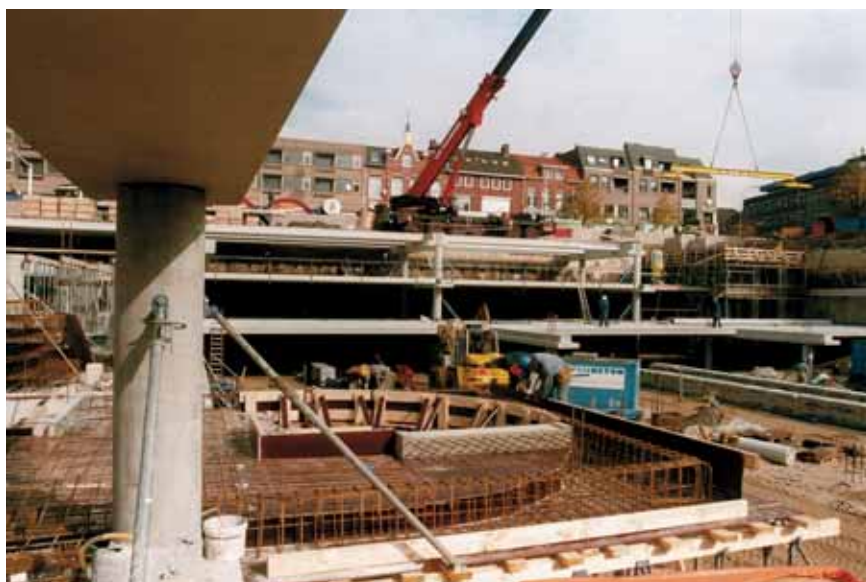
Ondergrondse parkeergarage Venlo
