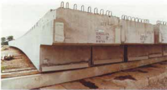
Bild 20. Das Ende des Trägers mit Zahnprofil Fig. 20. The tooth-shaped end of the beam Fig. 20. L'extrémité dentée de la poutre
