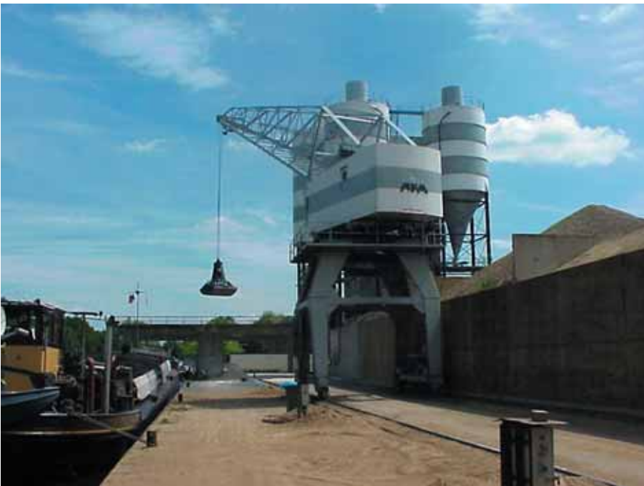
Foto 1.009: Zand- en grindaanvoer per schip, overslag per kraan
