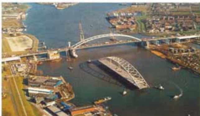
Bild 7. Die vorgefertigten Träger und Überbauplatten der Brücke in der Montage. Die endgültige Fahrbahnplatte besteht aus Fertigteilplatte mit Ortbeton. Das Hauptfeld wird von einem vorgefertigten Stahlbogen überspannt, der gerade in Position gebracht wird.
