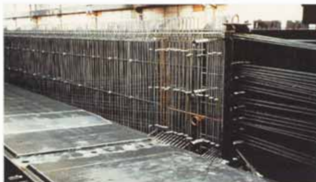
Bild 8 a. Bewehrung und Vorspannung in der offenen Form
