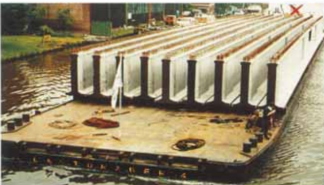
Bild 9 b. Transport eines kompletten Feldes mit neun Trägern per Ponton zur Baustelle in Rotterdam Fig. 9 b. Transport by pontoon of one complete field consisting of nine beams to the site in Rotterdam Fig. 9 b. Transport par ponton vers le chantier à Rotterdam d'un élément complet constitué de 9 poutres
