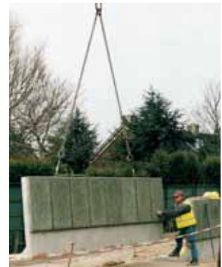
Montage van prefab elementen voor geluidsscherm Houten foto: Willem Hoog
