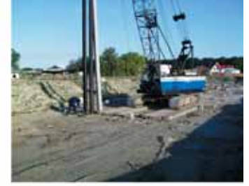
Prepal, betonnen heipalen
