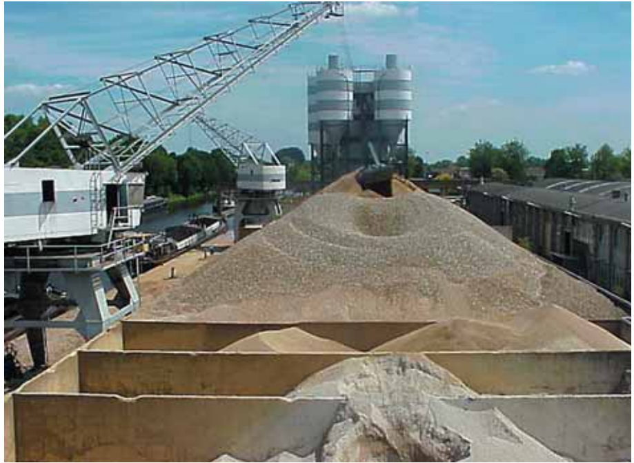
Foto 1.010: Zand- en grindopslag in gescheiden vakken. De dagsilo's en het molenhuis zijn op de achtergrond duidelijk zichtbaar
