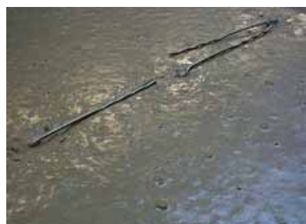
Foto 1.030: ZVB, wandelement met spouwankers
