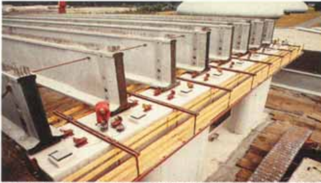
Bild 11. Sobald die Träger in Position gebracht sind, werden sie zur Stabilisierung provisorisch miteinander verbunden
