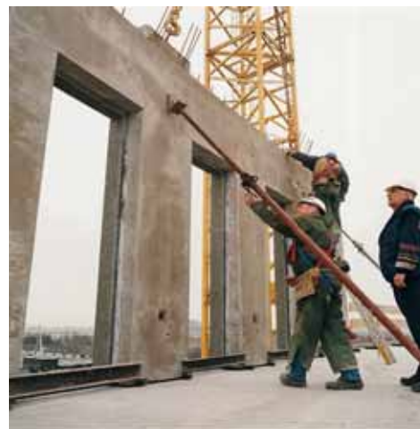
Toepassing van verdiepingshoge dragende gevelelementen in het RIVA-gebouw, 's-Hertogenbosch (foto: Steef Croonen)
