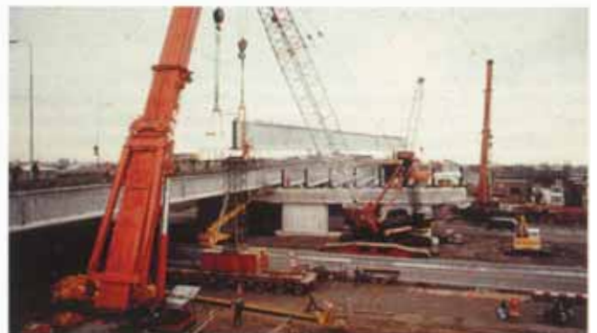
Bild 10. Millimeterarbeit von vier Mobilkränen bei der Montage Fig. 10. Complicated erection operations by four mobile cranes Fig. 10. Mise en place complexe à l'aide de quatre grues mobiles
