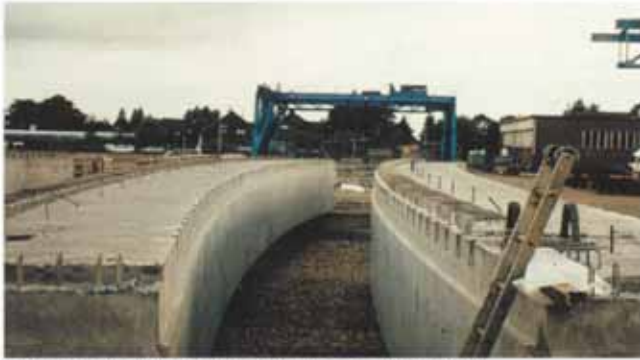
Bild 19 a. Die gewölbten Kastenträger aus Spannbeton . . . Fig. 19 a. The curved prestressed box-girders in the stockyard . . . Fig. 19 a. Poutres-caissons cintrées et précontraintes sur le site d'entreposage . . .
