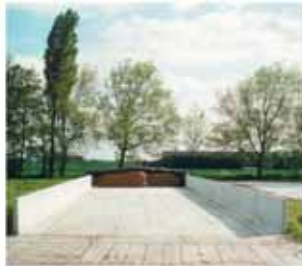
AGRAB, betonnen mestilo's
