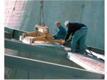
Bevlon, betonnen kanaalplaatvloeren
