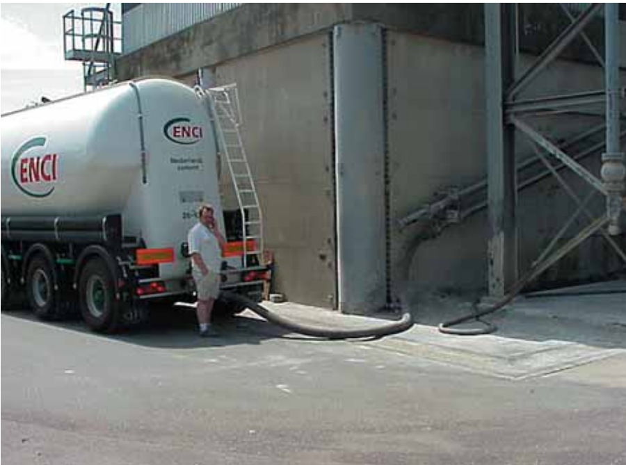
Foto 1.012: Aanvoer van cement per as. De cementsilo wordt volgeblazen
