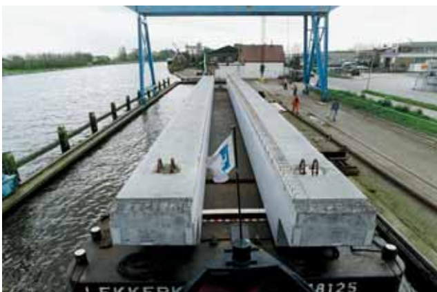
Transport van zeer grote elementen (ringlijn Amsterdam), gedeeltelijk over water foto: Eppo Notenboom
