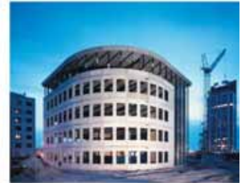
Belton, betonnen gevelementen
