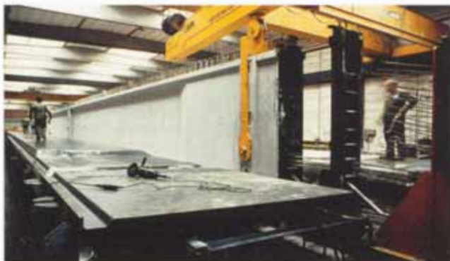
Bild 8 b. Etwa 14 Stunden nach dem Gießen wird der Träger vorgespannt und aus der Form gehoben
