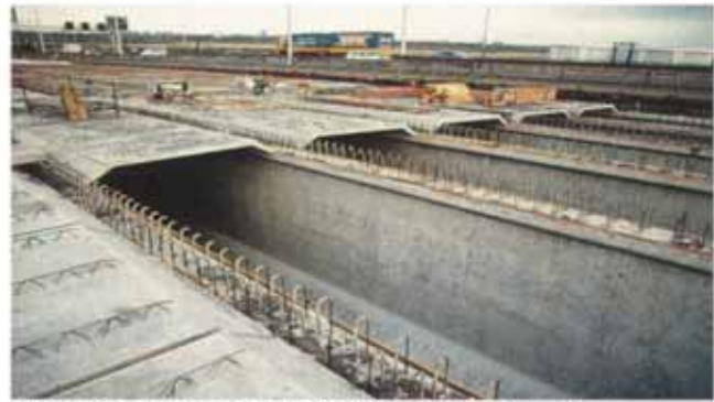
Bild 12. Vorgefertigte Spezial-Überbauplatten für die Brücke
