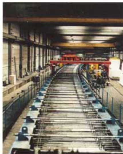
Bild 21 b. Der „Hohlraum“ des Kastenträgers wird durch Polystyrolblöcke erzielt Fig. 21 b. Polystyrene blocks positioned to create the "hollow" part of the box-girder Fig. 21 b. Blocs de polystyrène disposés pour créer la -partie creuse- de la poutre-caisson
