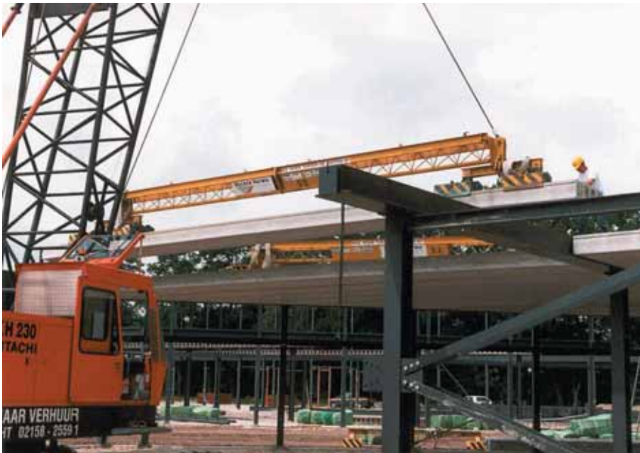
Foto 1.023: Stalen hoedligger en kanaalplaat
