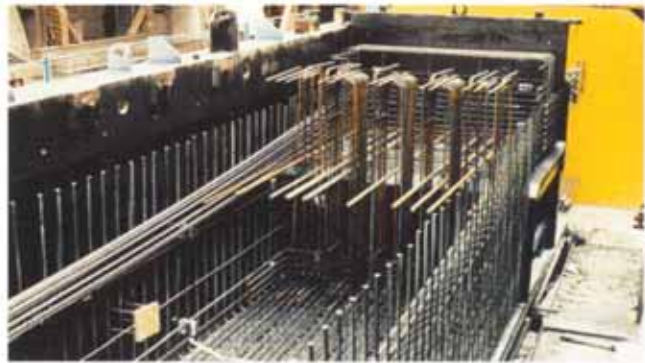
Bild 21 a. Bewehrung und Vorspannung am Ende des Kastenträgers Fig. 21 a. View of the reinforcement and prestressing at the end of the box-girder Fig. 21 a. Vue de l'armement et de la précontrainte à l'extrémité de la poutre-caisson
