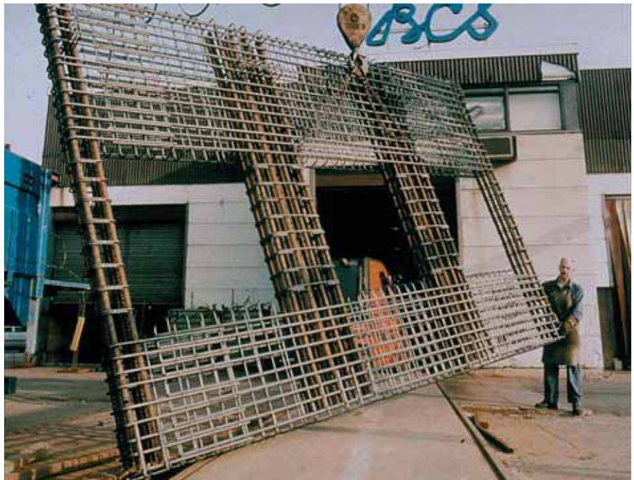
Foto 2.011: Een compleet net wordt aangevoerd. Dekkingringen moeten nog worden aangebracht
