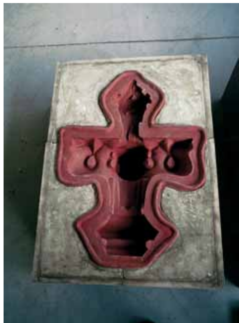
12 | Bekistingsdetail in polyurethaan voor het gebouw van foto 11
