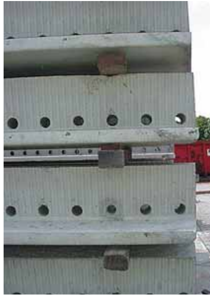
Foto 2.062: Brugliggers voor de uitvoering van een massief dek. De gaten in het lijf zijn voor het doorvoeren van wapeningstaven in dwarsrichting van de brug. Voor de samenwerking van deze voorgespannen prefab balk en de in het werk te storten betonlaag, tussen en tot ca 150 mm boven de prefab balk, is het lijf aan weerszijden geprofileerd
