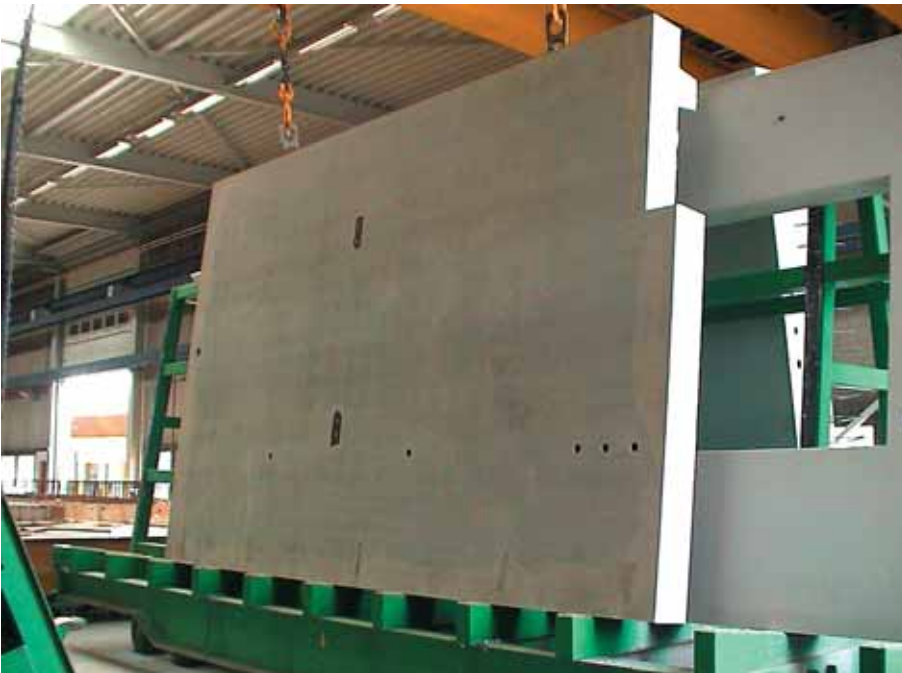
Foto 2.058: Het element wordt nu gelicht door de halkraan
