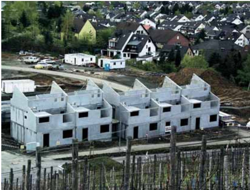
1 | Overzicht woningcasco's bestaande uit prefab betonelementen
