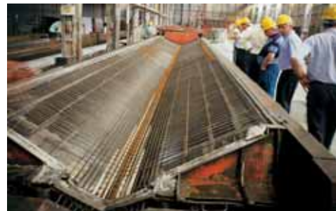
3 | Wapening in de mal van de dakligger van foto 2
