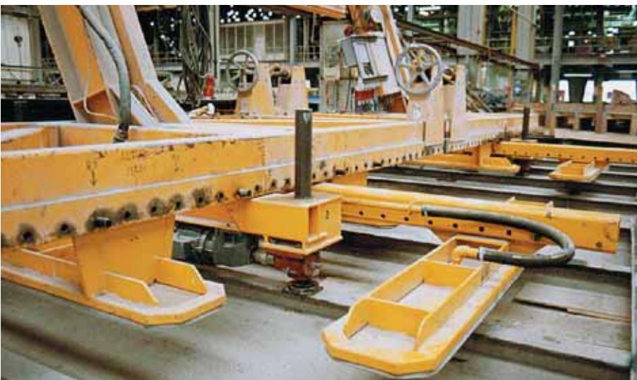
Foto 2.052: Vacuümzuiger voor het optillen van een vlak element. Door de aanwezigheid van meerdere zuigers worden de krachten in het element verdeeld en gespreid. Vooral voor gewapende elementen van belang om scheurvorming in het nog jonge beton te voorkomen
