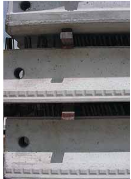
Foto 2.065: Het hijsgat aan de kop van de liggers is duidelijk waarneembaar. Verder is de zijkant van de zool van de ligger geprofileerd om na het vullen van de voeg tussen twee liggers, een schuifkrachtoverdracht te kunnen realiseren. Gaat werken bij geval van het aanrijden van de brug
