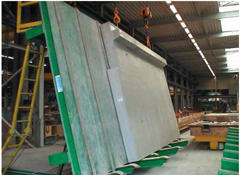
Foto 2.056: Een wandelement op een stalen tafel is geplaatst op een kantelframe, waardoor het wandelement in verticale positie wordt gezet en de wand niet behoeft te worden gewapend op het eigen gewicht + kleefkrachten tijdens het in horizontale stand hijsen. Dit scheelt nogal wat wapening. Het hijsmiddel, een stalen bout op de kritieke doorsnede, wordt tevens gunstig belast, namelijk op trek en niet op dwarskracht
