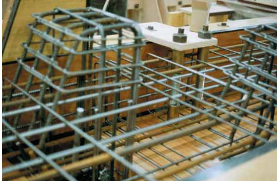
Foto 2.010: Wapening voor een kolom met consoles, ingebouwd in de mal. Vormvastheid en maatnauwkeurigheid van de wapeningskooi zijn vereist. Daarom worden de kruispunten van de staven gelast
