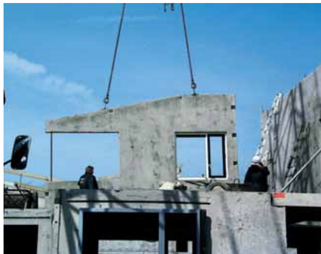
1 | Overzicht woningcasco's bestaande uit prefab betonelementen
