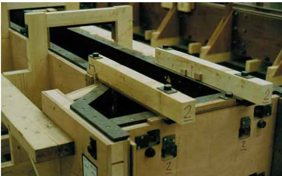
Foto 2.022: Op de linkerkant van de foto is duidelijk te zien dat de zijde van de mal is opgebouwd uit een laag triplex, een vulling van naaldhout en weer een triplexlaag; al deze lagen zijn onderling gelijmd. De stijfheid wordt daardoor hoger, zodat de strakheid van het element is gewaarborgd bij voldoende verstijvingen
