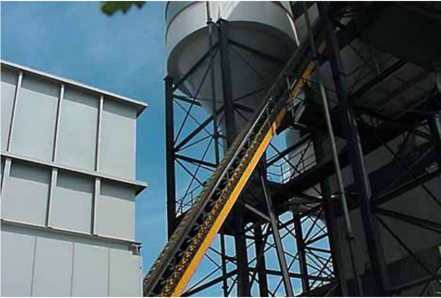
Foto 2.034: De opvoerband om zand of grind van het opslagvak naar de dagsilo te transporteren
