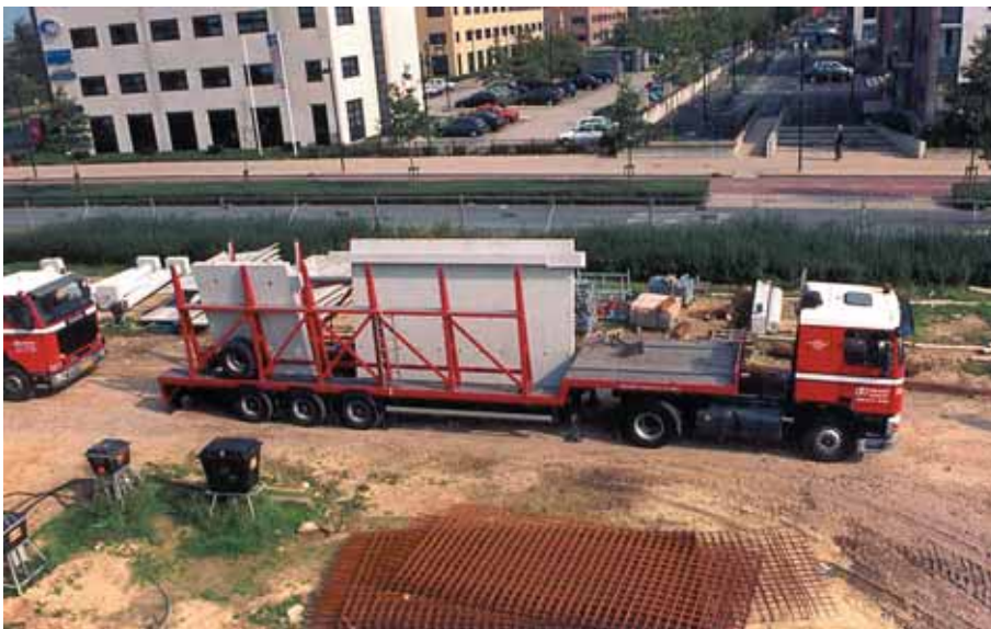
Foto 2.066: Wandelementen op dieplader arriveren op de bouwplaats. Zie de speciale frames om de wanden te kunnen vervoeren. Laadbaar links en rechts tegen het frame, dat wat hellende zijkanten kent, zodat het element altijd achterover blijft leunen
