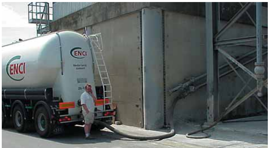
Foto 2.033: Cementwagen pompt het cement in de silo
