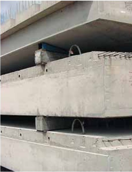
Foto 2.061: Detail van de ondersteuning, die verticaal boven elkaar moet liggen. De ingestorte hijsstropen zijn goed waarneembaar. Aan het einde steekt wapening uit voor de te maken buigslappe voeg in het brugdek bij de opleggingen. Verder zijn de in dwarsrichting van de balk de gaten voor de dwarsvoorspanning aangebracht. De dwarsvoorspanning is een naspanning, die na de montage wordt aangebracht, waarna het spankanaal wordt geïnjecteerd
