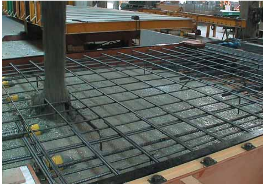
Foto 2.047: Storten van een vloerelement, hier met zelfverdichtend beton
