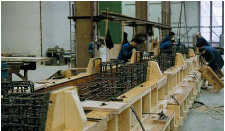
Foto 2.016: Houten mal voor een kolom in een hellingbaangarage. De plaats van de console verschilt per kolom. De hellingbaan gaat via de ene console omhoog, via de andere naar beneden
