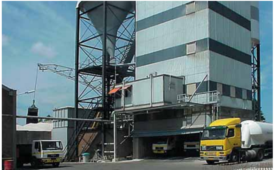
Foto 2.032: Cementwagen voert cement aan
