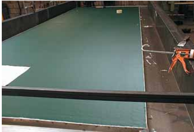
Foto 2.019e: Vloer wordt gecoat om loopweerstand te vergroten
