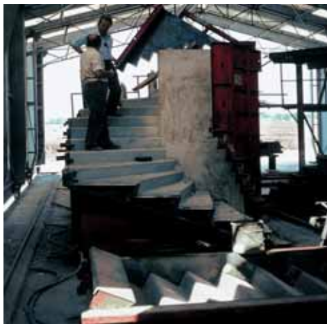
5 | Spiltrapelement wordt ontkist
