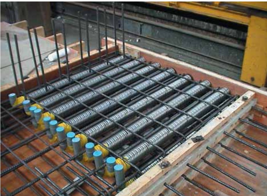
Foto 2.046: Een extreem aantal omhullingsbuizen is in het element aangebracht. Deze buizen dienen de ruimte te scheppen voor de stekken van het element op de laag daaronder gemonteerd. De omhullingsbuizen dienen dus bijzonder nauwkeurig te worden gesteld en moeten tijdens het storten plaatsvast blijven
