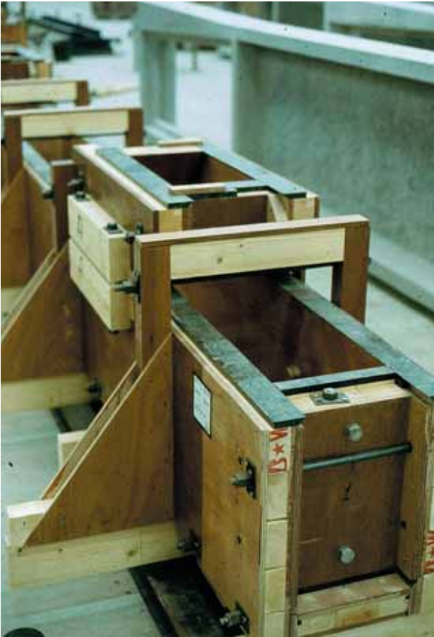
Foto 2.024: Houten mal voor een kolom waarbij de zijden zijn afgeschoord middels driehoeken van triplex. Daarmee is de haaksheid van de mal te handhaven
