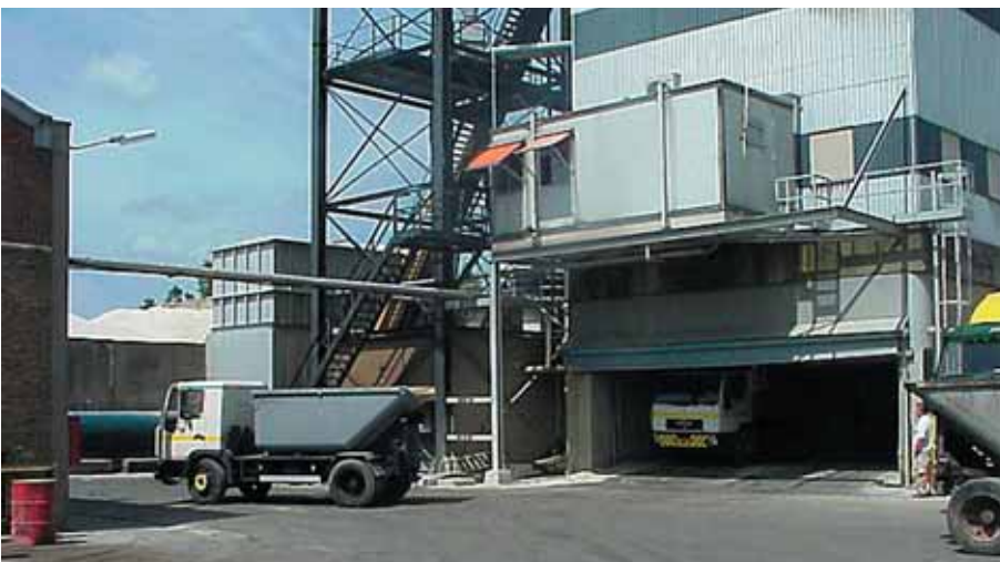
Foto 2.036: Betonspecie wordt vervoerd met kleine open wagens naar de diverse productiehallen
