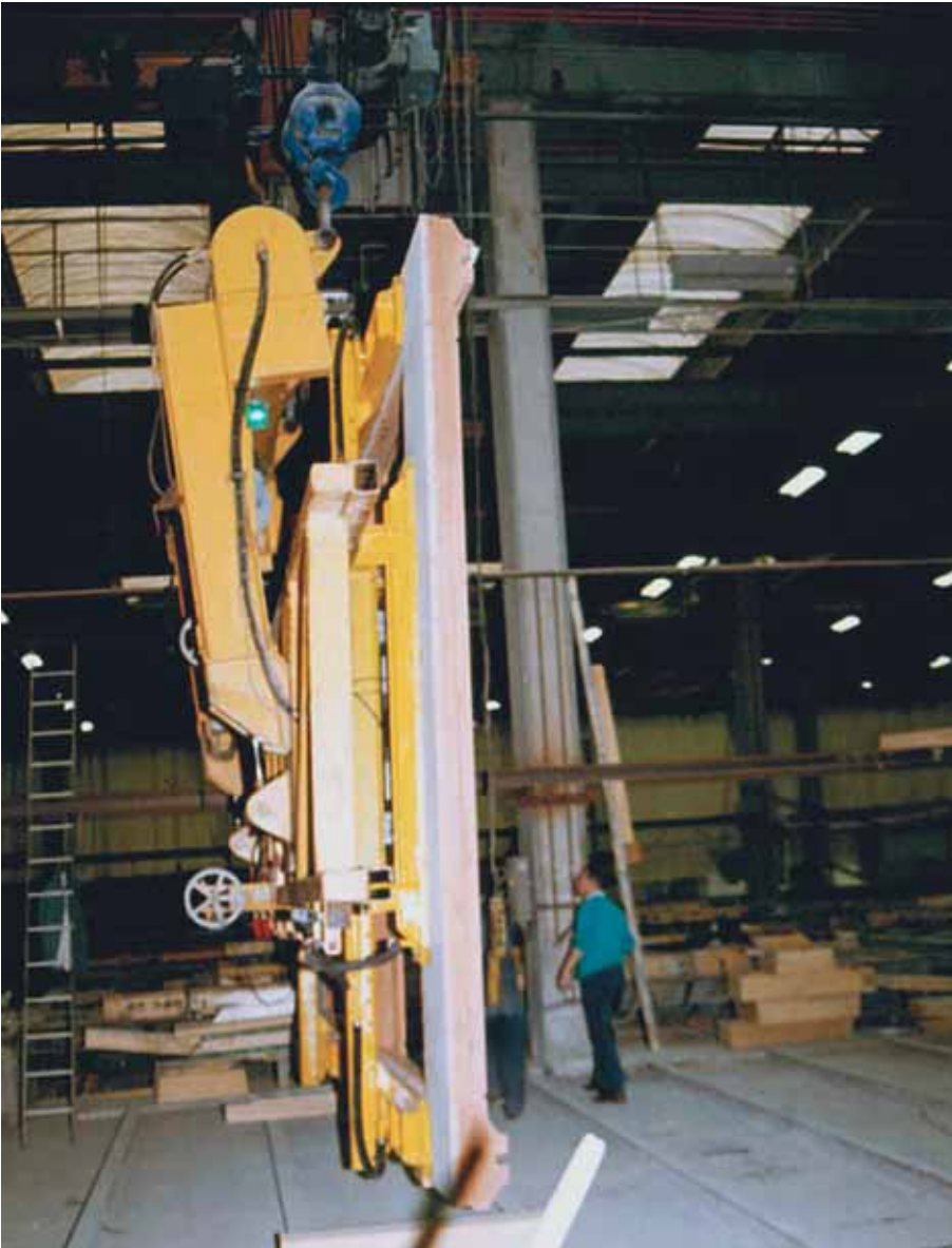
Foto 2.055: Het element is nu gekanteld en zal nog een aantal uren in de hal verblijven om een geleidelijke afkoeling te ondergaan en veel vochtverlies te voorkomen
