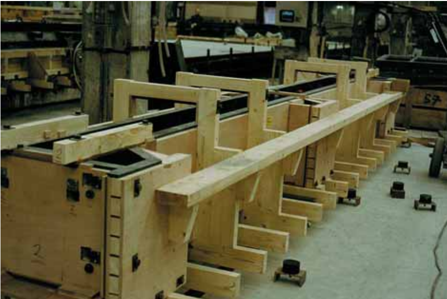
Foto 2.009: Een verplaatsbare mal; een mal voor een kolom met consoles
