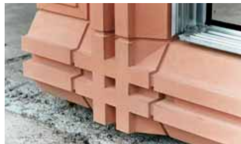
8 | Detail van een betonelement vervaardigd in de mal van foto 7
