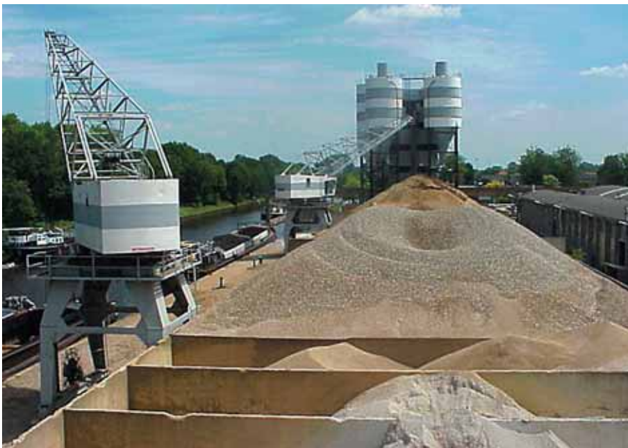
Foto 2.029: Aanvoer en opslag van zand, aangevoerd per schip. Gescheiden opslag van materialen is een voorwaarde. De opslag vindt plaats in vakken. Op de achtergrond de dagsilo's en de betonmenginstallatie
