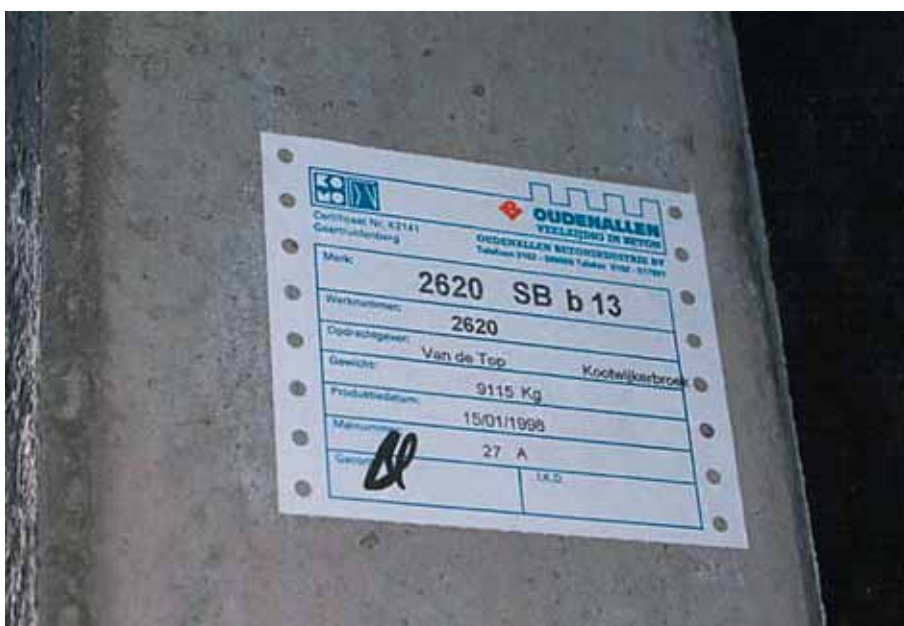
Foto 2.013: Element met een unieke aanduiding; werknummer, merk, opdrachtgever, gewicht, productiedatum, paraaf kwaliteitscontroleur zijn op de label van de producent aan te treffen.
