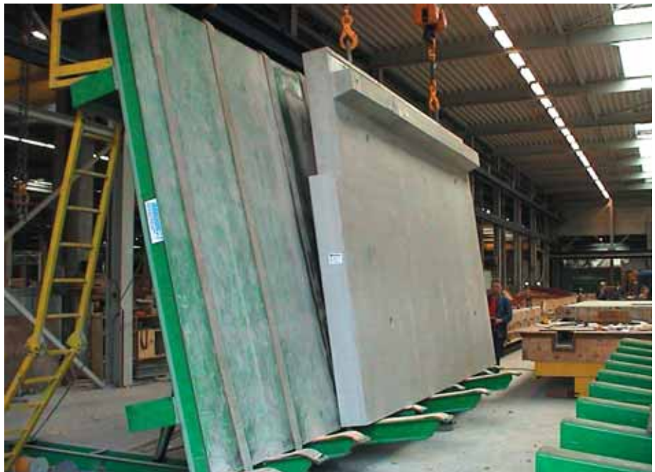
Foto 2.057: Het element wordt nu in verticale positie gebracht
