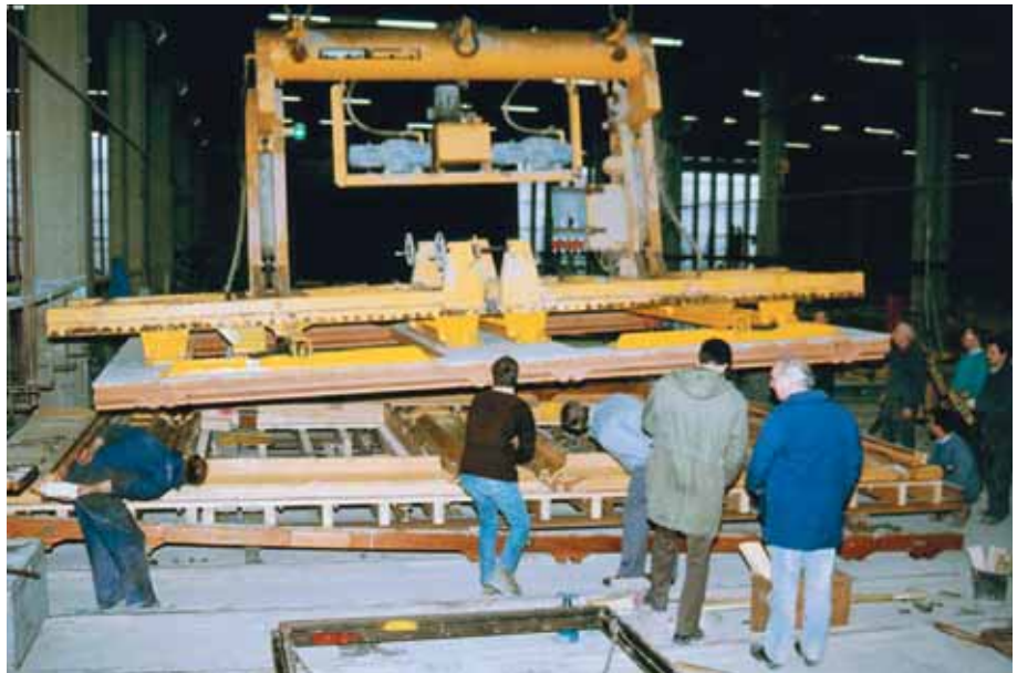
Foto 2.053: Het element is los van de mal en kan nu worden gekanteld. Dan kan het element in verticale positie worden opgeslagen op het tasveld. Het eigen gewicht speelt in verticale positie geen rol van belang meer. Elementen die horizontaal worden getransporteerd en opgeslagen dient men vaak extra te wapenen om scheurvorming te voorkomen of te minimaliseren
