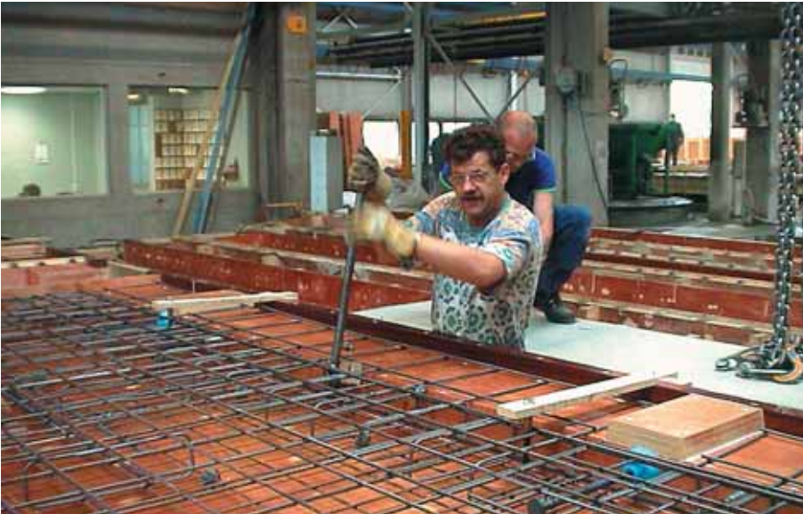
Foto 2.045: Even wrikken om het net precies te plaatsen ten opzichte van de in te storten voorzieningen. Zie de dekkingsringen om de staven. Voor in te storten voorzieningen in het bovenvlak, de afwerkzijde, moeten uithouders op de malrand worden bevestigd waardoor de invoeger op de juiste positie kan worden aangebracht, zowel in X-, Y-, als Z-richting
