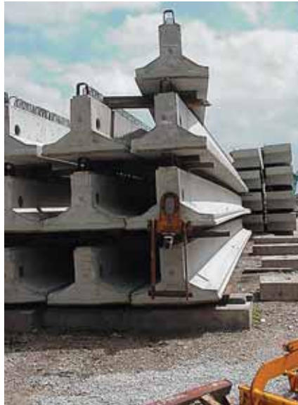
Foto 2.064: Stapeling van brugliggers. Op deze liggers wordt, nadat verloren bekisting in het bovenvlak van de liggers is aangebracht, een dek gestort, zodat uiteindelijk de constructie bestaat uit een schakeling van I-vormige doorsneden. Ten behoeve van de schuifkrachtoverdracht in het contactvlak, brugligger en dek, steekt er beugelwapening uit. Een sponning bovenin is te zien, bedoeld voor het opleggen van de (verloren) bekisting
