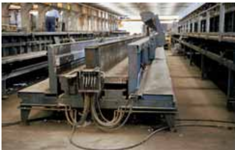
1 | Bekisting voor het langebanksysteem, met verplaatsbare malbodem en zijschotten
