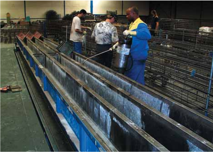
Foto 3.121: Malzijden voorzien van ontkistingsolie
