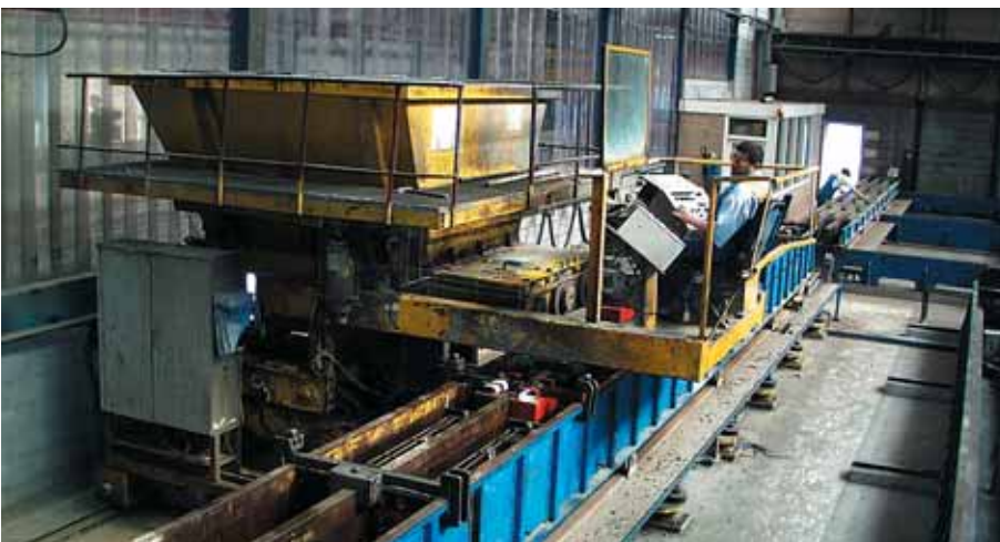
Foto 3.018: De stortmachine rijdt langs de mal. De hoeveelheid te storten betonspecie wordt door middel van een schroefworm gedoseerd. De storter is hier operator. Hij positioneert de kubel met het knoppenpaneel en regelt tevens hoeveel betonspecie daar wordt gestort
