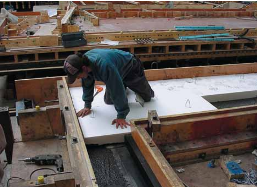
Foto 3.192: Op de buitenschil van zwart beton worden PS-isolatieplaten aangebracht
