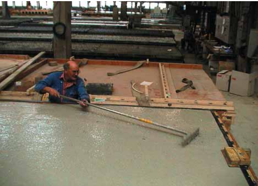
Foto 3.156: Het element is gestort met ZVB; even de hark erin om het oppervlak te nivelleren
