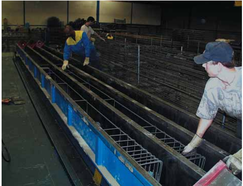
Foto 3.123: Wapening in de mal plaatsen
