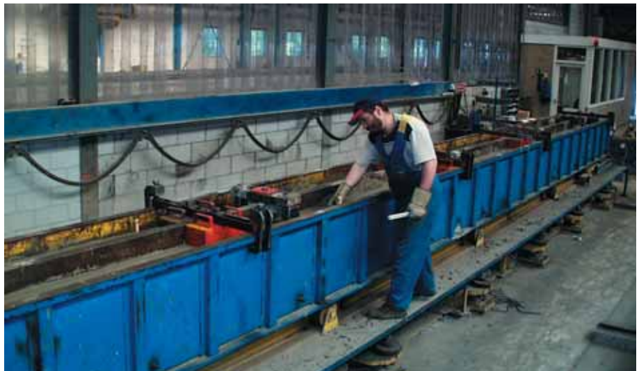
Foto 3.021: Afwerken, gewoon gladstrijken van de bovenzijde van de balk waarop later vloerelementen vlak moeten worden ondersteund
