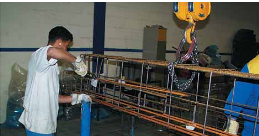
Foto 3.006: De wapening van de balk is goed waar te nemen; de wapeningshaarspelden in de tand lopen door tot onder de takel. De bovenstaven zijn omgezet naar beneden om de verticale kracht van de tand over te kunnen brengen naar de balk zelf. De afstandhouders of dekkingblokjes worden aan de wapening bevestigd
