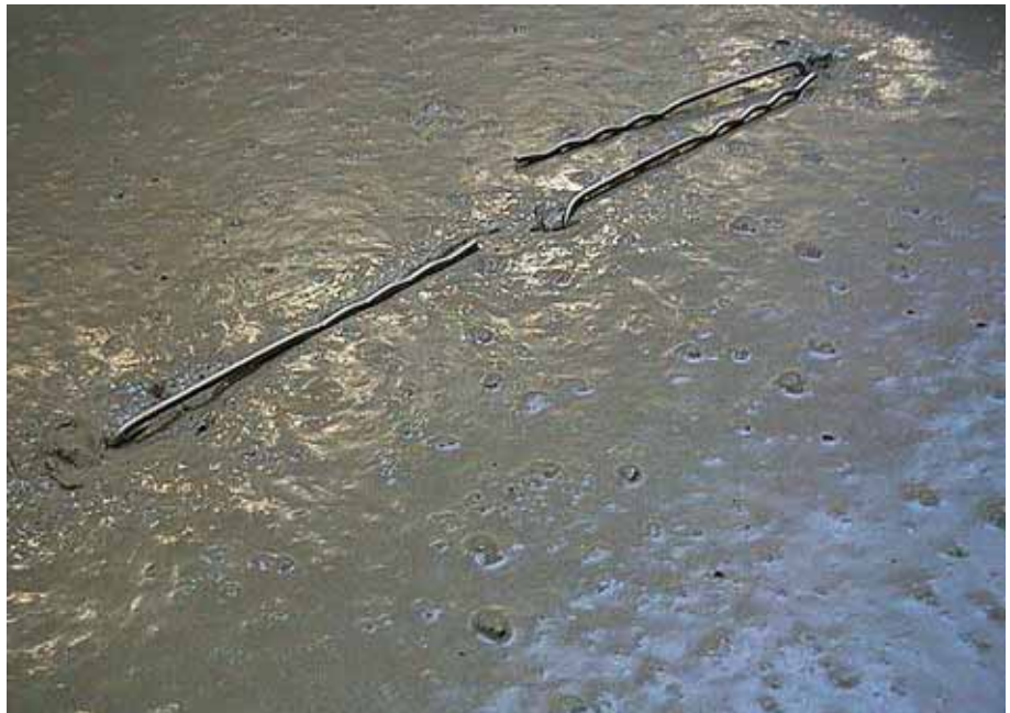
Foto 3.158: Een niet verder afgewerkt oppervlak van een element, gestort met ZVB, voorzien van spouwankers
