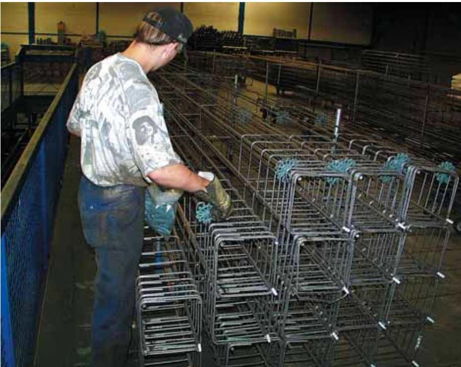
Foto 3.122: Wapening voorbereiden; afstandhouders en blokjes plaatsen
