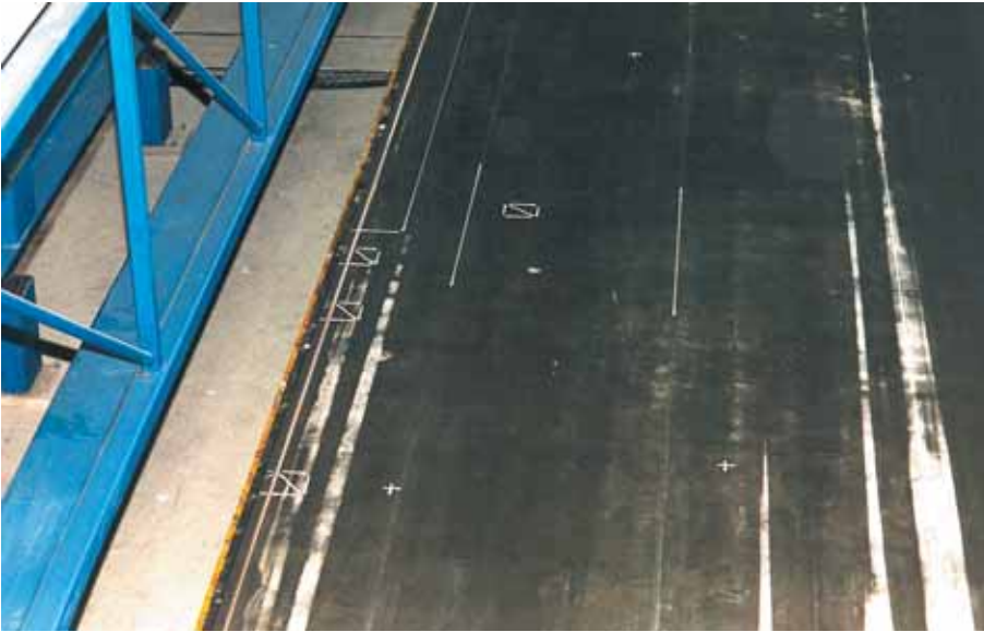
Foto 3.082: De tafel wordt gereinigd en van een filmpje bekistingolie voorzien
