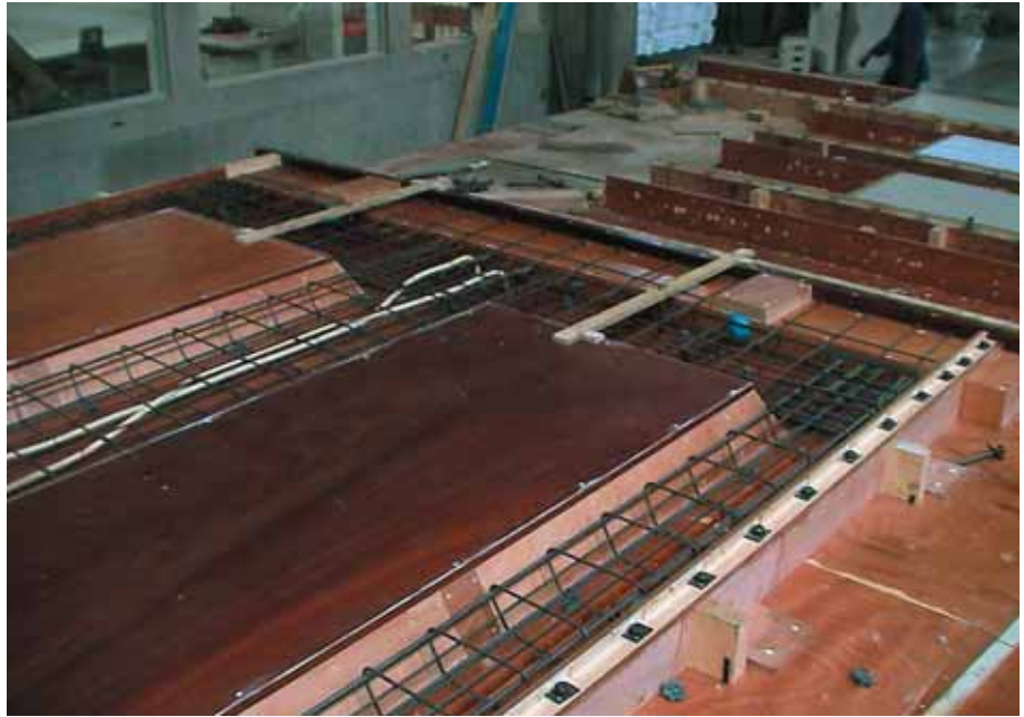
Foto 3.153: Wapeningnet voor een element met twee raamsparingen
