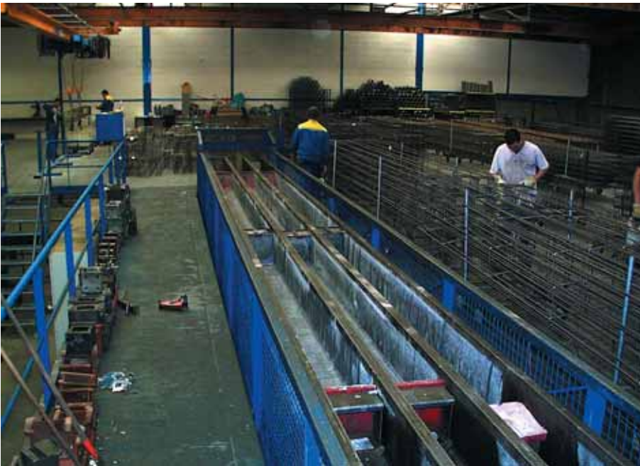
Foto 3.118: Mal op inbouwstation
