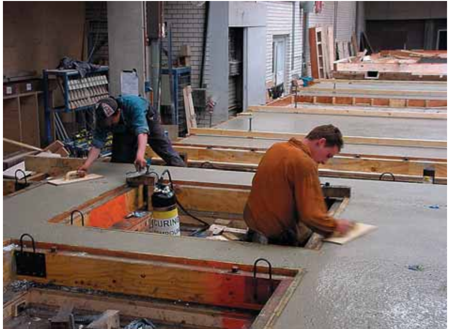
Foto 3.197: Afwerken van het betonoppervlak; dit is straks de aanzichtzijde van het binnenblad!
