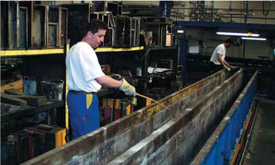
Foto 3.010: Aanbrengen van bekistingolie, om een scheiding te behouden tussen mal en verhard beton
