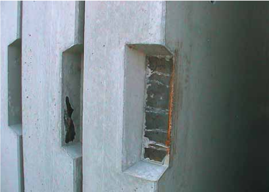
Foto 3.167: Lasplaten ingestort, verdiept, om een gelaste verbinding van wanden tot stand te brengen
