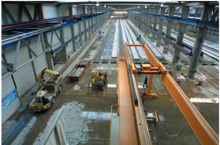
Foto 3.053: Overzicht van de enorme hal. Meerdere banen naast elkaar, die veelal om en om worden gestort. De betonspecie wordt aangevoerd via de kubelbanen. De zijlader staat links. De afvalcontainers zijn deels al gevuld met brokstukken beton. Een aantal banen is afgedekt. Men kan de verankerde strenggeinden hier en daar waarnemen
