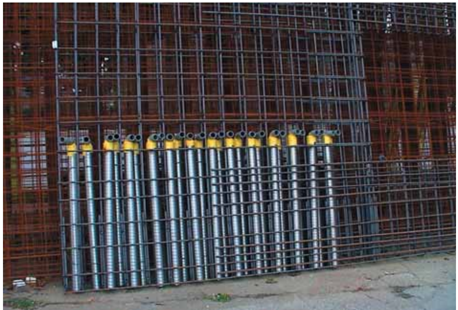
Foto 3.142: Een bijzonder zwaar wapeningsnet is gereed op de tas aanwezig. Op afroep beschikbaar
