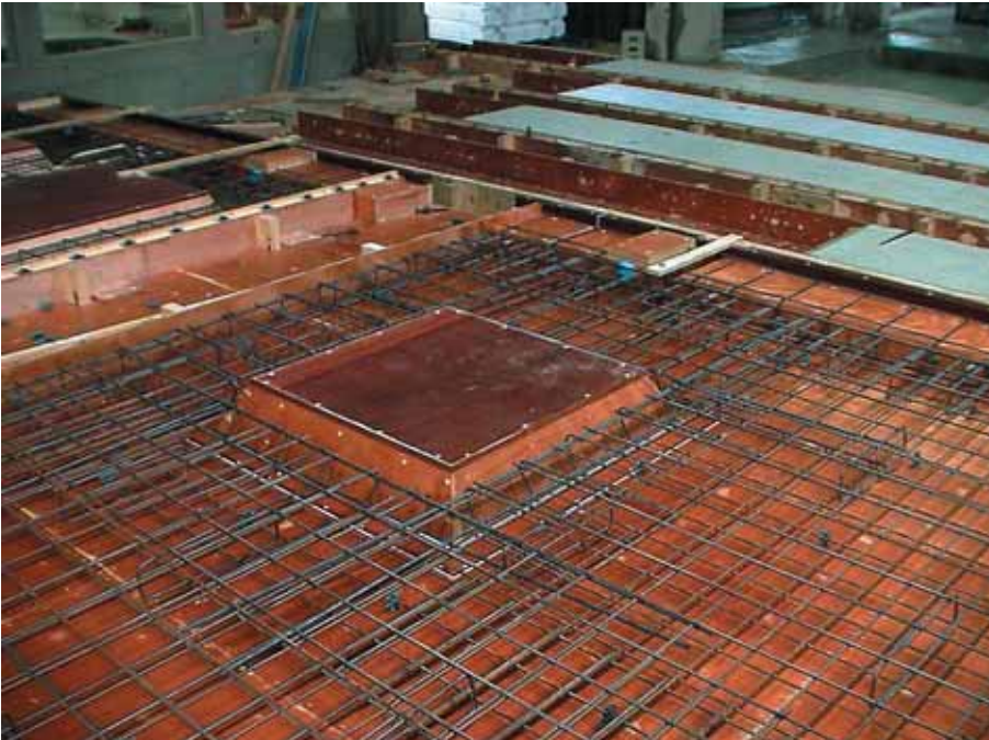
Foto 3.151: Soms is het wapeningnet heel normaal van samenstelling, zoals bij dit element
