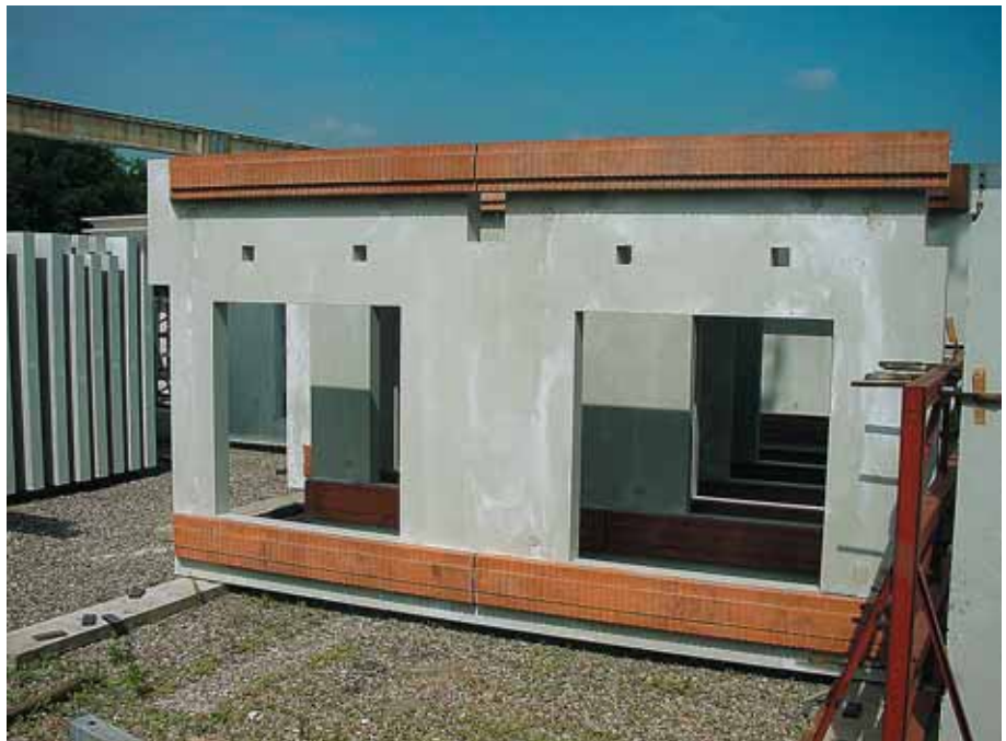
Foto 3.206: Een ander gevelement met een kunstmatige steenlaag van gekleurd beton
