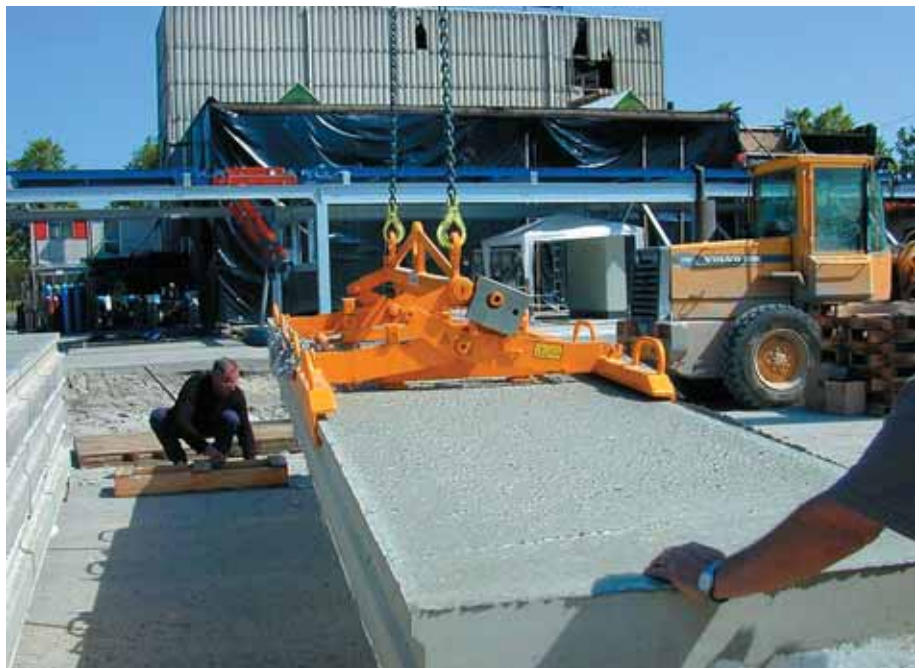
Foto 3.074: De onderstopping wordt aangebracht
