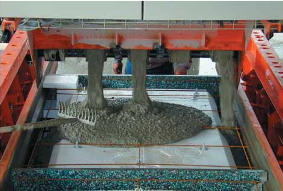
Foto 3.067: Ingezoomd op het storten met ZVB, zelfverdichtend beton. Drie kleppen open van dit prototype
