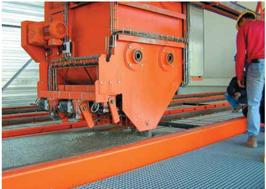
Foto 3.066: Zelfverdichtend beton storten met twee kleppen open. De stortmachine is CAD-CAM-gestuurd en dient in één arbeidsgang op elke plaats de vereiste hoeveelheid betonspecie te doseren. Door de ribvorm is aan de zijanten van de plaat meer betonspecie nodig, dus moet die klep meer open dan de andere
