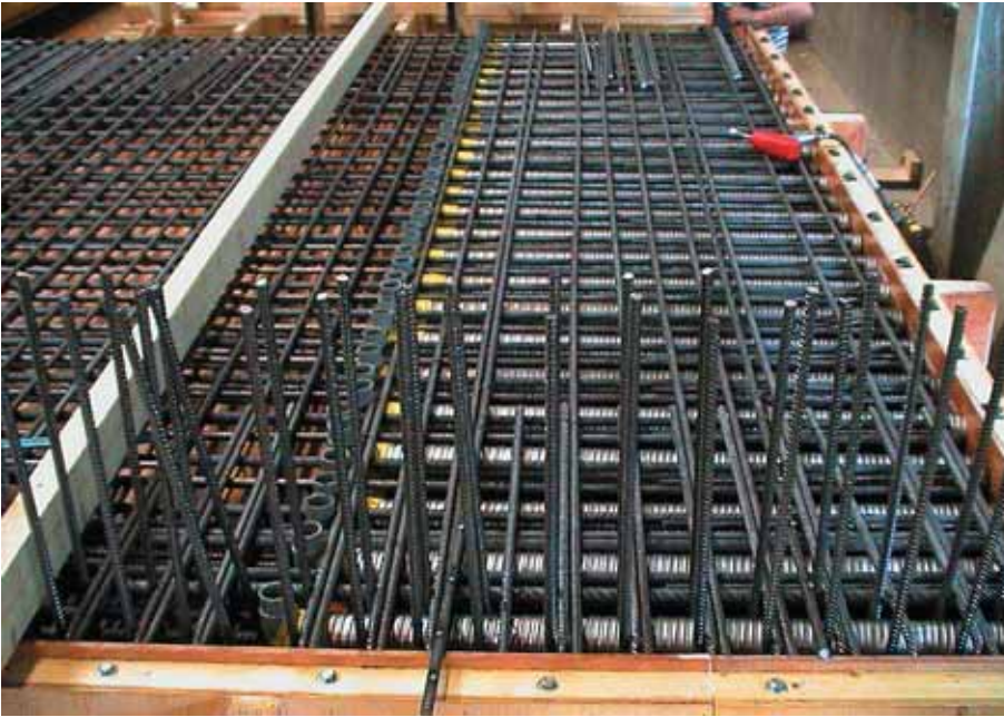
Foto 3.147: Het wapeningnet is geplaatst, de voorzieningen aangebracht
