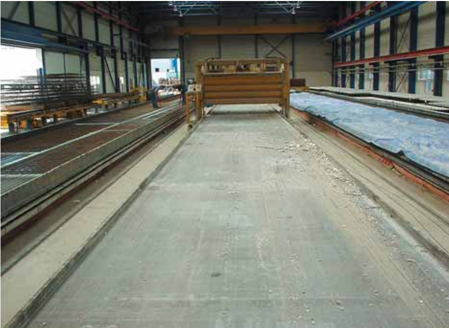
Foto 3.171: Veegmachine in actie, baan schoonmaken
