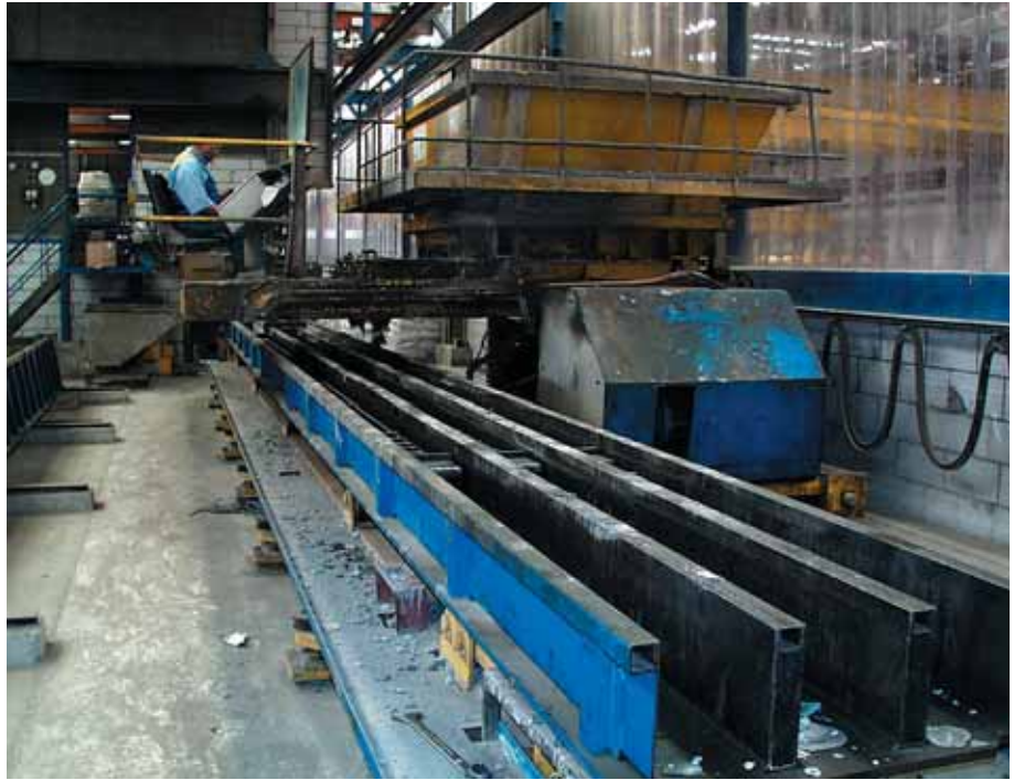
Foto 3.127: Mal staat nu op de stortpositie. De operator kan nu de mallen vullen met betonspecie
