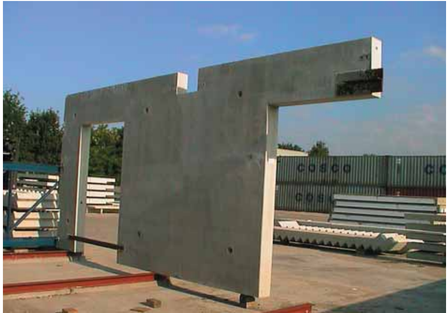
Foto 3.165: Wandelement met deuropening en uitkragende balk
