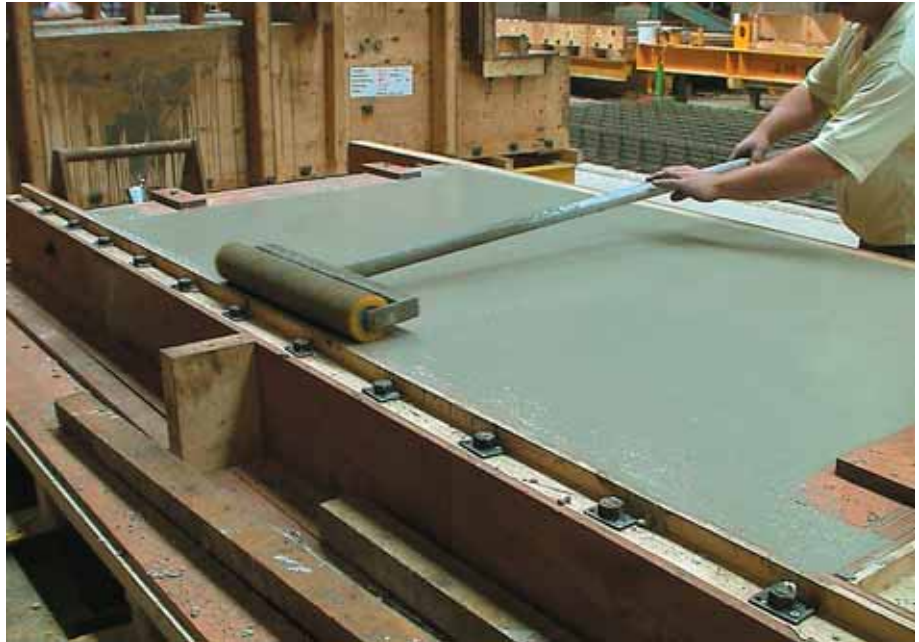
Foto 3.157: Na het storten volgt het afwerken, zoals rollen of schuren of glad maken. Hier rollen
