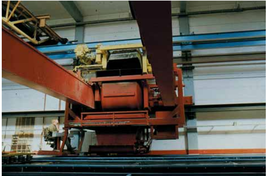
Foto 3.034: Vanuit de mengcentrale wordt via de kubelbaan de betonspecie aangevoerd. Boven de stortmachine is de kantelkubel te zien, die door het uitgezonden signaal van de stortmachine is gestopt en zijn inhoud leegt in de hopper van de stortmachine. De storter kan de betonspecie zeer nauwkeurig over de vier maldelen verdelen. De betonspecie wordt door de vier schroeven naar de klep gestuurd. De storter kan elke klep apart openen en sluiten
