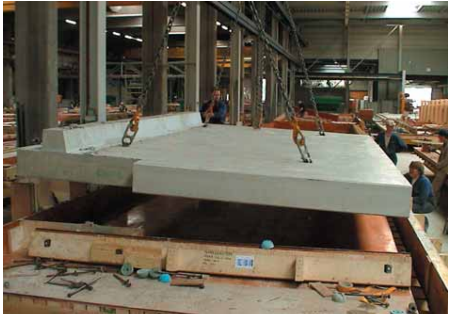
Foto 3.161: De wand hangt aan de vier hijsankers
