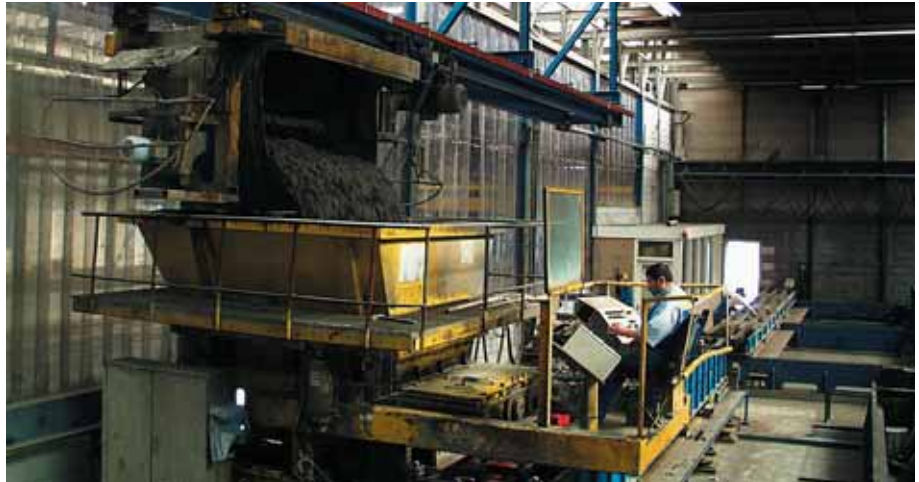
Foto 3.019: Overladen van de betonspecie vanuit het betontransportsysteem. De kantelkubel wordt geleegd in de hopper van de stortmachine. De kantelkubel gaat dan weer terug naar de betonmolen om een nieuwe lading en bestemming te krijgen.
