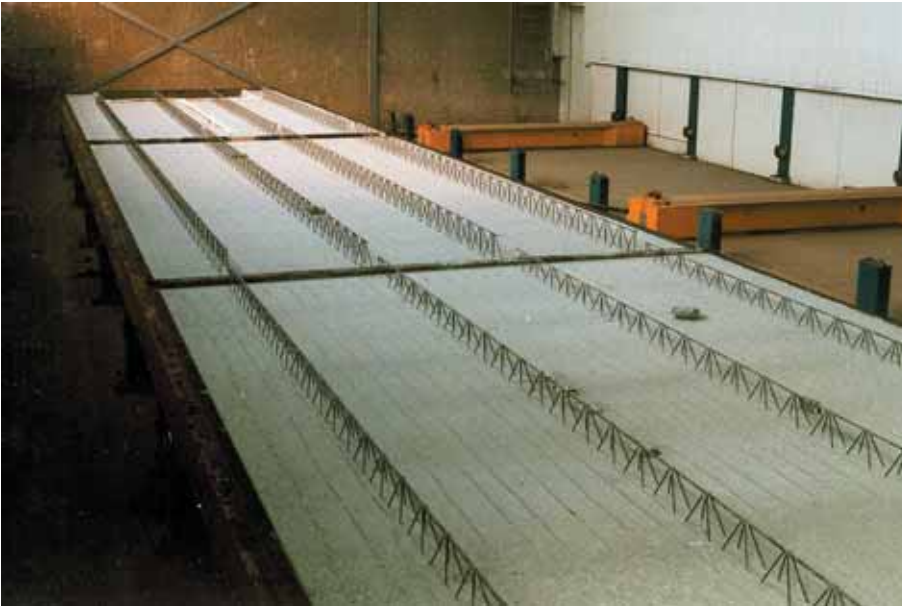
Foto 3.078: Op de tafels van 3 x 18 m 2 kunnen meerdere platen worden gestort. Deze tafel met platen komt uit de verhardingkamer en moet nu worden geleegd
