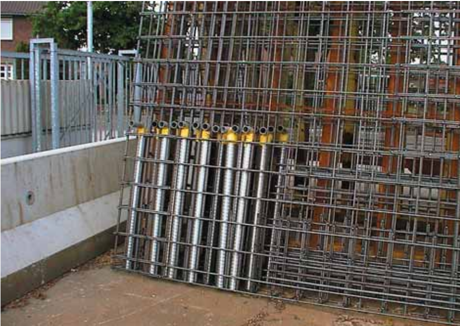
Foto 3.143: Een ander net op voorraad waarbij de omhullingsbuizen ook al vooraf zijn aangebracht
