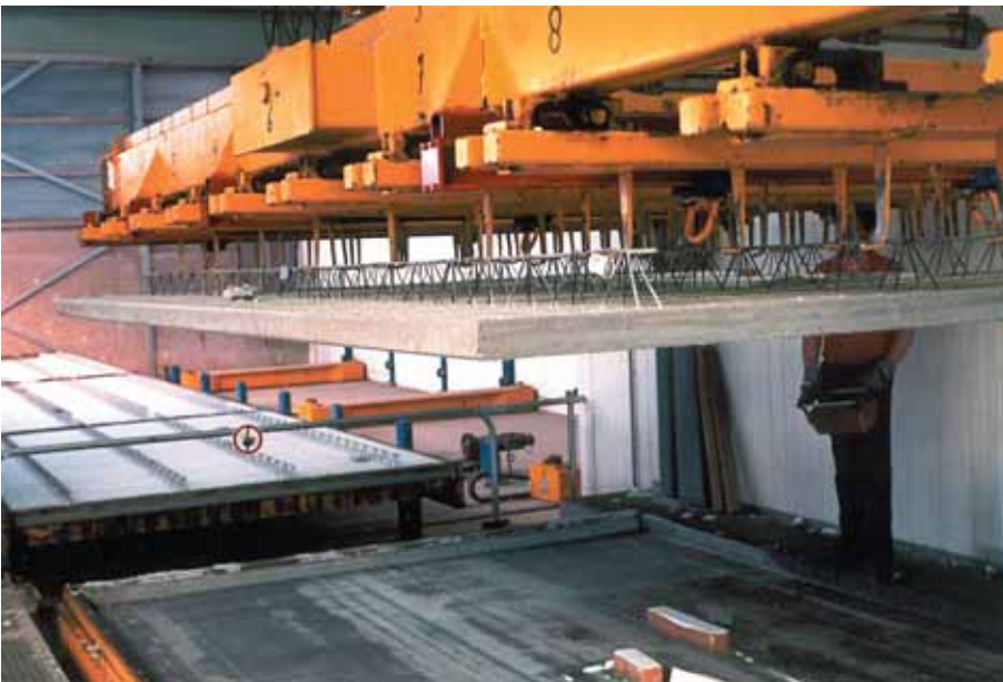
Foto 3.079: Het element wordt van de tafel gelicht aan de bovenstaven van de tralieligger. Om de kracht te verdelen zijn er veel hijspunten per tralieligger aanwezig. In de hal wordt bij het ontkisten reeds voorgesorteerd
