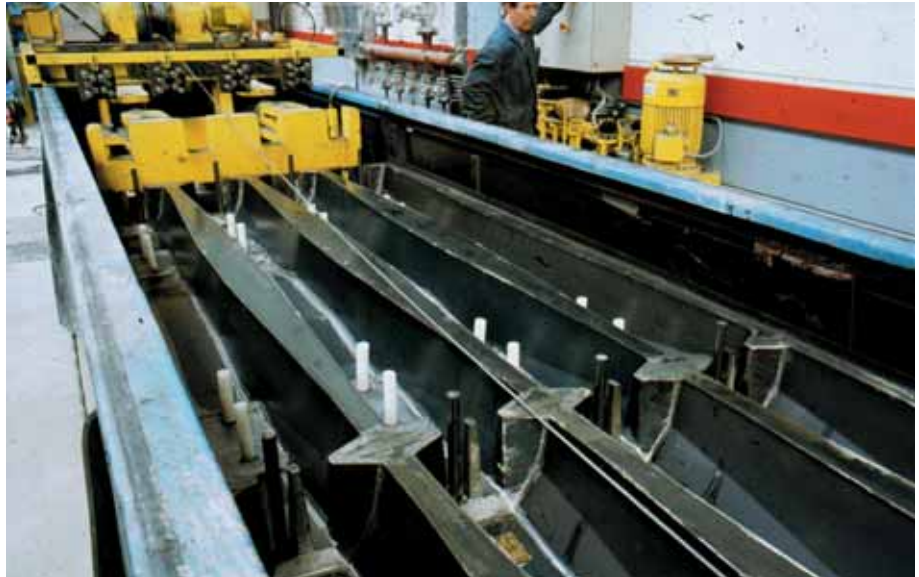
Foto 3.030: De schoongemaakte en van pluggen voorziene mal is nog in de lage positie. De werkbaas bedient de knop om de mal omhoog te brengen. De kar met eindschotten en gewigde strengen is goed te zien
