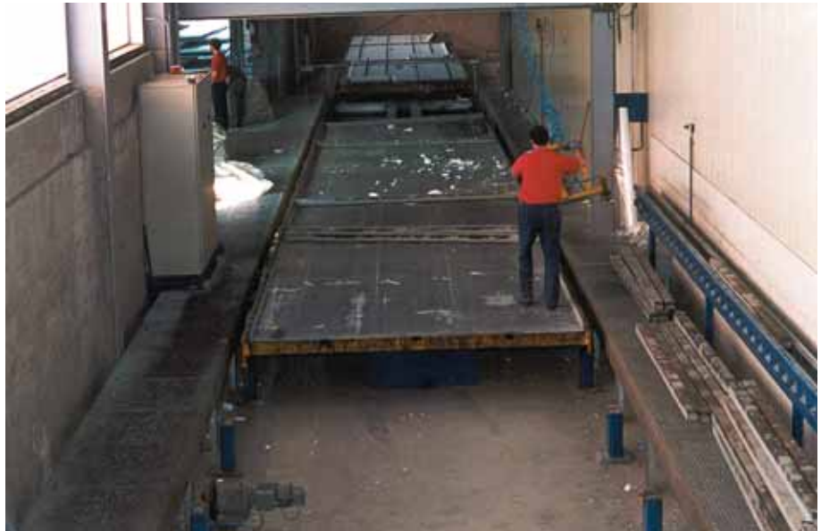
Foto 3.081: De dekplaten zijn verwijderd. De zij- en kopranden worden nu van de tafel getild
