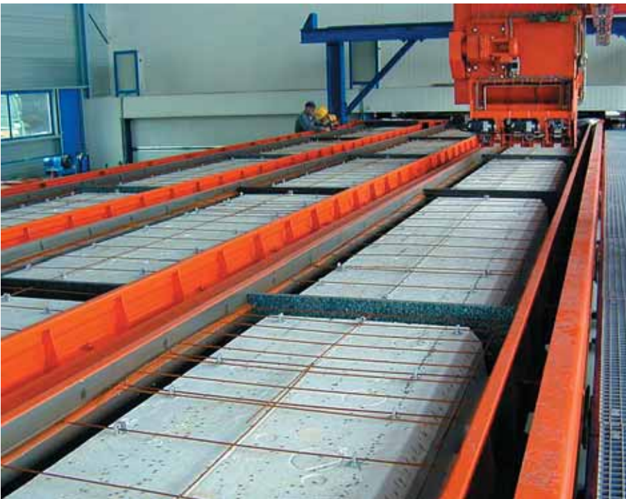
Foto 3.064: Dekwapening en voorspanwapening zijn aangebracht. Kubel rijdt naar achteren
