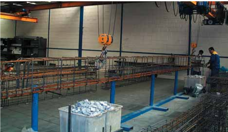
Foto 3.005: Wapeningvoorbereiding: het net hangt aan een takel en rust op steunen. De vlechter kan nu op een ergonomisch geschikte hoogte werken en kan er rondom bij
