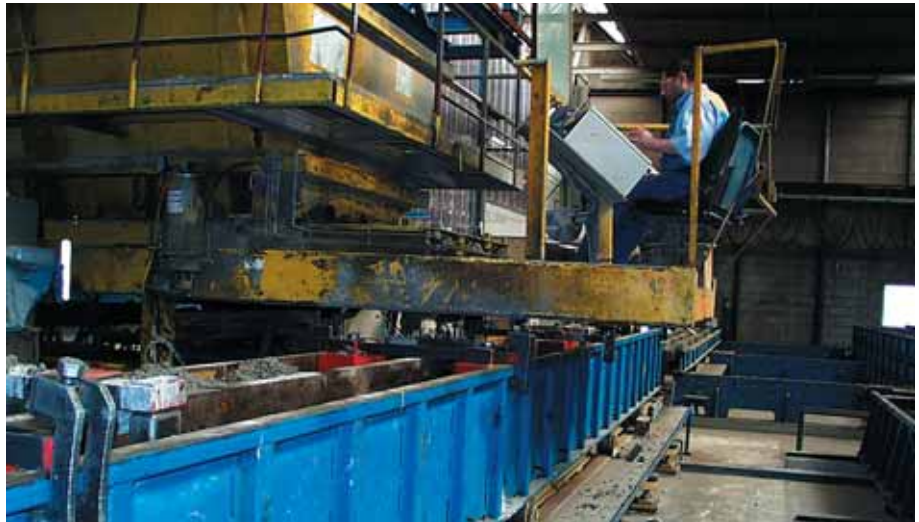
Foto 3.020: Een deel van de betonspecie is gestort. Na het trillen, afstrijken, afdekken en gedurende 12 tot 16 uur verharden, begint de cyclus opnieuw.
