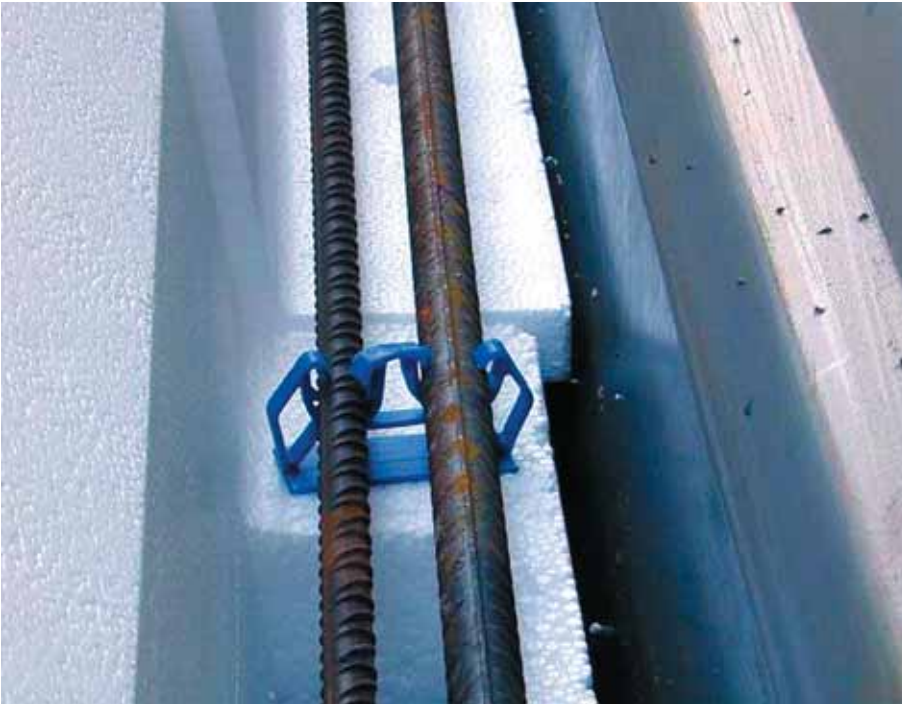
Foto 3.063: Afstandhouder voor de wapening. Sparing voor 'harde' oplegging
