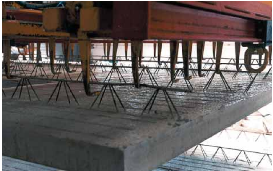
Foto 3.080: Hijsactie in detail. Bovenstaaf vervormt iets
