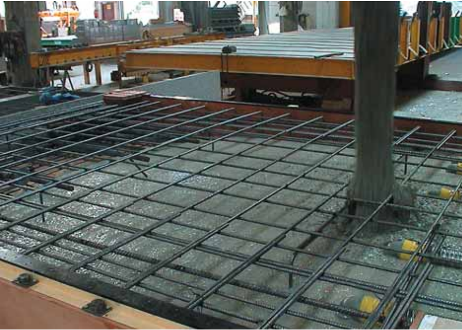
Foto 3.155: De wand wordt gestort. Niet meer trillen: ZVB vloeit redelijk uit, maar ontmengt niet
