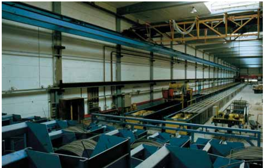
Foto 3.035: De baan wordt na het storten afgedekt en iets verwarmd. Het beton is na 7 tot 12 uur op ontspansterkte. In de rechterbaan is de mal inmiddels in de lage positie gebracht. In de linkerbaan hangen de vier stuks palen van 35 dwarsliggers in rollen op weg naar de plaats waar er steeds vier tegelijk worden doorgezaagd
