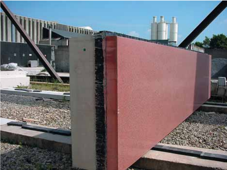
Foto 3.207: Een borstwering in sandwich, gekleurd beton en gepolijst
