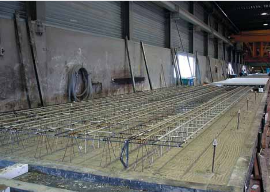
Foto 3.175: De A-schil gereed, inclusief de wapening voor de B-schil
