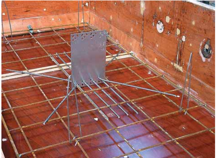
Foto 3.189: Hier nog een gemonteerd plaatanker. De dikte van de RVS-plaat is gering, de stijfheid laag, zodat vervormingen door temperatuur en krimp mogelijk blijven, zonder veel krachten op te wekken
