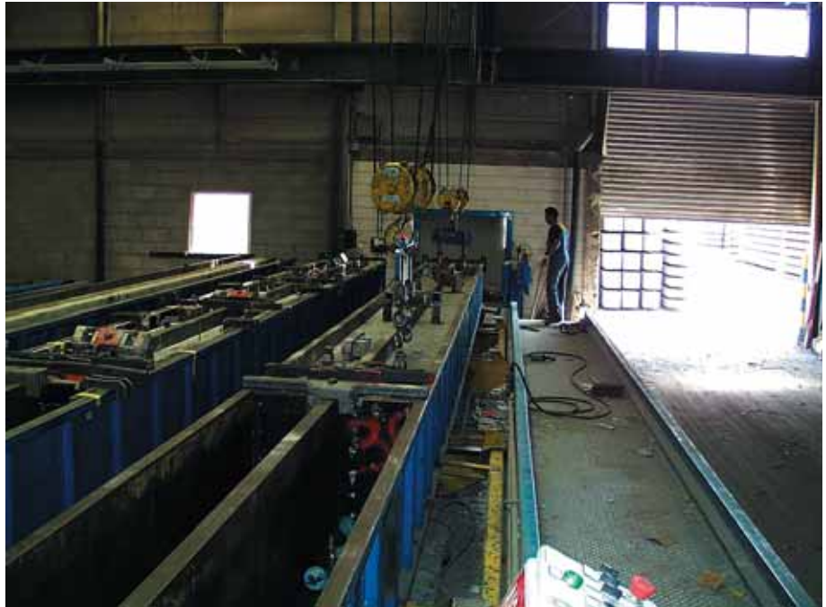
Foto 3.002: Het start met het voorbereiden van het ontkisten van de balk, die inmiddels 12 tot 16 uur oud is en een kubusdruksterkte van 25 MPa heeft bereikt en daardoor scheurvrij ontkistbaar is. De koppelingen van de zijschotten van de mal zijn al verwijderd, zie ook foto's 3.012 en 3.016
