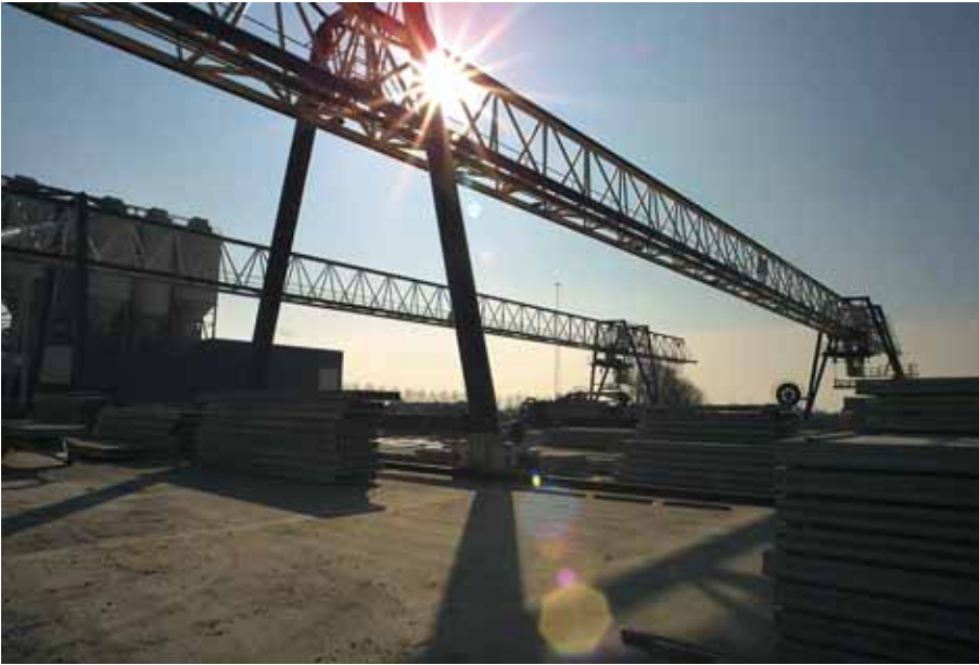
Foto 3.058: Sfeeropname als het later wordt, de twee kranen in rust. Betoncentrale op achtergrond
