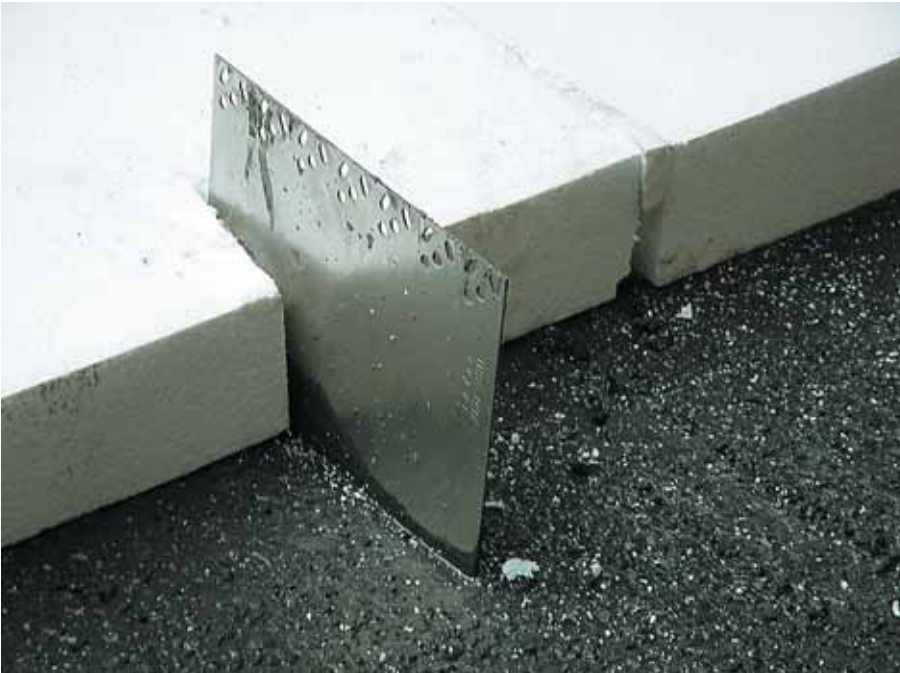
Foto 3.191: Een plaatanker in detail, de doorvoermogelijkheden voor wapeningstaven zijn groot. Soms worden de plaatankers als drager gebruikt en worden lusvormige koppelstaven toegepast. Hier steekt het anker uit de buitenschil van zwart beton, waarop al deels PS-platen zijn aangebracht
