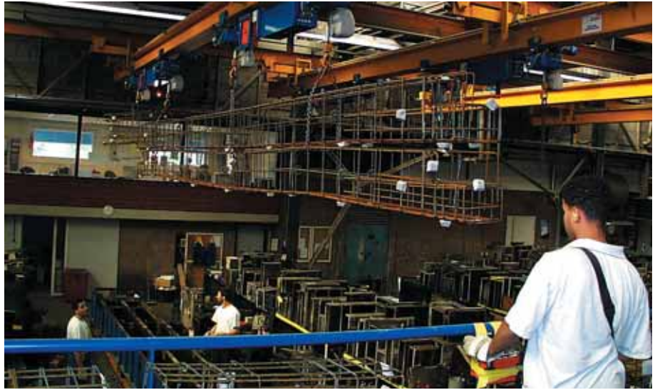
Foto 3.013: Wapeningkooien op transport naar de mal
