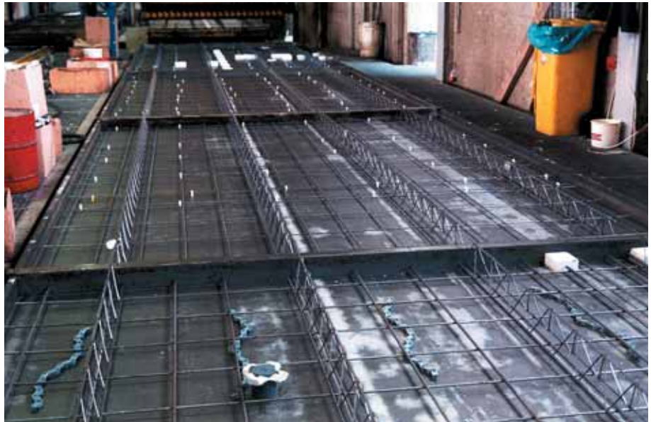
Foto 3.105: Wapening en tralieliggers zijn aangebracht. De inbouw is gereed
