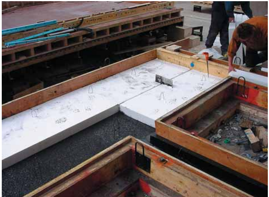
Foto 3.193: Verder aanbrengen van isolatieplaten
