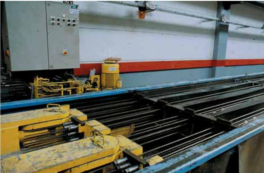
Foto 3.033: Zodra de gaten corresponderen steekt men een pen in het gat, zodat de verlenging van de strengen gefixeerd blijft. Op de achtergrond ziet men de hydraulische apparatuur waarmee de vijzel en de mal worden gestuurd
