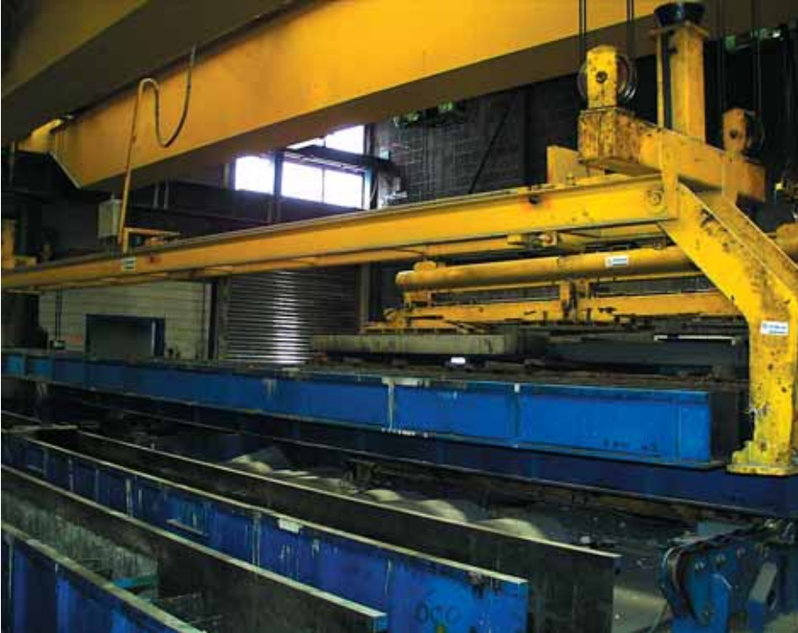
Foto 3.113: De mallen met verharde palen gaan naar het ruimstation
