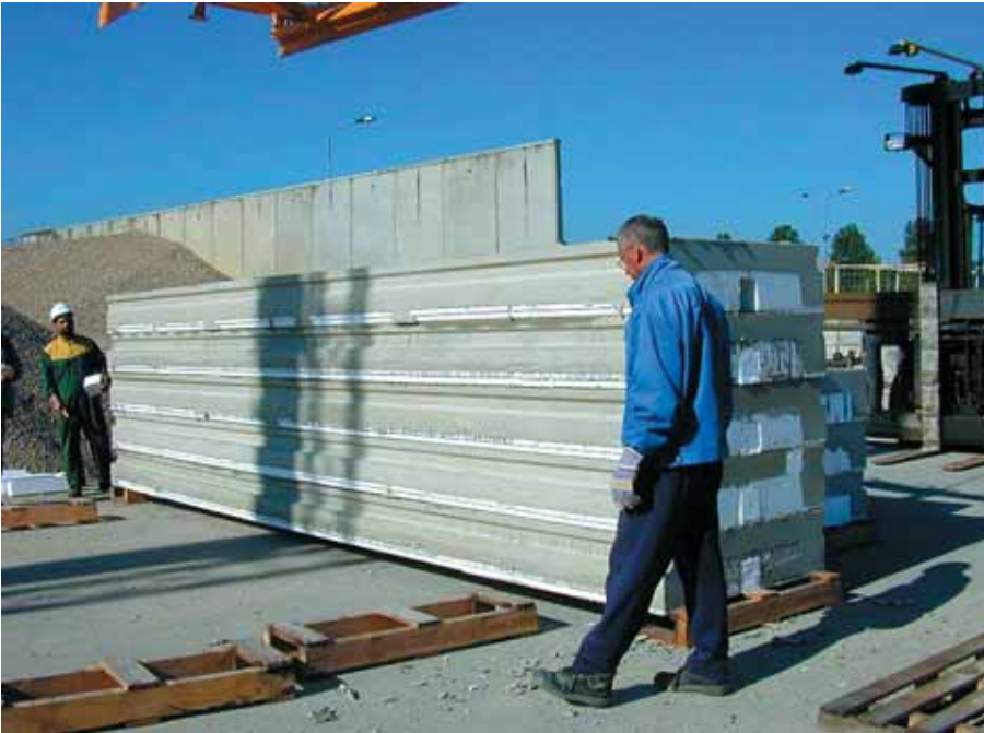
Foto 3.075: Stapelen, nu nog handmatig. De onderste plaat is onderstopt ter plaatse van de 'harde' oplegging. De andere dragen via het PS gelijkmatig op de ondergelegen plaat. De oplegdruk van de PS-platen mag niet te hoog zijn om grote vervormingen te voorkomen. De E-modulus van PS is slechts in de orde van 500 MPa
