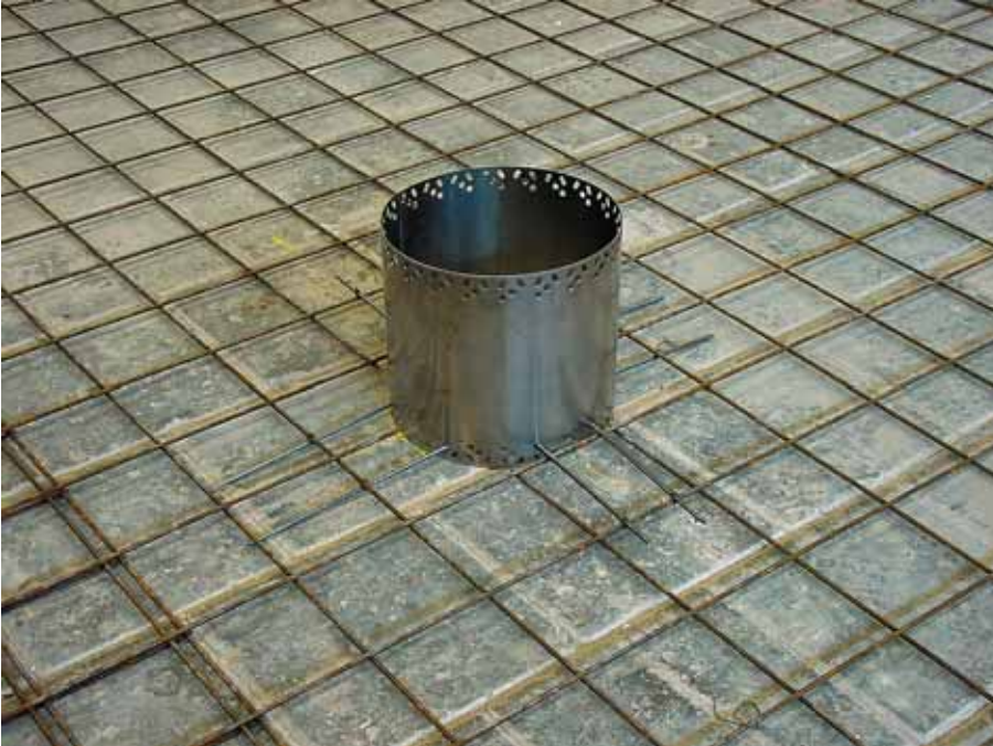
Foto 3.187: De voorbereiding begint uiteraard met de mal en de wapening. De mal is gereed, de wapening in de buitenschil is gelegd. Het DEHA RVS-busanker is geplaatst
