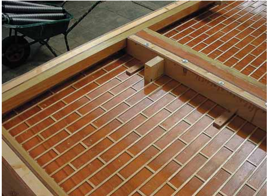
Foto 3.205: Veel handarbeid is ermee gemoeid om op een zachte folie de stenen te leggen in de kaders
