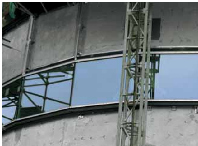
10 | Monteren raamstroken tussen borstweringselementen
