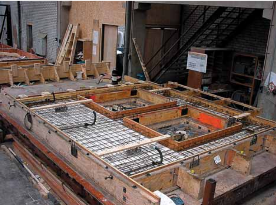
Foto 3.195: Het aanbrengen van de omhullingbuizen voor het opnemen van stekwapening
