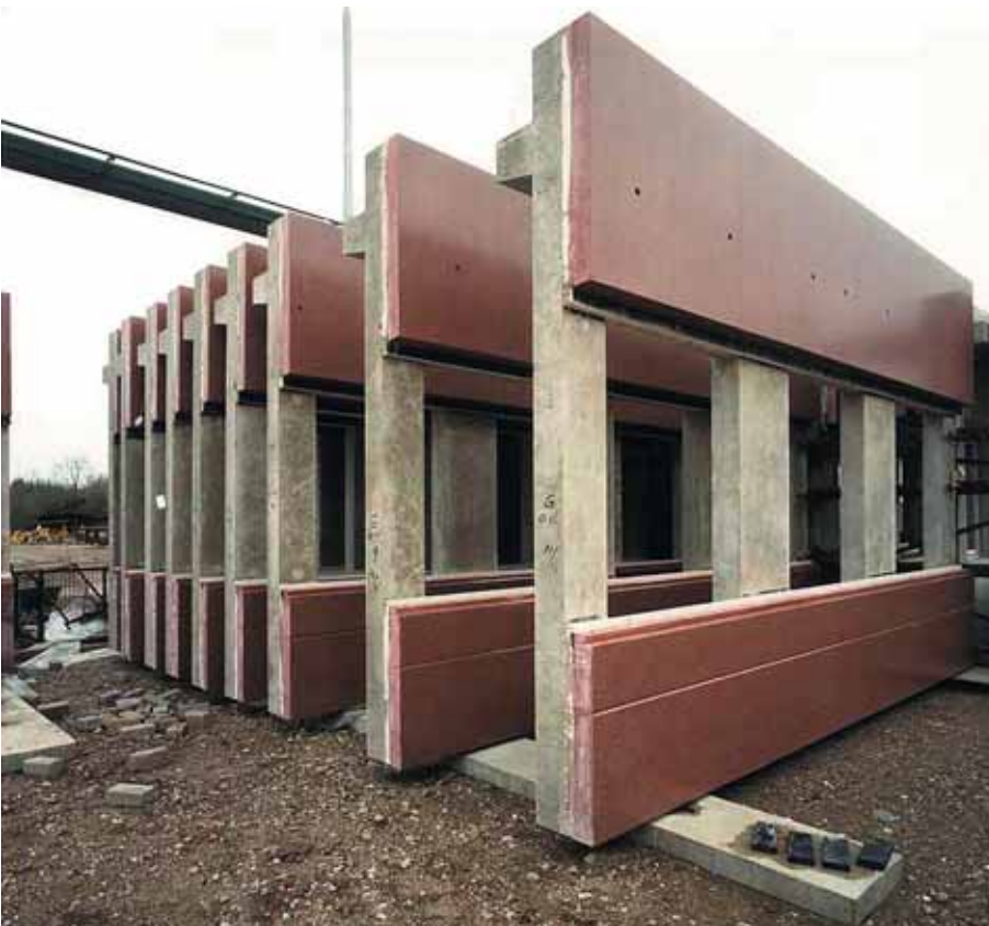
Foto 3.208: Gevelelementen met hetzelfde type gepolijst en gekleurd beton
