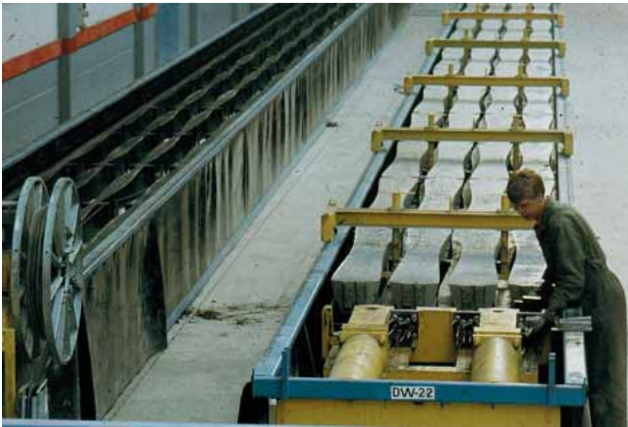
Foto 3.036: Zodra de mal in de lage positie is, brengt men de rolkarren aan ter plaatse van het smalle deel van de dwarsligger. De pennen waarop de dwarsliggers rusten, nadat de mal in de lage positie is, worden dan neergelaten. Alle dwarsliggers kunnen nu tezamen eenvoudig naar de zaagpositie worden gerold
