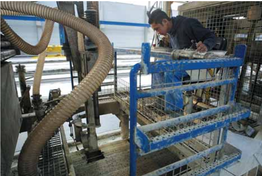
Foto 3.055: Een opname van de uitgezogen sparing. De bovendraad wordt later doorgeslepen
