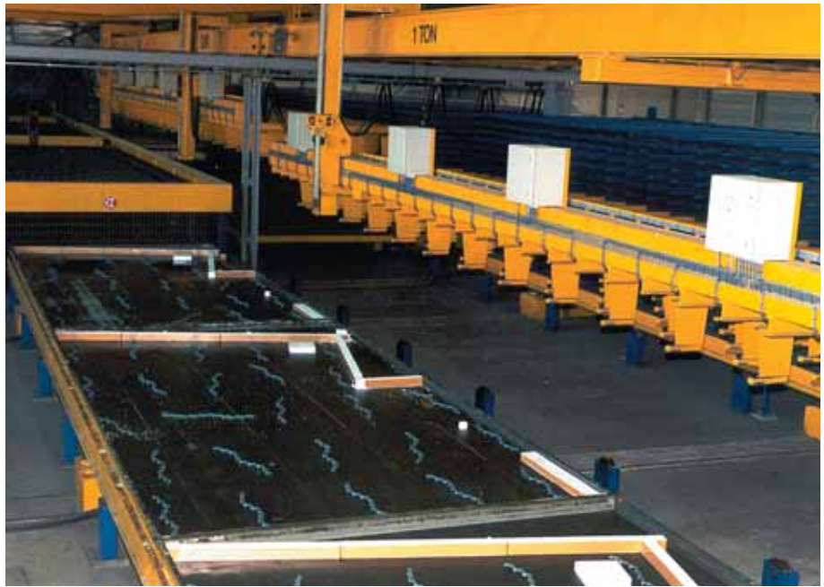
Foto 3.101: Door de ontkoppeling van voorbereiding en wapeningproductie is betrouwbaarheid ingebouwd. Hier wordt een wapeningnet opgehaald voor de tafel die eraast staat. Zie ook de bijzondere plaatvormen, gemaakt met randen van PS-stroken
