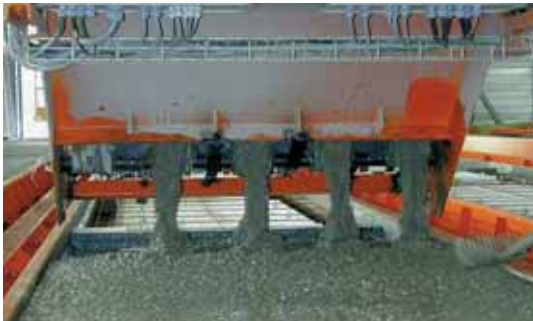
4 | Storten zelfverdichtend beton
