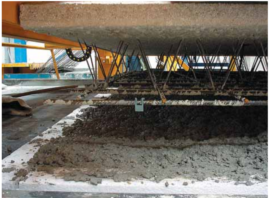
Foto 3.182: A- en B-schil koppelen. De wapening van de B-schil die is opgenomen in de A-schil, in de vers gestorte B-schil positioneren. Vlakken parallel stellen en zo houden
