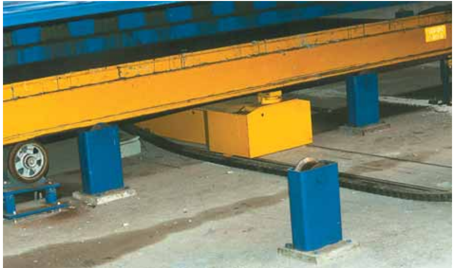
Foto 3.084: De voortbeweging gaat via een rollensysteem waaraan een aandrijfmotor. De signalering van de positie en de beveiliging tegen het doorlopen i.p.v. stoppen, gebeurt met elektrische ogen
