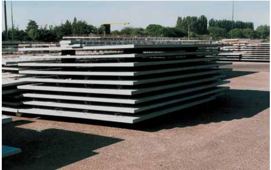
Foto 3.112: De cirkel is rond, de situatie als bij foto 3.077 is weer bereikt. De logistiek is sterk te noemen. Het proces begint en eindigt met de 'just in time' af te leveren stapel bekistingplaten
