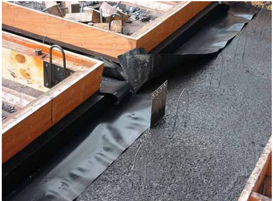
Foto 3.190: De zwarte buitenschil is gestort, de voorzieningen voor koppeling van de bladen is aanwezig. Slabben voor kozijnafdichting zijn al aangebracht
