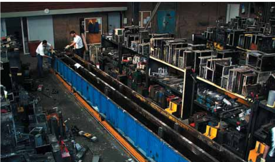
Foto 3.012: Aanbrengen van de koppeling van de zijschotten om de speciedruk te kunnen opnemen aan de bovenzijde van de mal en daarmee de breedte van de balk te verzekeren
