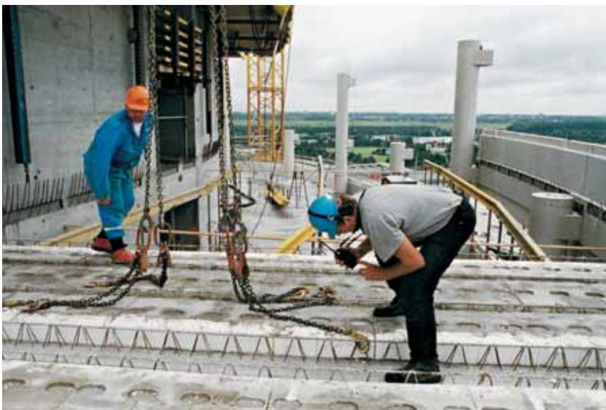
7-8 | Montage polyplaat-elementen in de 'Oval Tower'
