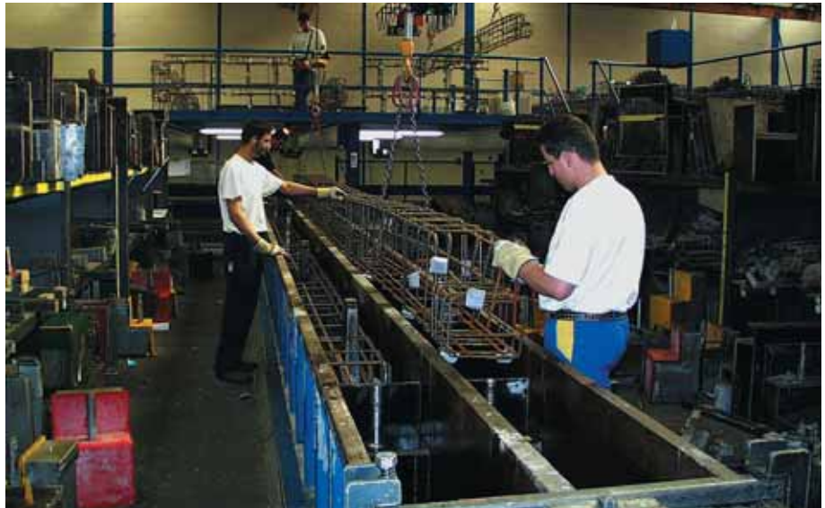
Foto 3.014: Plaatsen van de wapeningkooi. Kijk ook hier naar de wapening ter plaatse van de tand
