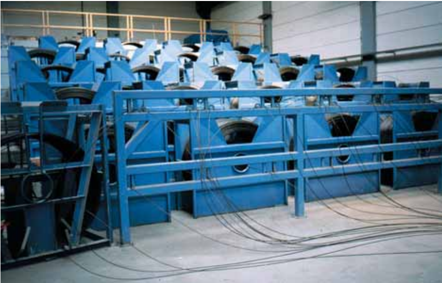
Foto 3.028: Elke dwarsligger is met tien stuks 7-draads strengen 6,3 mm - FeP 1860 voorgespannen. Er staan minimaal veertig coils opgesteld. Van elke coil gebruikt men de streng om een baan van veertig strengen te kunnen inrijgen
