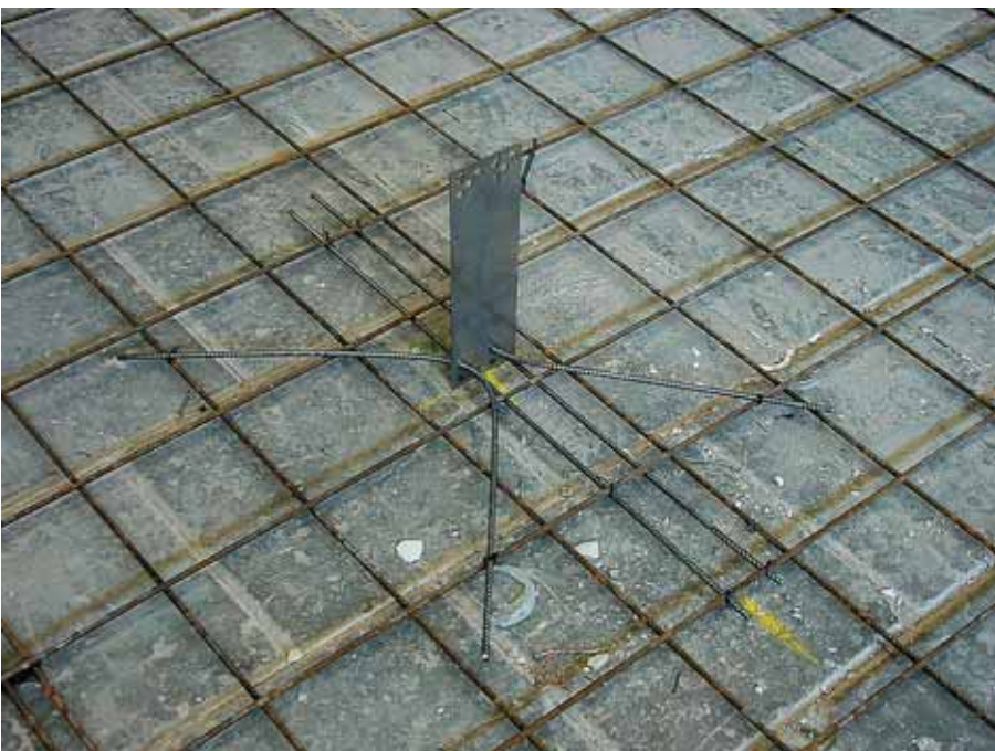
Foto 3.188: De ankers koppelen de buitenschil aan de binnenschil en dragen het gewicht van het buitenblad over aan het binnenblad. Om verdraaien van het blad te voorkomen worden er ook plaatankers gebruikt, die met de hoogste zijde in een cirkellijn t.o.v. de bus staan
