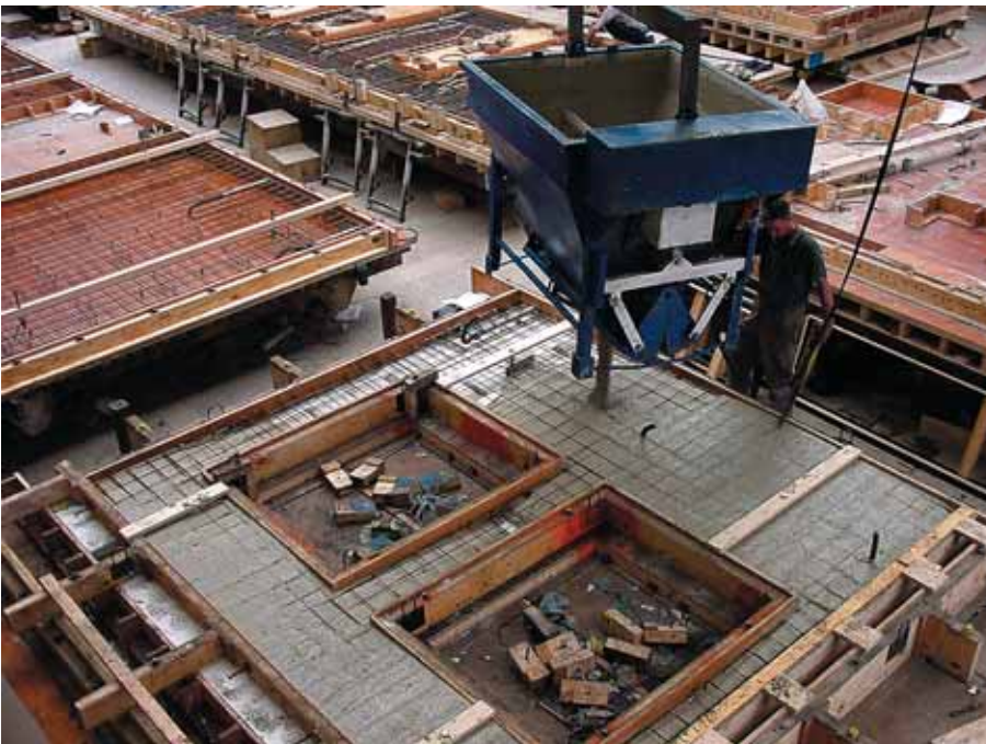
Foto 3.196: Het element wordt gestort met de kubel. Een toepassing van ZVB
