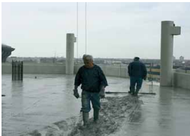
9 | Storten en afwerken verdiepingsvloer
