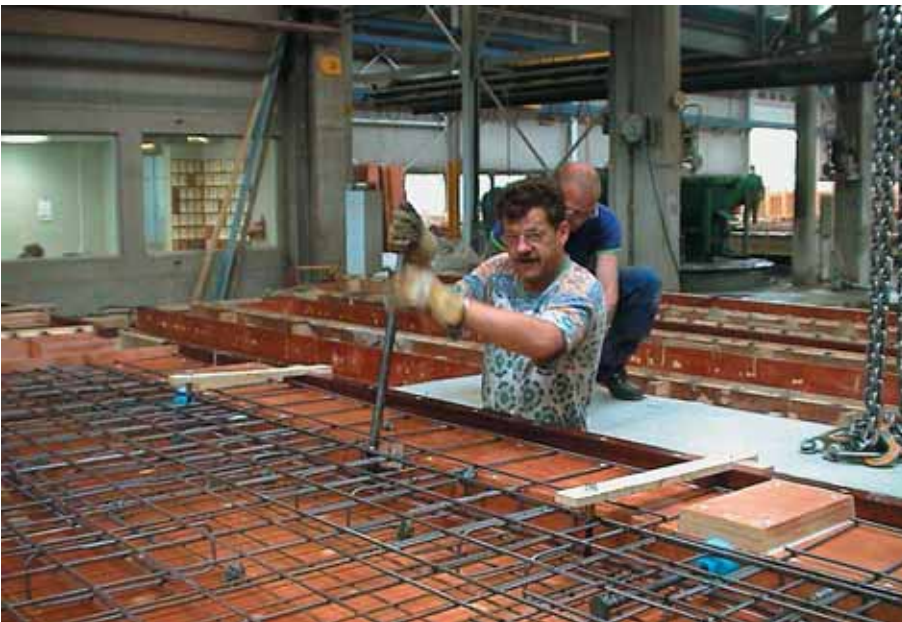
Foto 3.144: De wapening wordt semi-automatisch vervaardigd, maar handwerk blijft noodzakelijk
