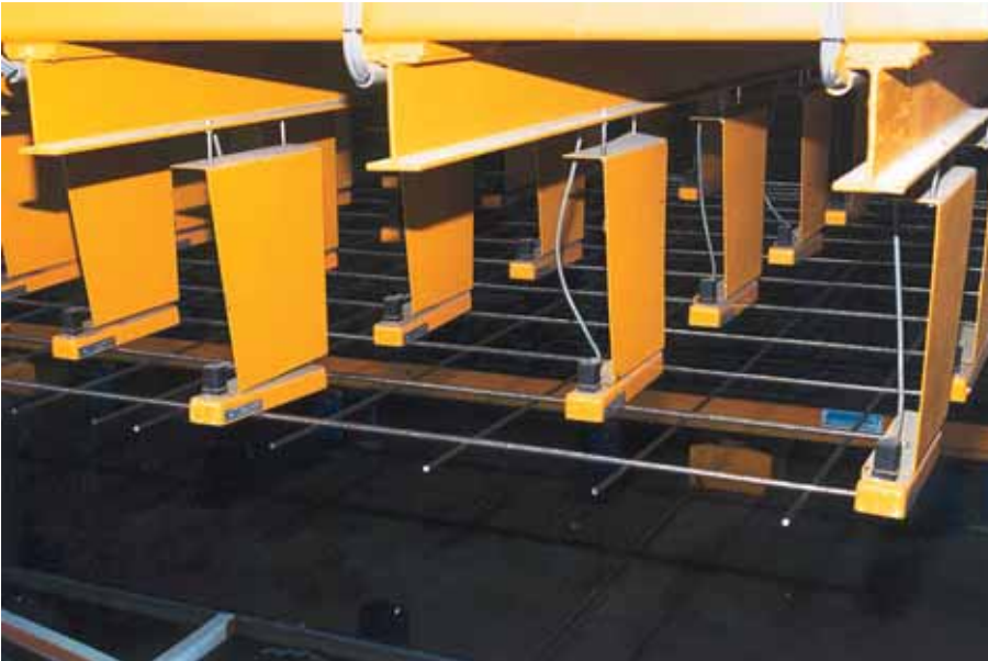
Foto 3.098: De mat wordt, wanneer deze gelast is, opgepakt met een magneethijsysteem
