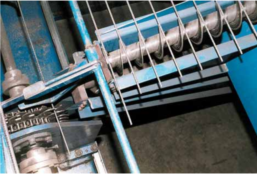
Foto 3.094: Een detailopname van het omhoogbrengen van de staaf of staafdelen
