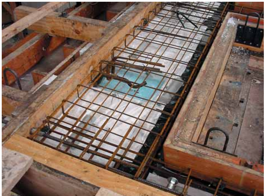
Foto 3.194: Vervolgens wordt een folie aangebracht tussen binnenschil en isolatie, die kan fungeren als dampremmende laag. Door de minimale afmetingen van plaat- en busanker is de koudebrug gering. De wapening van de binnenschil wordt aangebracht alsmede de in te storten voorzieningen zoals ten behoeve van het hijsen
