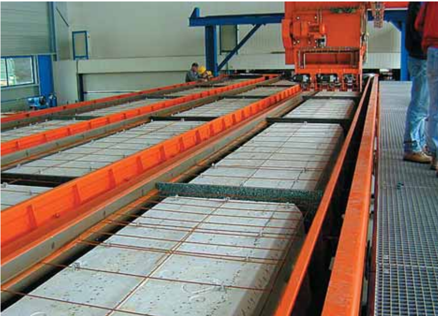
Foto 3.001: Voorgespannen ribcassetteplaten ingebouwd in een lange mal, die onderdeel is van een carrouselstelsel. De elementlengte wordt bepaald door de plaats van de ingebouwde kopschotten. Bij voorgespannen elementen is een gelijk aantal strengen en een gelijke strengpositie per element per baan aangewezen. Dit is ook de basis voor de baanindeling
