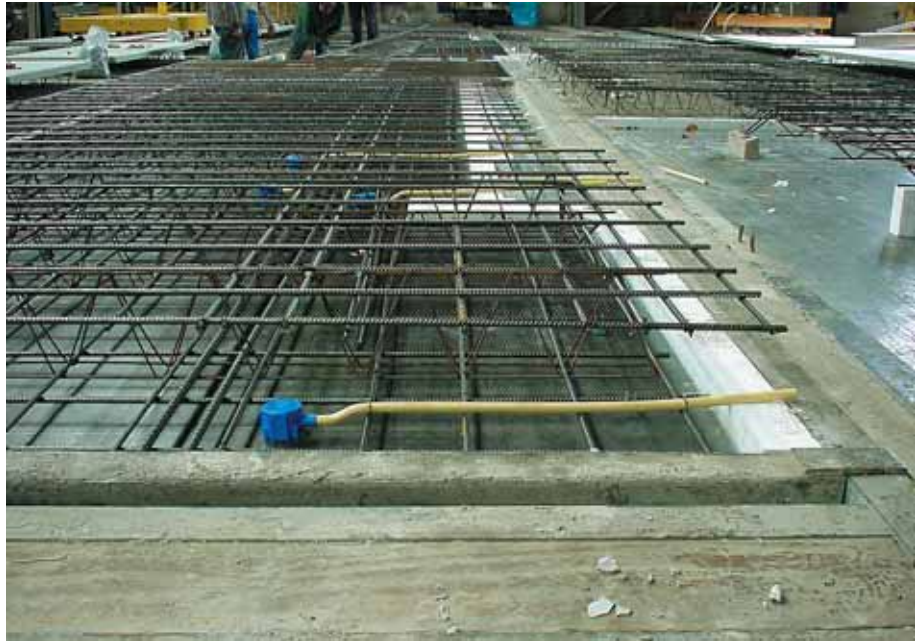
Foto 3.173: De wapening voor het dubbelwandige element is nu gereed
