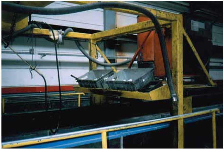
Foto 3.026: De kar is uitgerust met alle hulpmiddelen om te kunnen zuigen en oliën en pluggen te kunnen plaatsen, waarin later de Vossloh-bouten worden gedraaid, die de railklemmen fixeren op de dwarsligger
