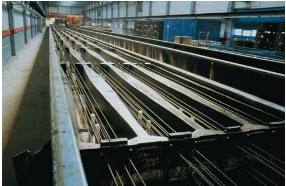
Foto 3.031: De mal is nu in de hoogste stand. Alle veertig strengen zijn aan beide zijden verankerd op de kopschotten. Men kan gaan spannen
