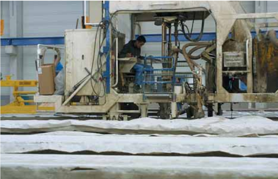
Foto 3.054: Sparingzuiger in actie. Let op het vat voor de opvang van betonspecie. De operator positioneert de zuigbuis op de afgeschreven sparing. Voor een grotere sparing verplaatst hij de zuigbuis een aantal keren
