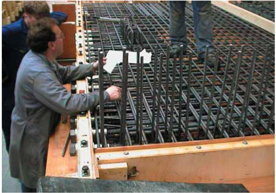
Foto 3.145: Wapeningnet voor inbouw gereed. Veel wapening, veel omhullingsbuizen
