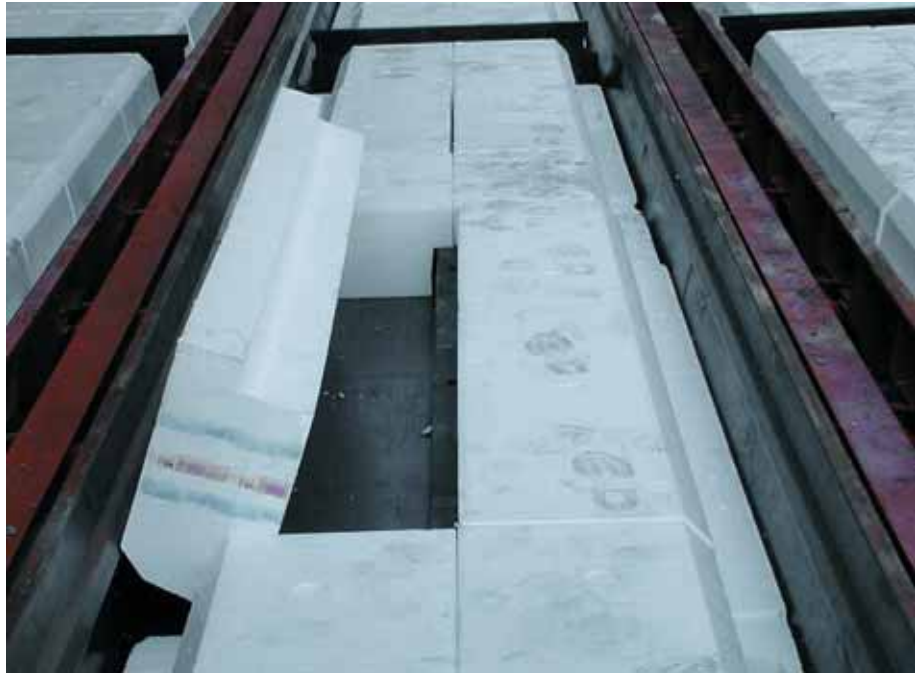
Foto 3.061: De polystyreenplaten worden in de baan aangebracht. Nu nog met de hand, straks met robots
