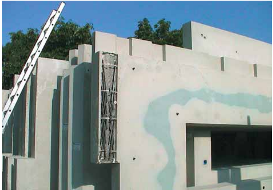
Foto 3.169: Een voorziene natte verbinding, een stekkenbak ingestort
