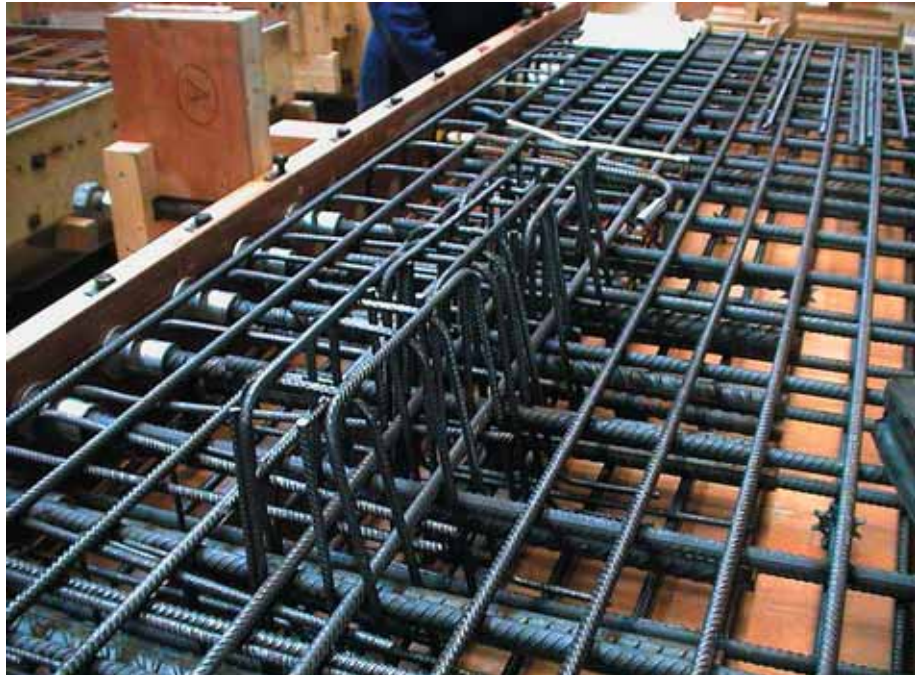
Foto 3.149: Een detailopname van concentratie wapening en stekken bij oplegneus
