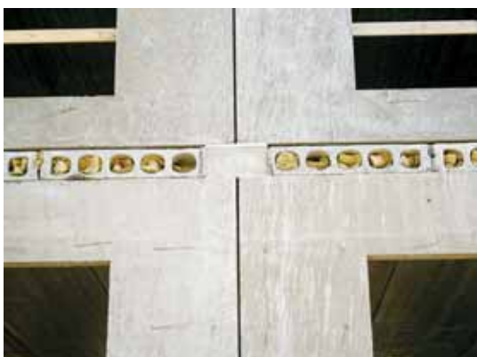
2 | LEVO-blokje tussen wandelementen en kanaalplaten
