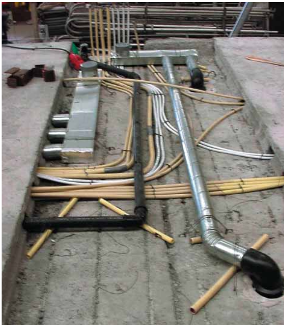
Foto 5.058: Op de vleugels zijn de leidingen gemonteerd, die ook nog deels oversteken door het kanaalplaatdeel heen
