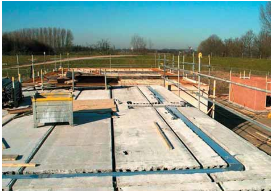
Foto 5.056: De leiding is in de leidingsleuf aangebracht. De sleuf loopt deels evenwijdig aan de oplegging
