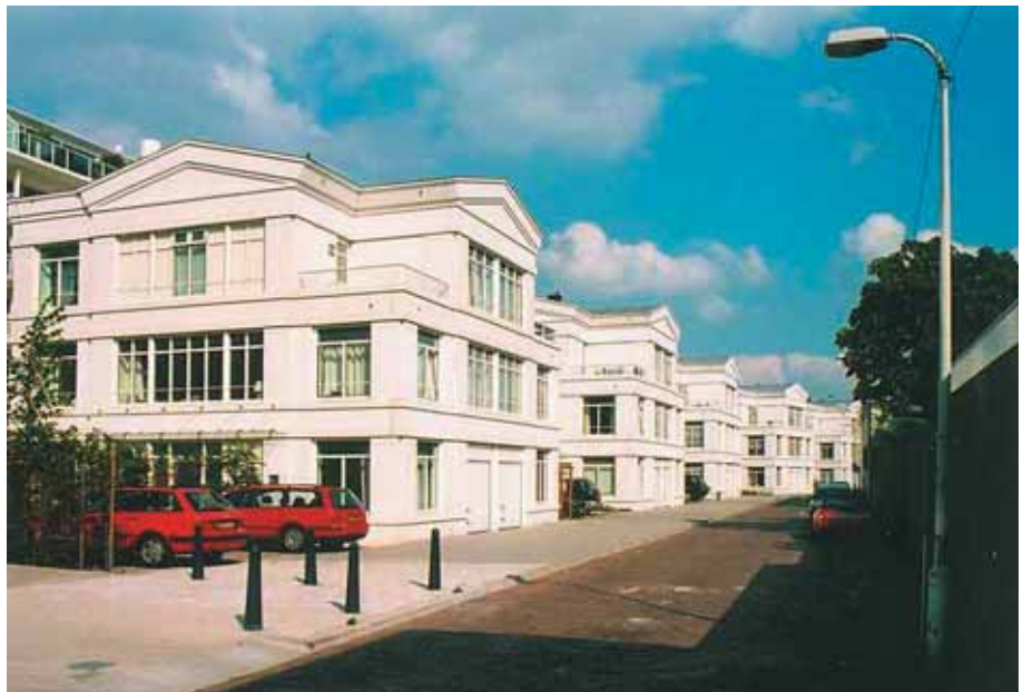
Foto 5.044: Een woongebouw volledig bekleed met witte betonelementen. Voor het verkrijgen van deze witte kleur is wit cement, een geringe hoeveelheid titaandioxide en Hustad-marmer toegepast met geselecteerd grind. Na het verharden is het oppervlak licht gestraald, waardoor de werking van het kwarts in het Hustad-marmer wordt geaccentueerd
