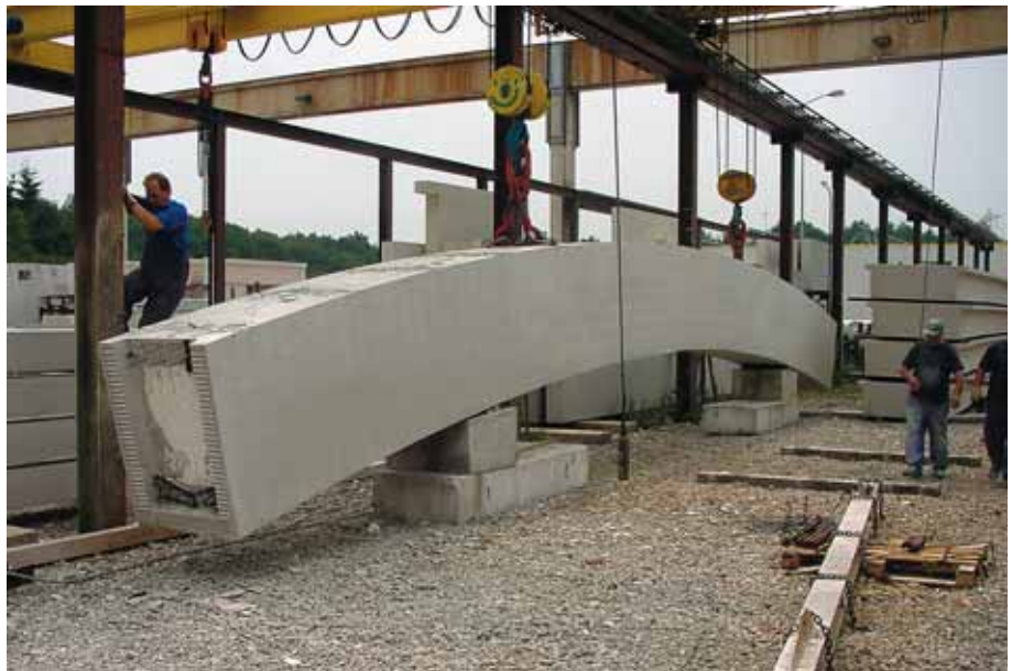
Foto 5.048: Opslag op het tasterrein. Het boogelement is zojuist neergelegd; de hijsvoorzieningen kunnen dan worden verwijderd
