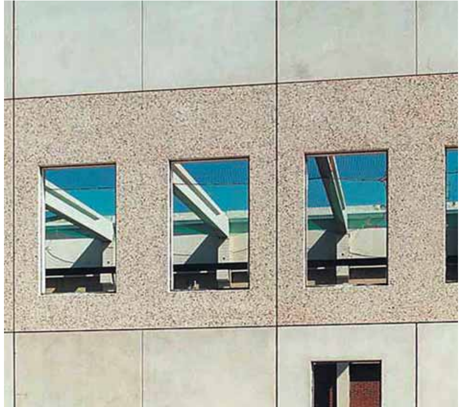
Foto 5.032: Gevelaanzicht en doorkijk van de halconstructie bij Hurks Beton B.V. te Veldhoven. De gevelelementen zijn vervaardigd met sierbeton
