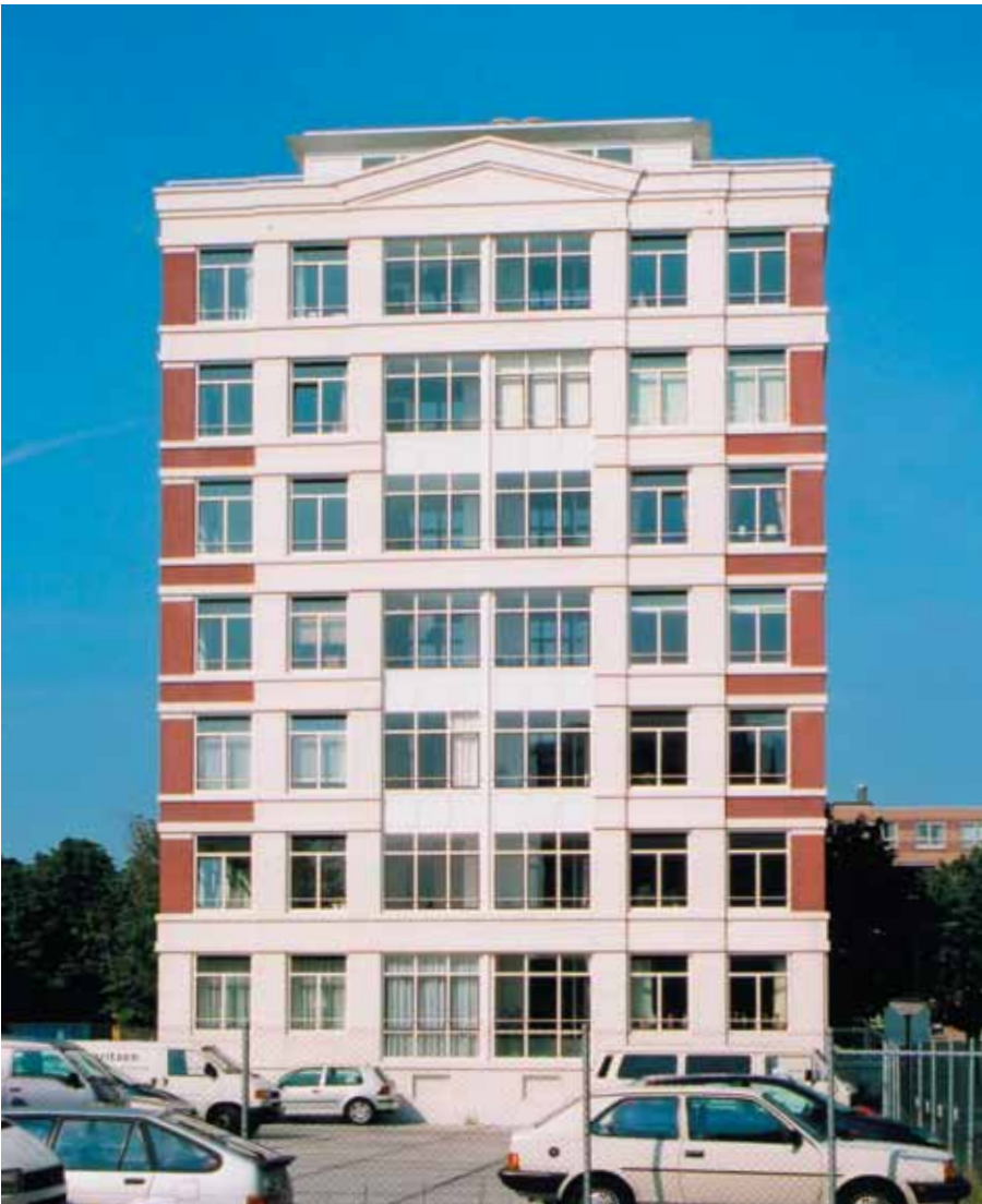
Foto 5.042: De gevel van een woongebouw bestaande uit gestapelde bekledingselementen van wit sierbeton. Enkele banden zijn separaat aan de achterliggende constructie bevestigd; tussen de banden is een andere afwerking aangebracht
