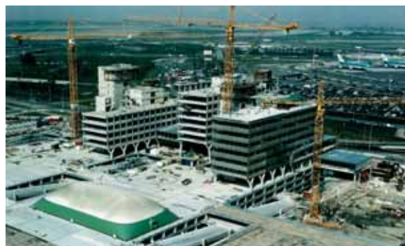
Bij gecombineerde constructiemethoden, zoals voor de parkeergarage P1 op Schiphol, zijn vaak verschillende constructiebureaus werkzaam. Een goede verdeling van verantwoordelijkheden vooraf voorkomt problemen
