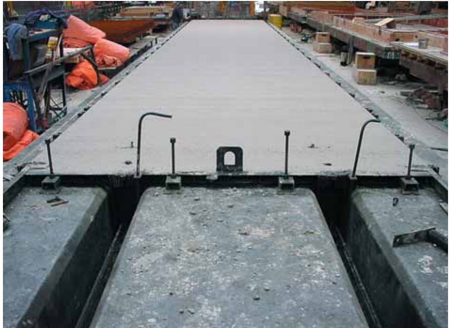
Foto 5.020: De productie van voorgespannen TT-platen in een lineaire opstelling. De strengen zijn onderin de ribben gepositioneerd. Door het plaatsen van het kopschot in de vaste mal, wordt de lengte van het element bepaald. Meerdere elementen worden achter elkaar in de mal geïnstalleerd
