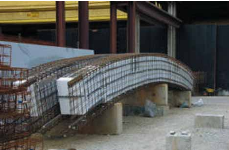
Foto 5.046: Voor een constructie met een grote overspanning moet men het eigen gewicht van de constructie minimaliseren. Het boogspant wordt opgebouwd uit secties, die nat met elkaar worden verbonden en waarvan het gewicht is verminderd door een polystyreenkern toe te passen. De wapeningskorf met PS-kern ligt gereed voor toepassing
