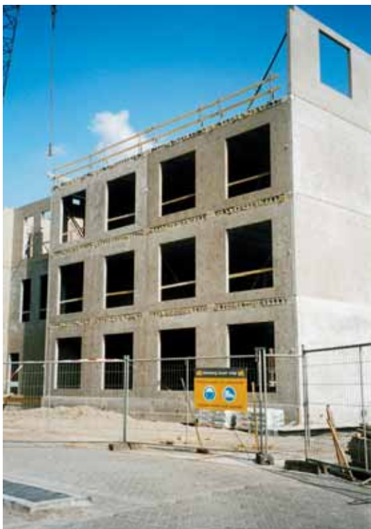
8 | LEVO-blokjes zichtbaar in gevel kantoorgebouw te Nieuwegein
