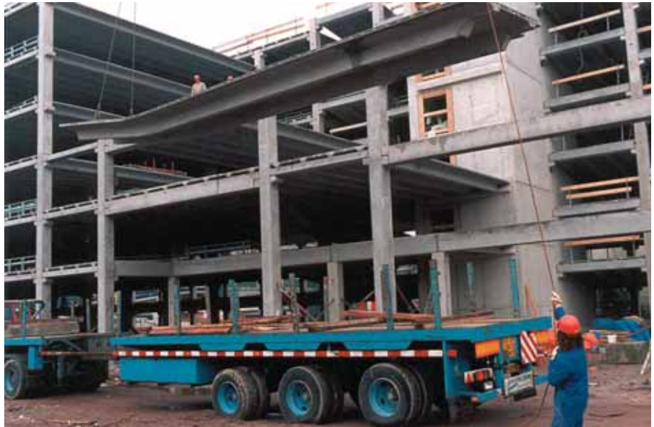
Foto 5.010: Hellingbaan TT-plaat voor een parkeergaragemontage direct vanaf de wagen, waarop twee of drie platen kunnen worden geladen. De maximale belasting mag 35 ton bedragen
