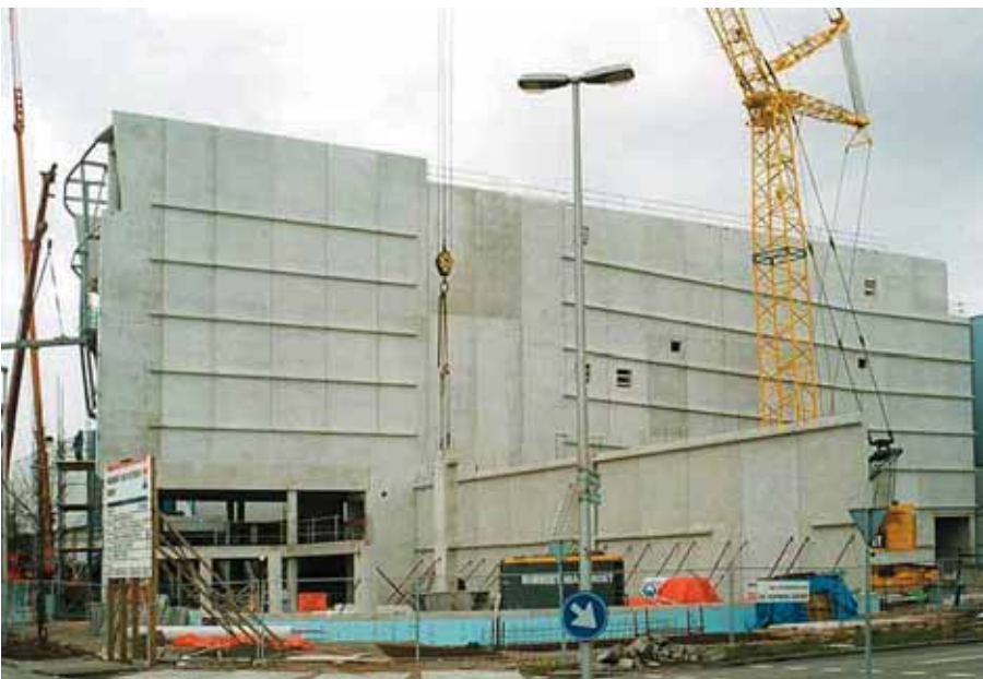
Foto 5.039: De achterwand van de bioscoop, waarop de oplegnokken voor de kanaalplaten van de parkeerlagen duidelijk zijn te zien
