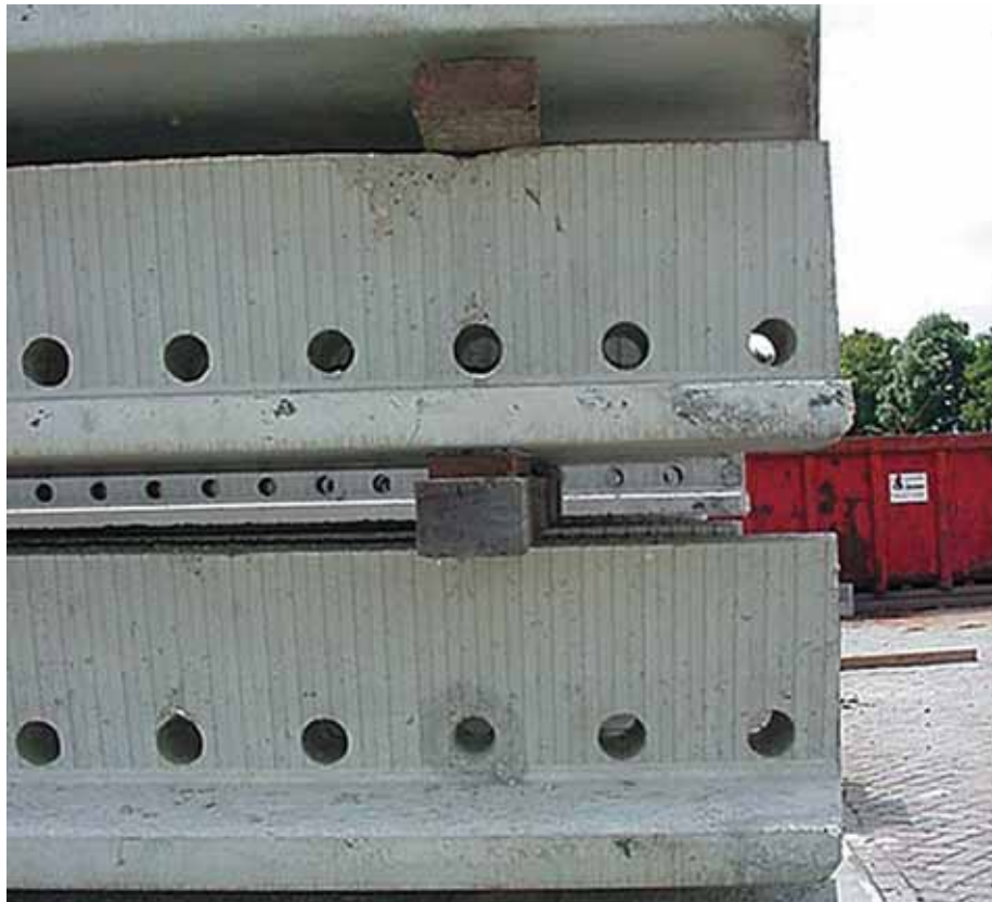
Foto 5.004: Element met overstek getast. De zeeg wordt niet verminderd als het overstek juist wordt gekozen. Ingeval van oplegging aan de einden zal het eigen gewicht tegen de voorspanning in gaan werken en de zeeg doen afnemen. Vooral in de eerste dagen treedt de invloed sterk op. Na twee dagen is er nog weinig te compenseren. Ingeval van te veel of te weinig zeeg kan men met de oversteklengten 'spelen'
