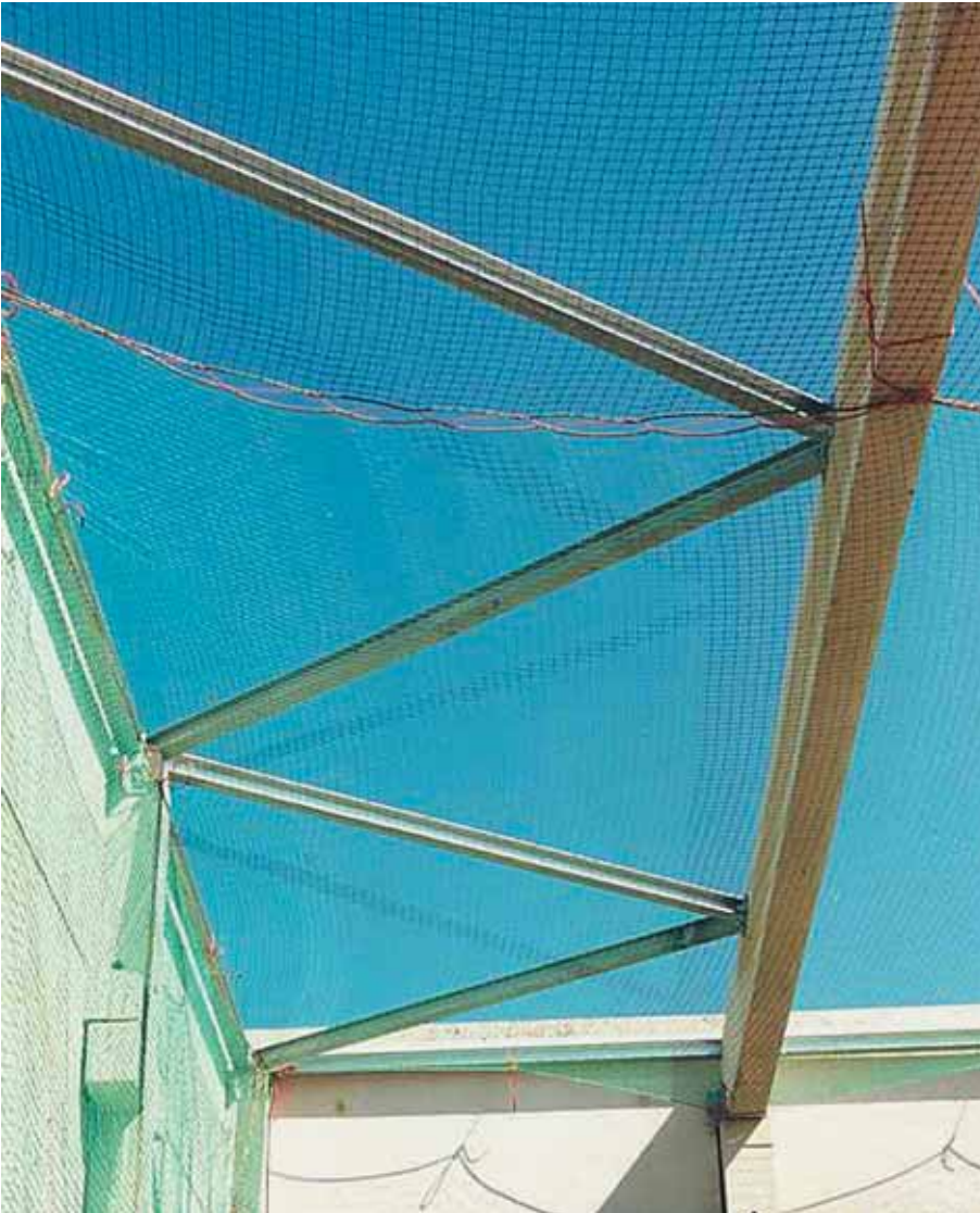
Foto 5.034: De stijfheid van het dakvlak wordt geregeld door een vakwerk van staven in combinatie met de eerste dakligger
