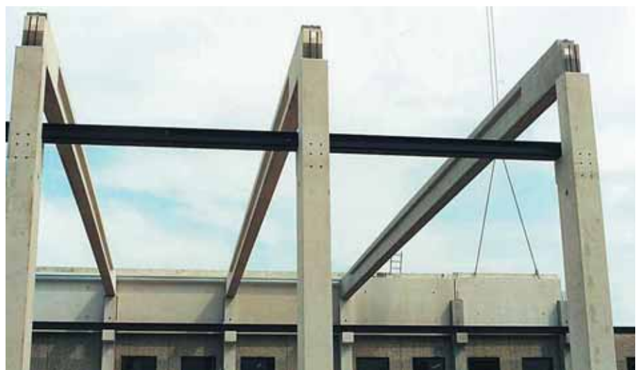
Foto 5.033: De kolommen van de hal zijn geschikt om twee dakliggers te kunnen opleggen, zodat de hal een dubbele overspanning kan krijgen. Aan beide zijden zijn de kraanbalken zichtbaar, die op consoles rusten. Zichtbaar zijn tevens de voorzieningen om nog een console op de kolom te kunnen monteren
