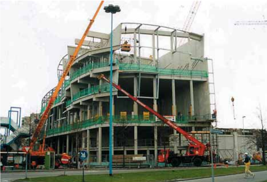
Foto 5.038: De draagconstructie van bioscoop 'Movie Palace' met parkeergelegenheid te Zoetermeer. Hoewel het gebouw grillig van vorm is, is de constructie goed uitvoerbaar in prefab beton
