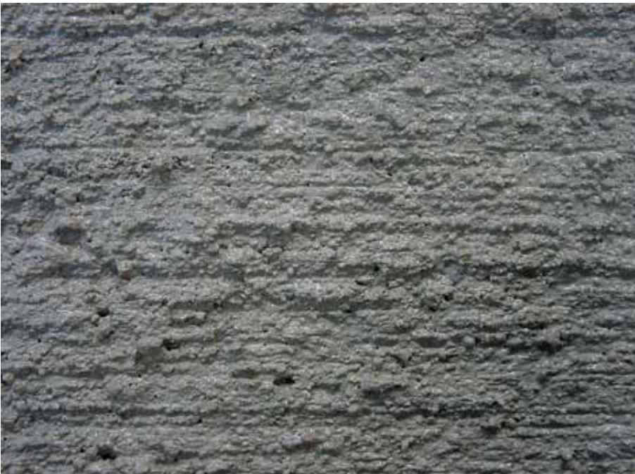
Foto 5.019: Het geruwde oppervlak van een TT-plaat in detail. De mate van ruwheid kan men kiezen. Soms wordt alleen 'gebezemd'
