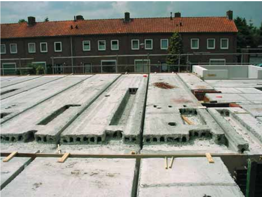
Foto 5.055: Kanaalplaten voorzien van leiding sleuven en sparringen
