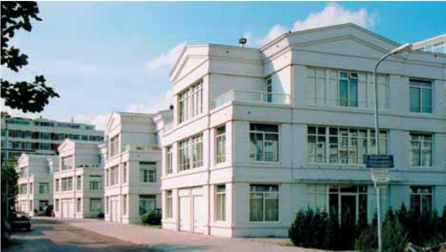
Foto 5.045: Enkele zeer witte woongebouwen op een rij. De tijd zal leren of vanwege de gekozen detaillering van onderdelen en aansluitingen zich geen vuile strepen op het oppervlak gaan aftekenen. Vuil dat zich ergens kan verzamelen zal tijdens een regenbui zijn weg naar beneden zoeken. Dit is bij witte elementen eerder storend dan bij donkergekleurde elementen
