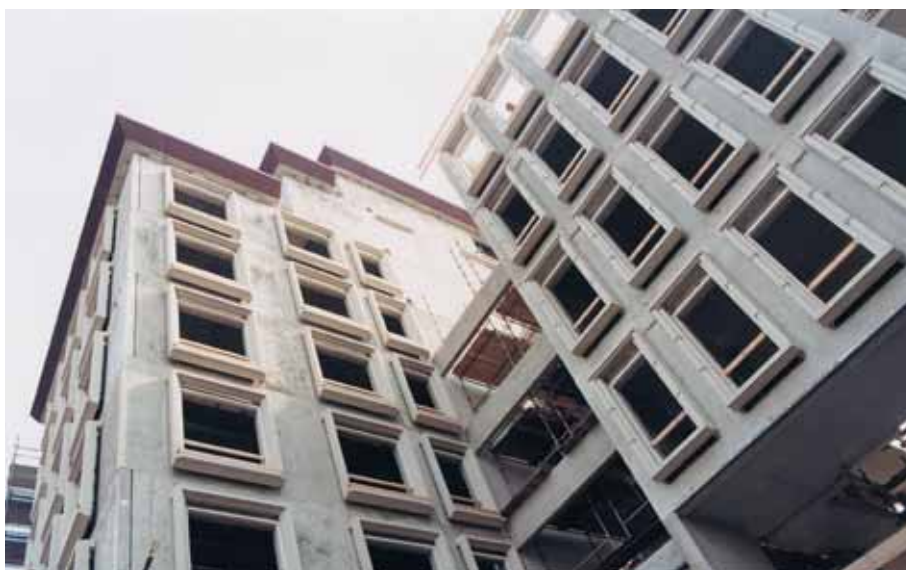
Foto 5.013: Een fragment van de wandelementen met de daarin gestelde sierbetonnen raamkaders
