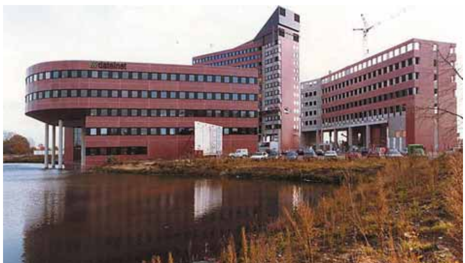
Foto 5.028: Het kantoorgebouw Bolduc in 's Hertogenbosch; dragende sandwichelementen van gepolijst beton. Door de vorm van het gebouw en de prominente ligging aan de snelweg A2 is dit kantoorgebouw inmiddels zeer bekend geworden. De kleurverschillen tussen de elementen zijn gering te noemen
