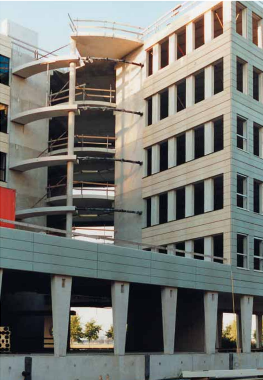
Foto 5.029: Het kantoorgebouw Schiphol Rijk met dragende sandwichelementen. De constructie van het trappenhuis is in opbouw. De trappen moeten nog worden gemonteerd
