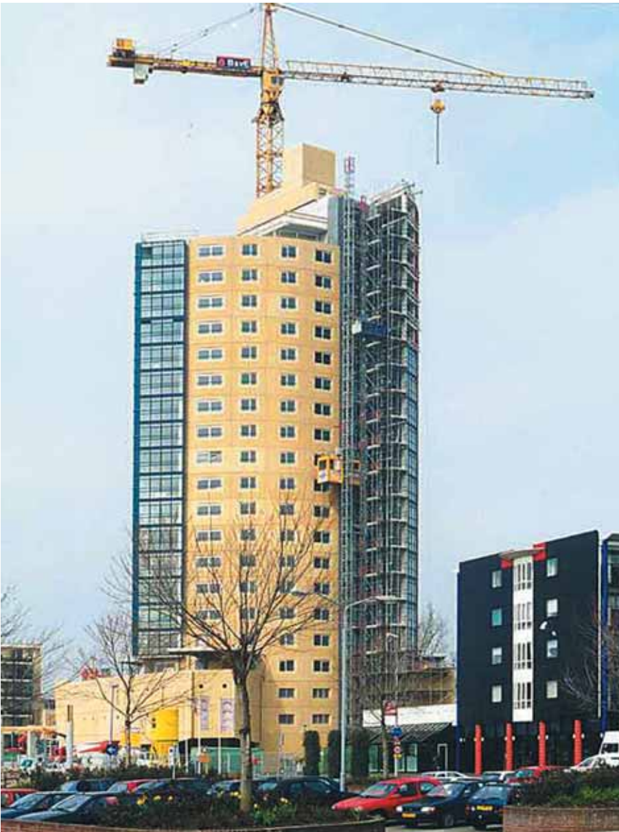
Foto 5.031: De woontoren 'Sequoia' te Dordrecht. De opbouw van de constructie van het gebouw geschiedt met een klimkraan in en op de liftschacht. De bekleding van het trappenhuis geschiedt met een bouwlift en hangsteigers
