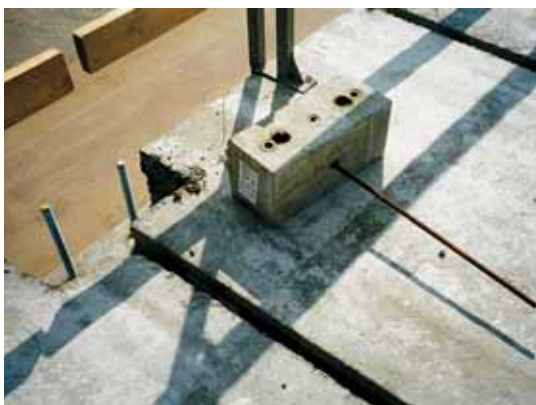
1 | LEVO-blokje; de kanaalplaten zijn van uitsparingen voorzien
