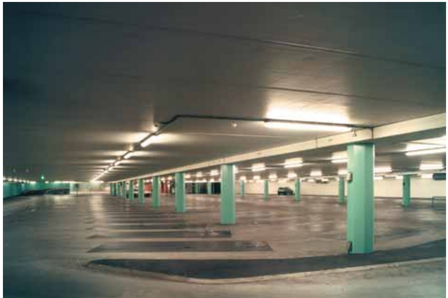
Foto 5.017: Een beeld van de parkeerruimte met de vlakke onderzijde vanwege de kanaalplaten. De achthoekige kolommen waren van een brede kop voorzien, waartussen de voorgespannen omgekeerde T-balken scharnierend zijn opgelegd. De balk is daardoor een zogenoemde gerberligger
