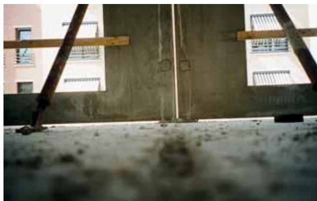
3 | Wandelementen worden op het LEVO-blokje gesteld, vrij van de vloer
