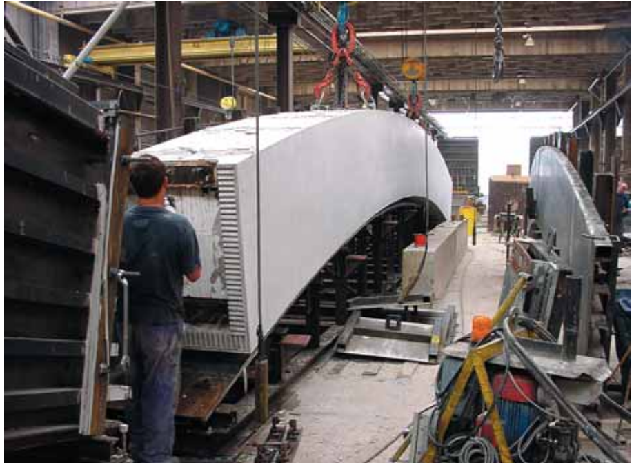
Foto 5.047: Rechts op de foto ziet men de zijmal, die is weggenomen. Het boogelement kan nu worden gehesen. Aan de einden is een inkassing te zien, die in de montage voorzien wordt van wapening, die doorsteekt in het aansluitende element en dan wordt volgestort
