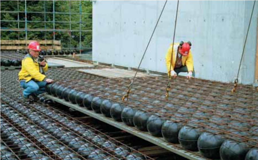
Foto 5.061: De BubbleDeckvloer in de uitvoeringsfase. Het bovennet moet na de montage nog worden gecombineerd
