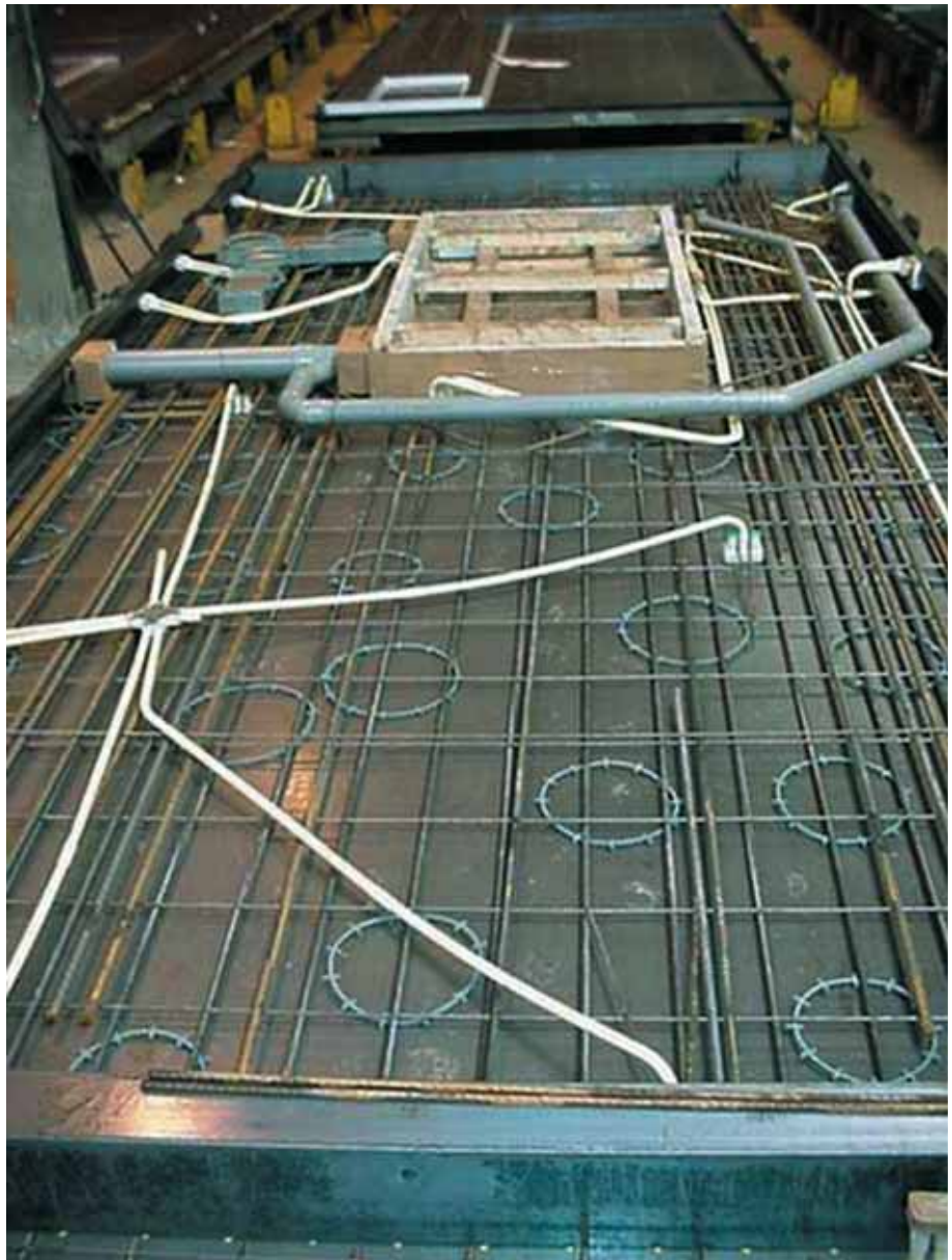
Foto 5.059: De vervaardiging van een Volleplaatvloer in de fabriek
