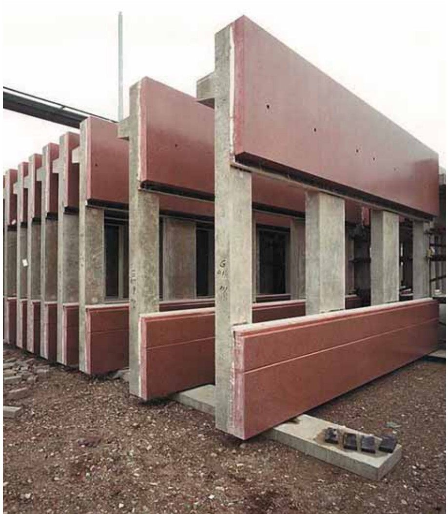
Foto 5.027: Een basis dragend sandwichelement met raamopeningen. Het roodkleurige beton is gepolijst. De stijlen worden met de afdekprofielen van de horizontale raampartij bekleed
