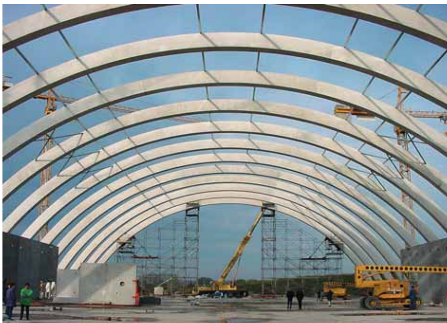
Foto 5.050: Een spant van meer dan 60 meter overspanning is opgedeeld in vijf delen. Ter plaatse van de voegen is het spant ondersteund, opdat de 'natte' voeg kan worden gerealiseerd. Zie verder de aangebrachte stalen koppelingen en verbanden. Een fraai stukje werk
