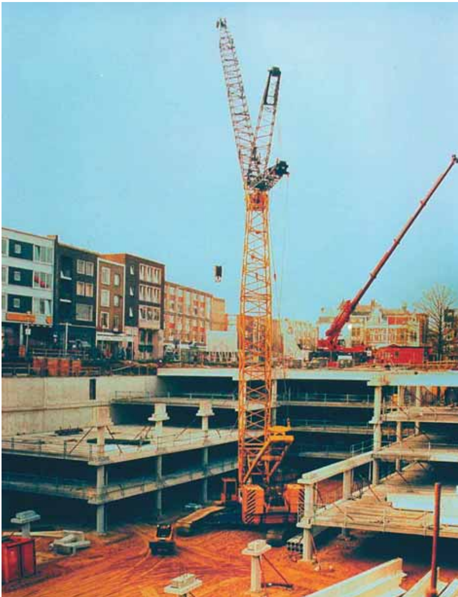
Foto 5.015: Ondergrondse parkeergarage Kelfkensbos; montage van het skelet en de kanaalplaatvloeren. De kraan staat centraal, de reikwijdte en het elementgewicht bepalen de capaciteit van de kraan. Nadat links en rechts enkele vakken zijn gemonteerd, zal de kraan in de beuk waar hij is opgesteld de vloerplaten monteren
