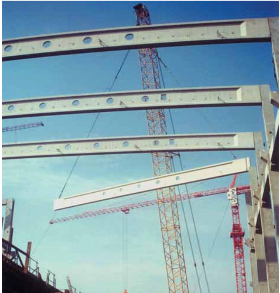
Foto 5.035: De voorgespannen I-liggers zijn uiterst slank geconstrueerd. In het lijf zijn systematisch gaten gemaakt om doorvoeringen van leidingen te kunnen maken. De I-ligger is ter plaatse van de oplegzone voorzien van een hamereind, vanwege de overdracht van oplegkrachten, dwarskracht en de plaatsing van omhullingbuizen voor stekken
