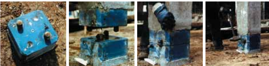
Foto 6.028: Er bestaan meerdere oplossingen voor de verbinding tussen twee palen.
