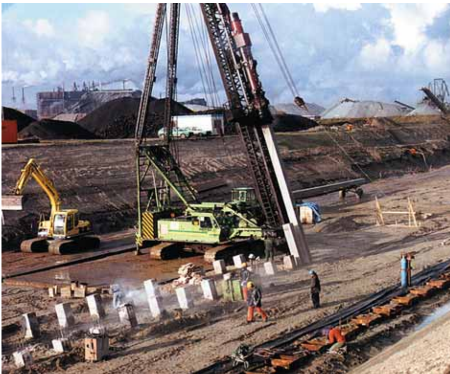
Foto 6.037: Schoor heien in de Van Cittershaven in Vlissingen. De voorgespannen palen kunnen op druk worden belast tot circa 3000 kN. Lengte 24,5 tot 27,5 m, doorsnede 450-450 mm. Elke paal is voorzien van een spuitlans
