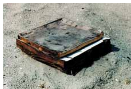
Foto 6.057 en 6.058: Wat er gebeurt met een inferieure mutsvulling
