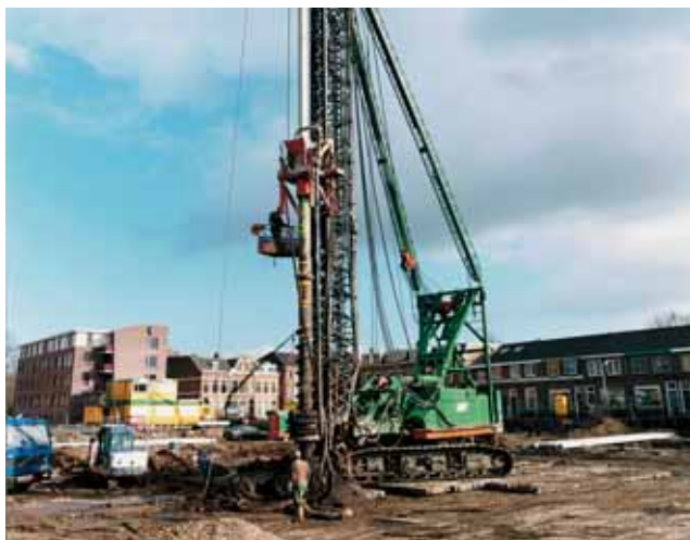
8 | Plaatsen prefab element in buis van avegaar
