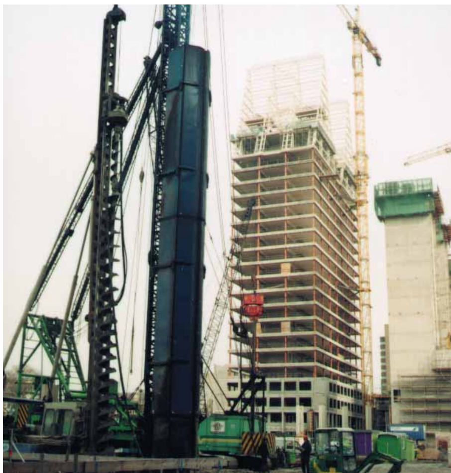
Foto 6.071: Het heien met een geluidsmantel in het centrum van Den Haag
