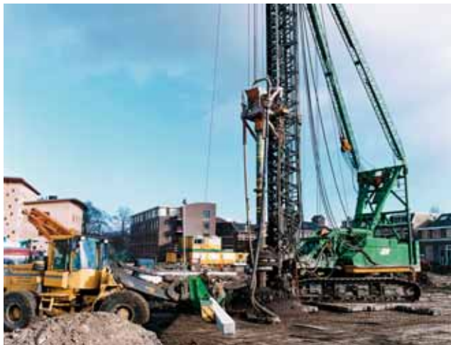
7 | Mortel in buis van avegaar aanbrengen foto's: Dick Vanbeurden
