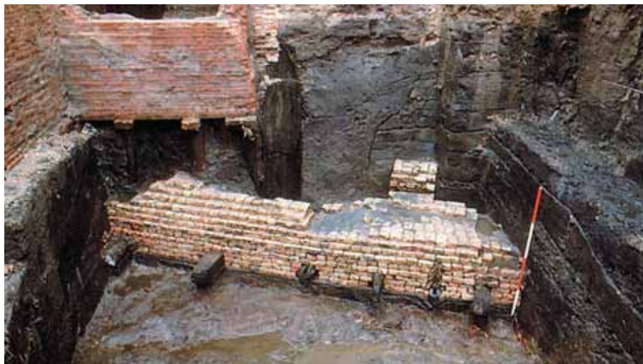
Foto 6.017: Funderingsmethode van het Kasteel van de Heren van Aemstel in Amsterdam, opgraving in 1994
