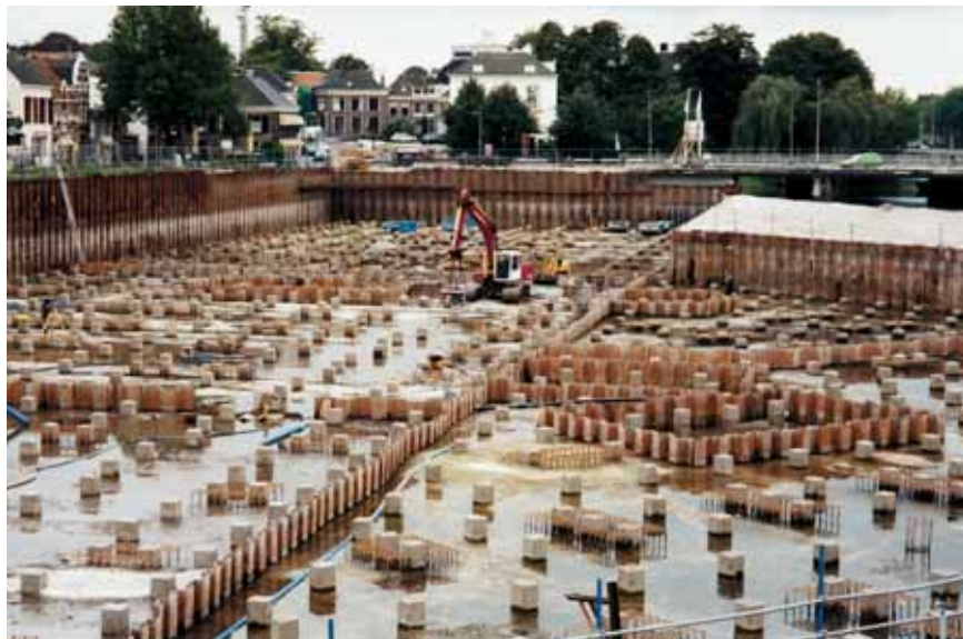
Droge bouwput, onder- waterbeton met paalkoppen
