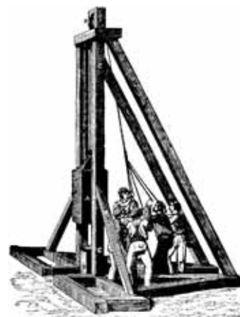
Foto 6.018: Hollandse heistelling en de heiwerkzaamheden voor een kunstwerk aan het einde van de negentiende eeuw. Let op het grote aantal mensen dat bij een heiwerk betrokken was
