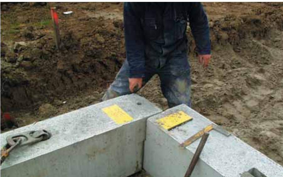
Foto 7.016: Gevelbalk wordt opgelegd op overstekende balk. Twee tanden op 1 oplegnok
