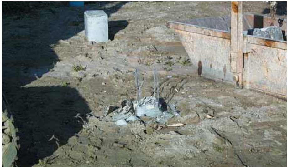
Foto 7.007: Een gekraakte paal. De wapening wordt op hoogte afgeslepen
