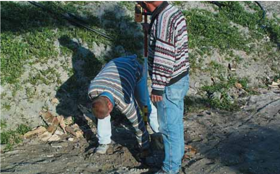
Foto 7.004: Palen worden op hoogte gekraakt. De hoogte wordt overgehaald, zie tweede man
