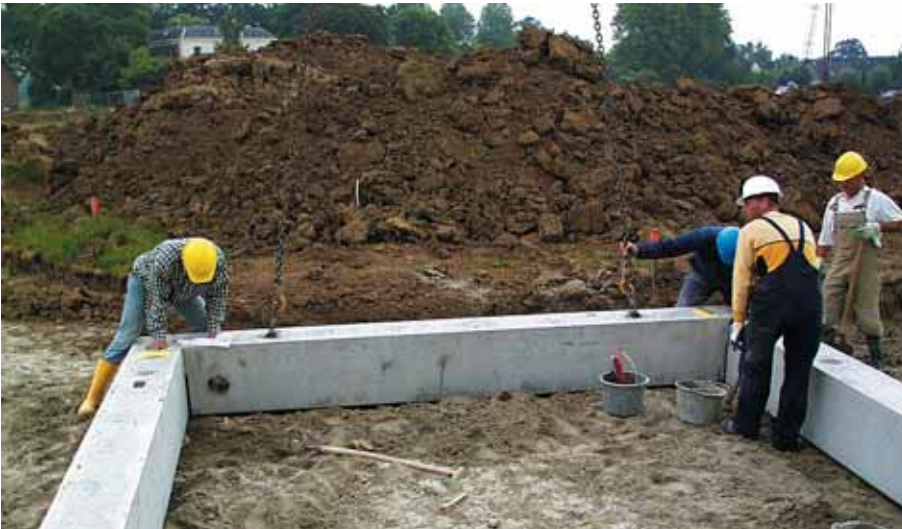
Foto 7.015: Montage balk voor buitenhoek. De sparing in de linkerbalk geeft aan dat de paal daaronder staat, dus rust de nieuw geplaatste balk op het overstek van de balk aan de linkerzijde!
