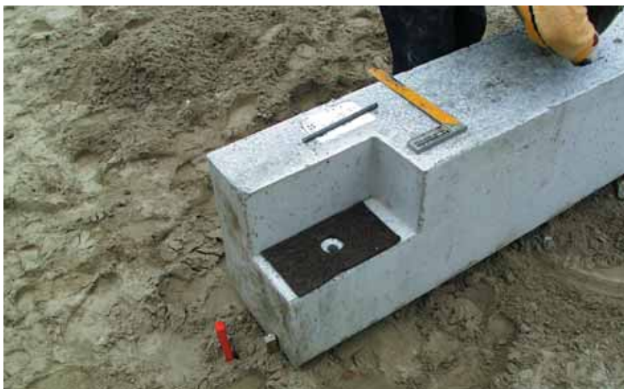
Foto 7.022: Detailoplegvlak, waarbij een viltlaag is aangebracht. Buitenhoek!
