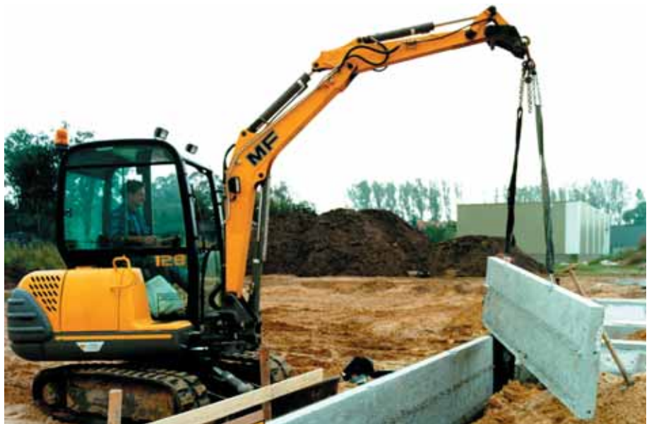
Foto 7.032: Alles in één hand. De (mini-)graafmachine is een belangrijk gegeven voor de funderingswijze. Want het afstemmen van de massa van alle onderdelen op het hijsvermogen van de graafmachine heeft het voordeel dat:
