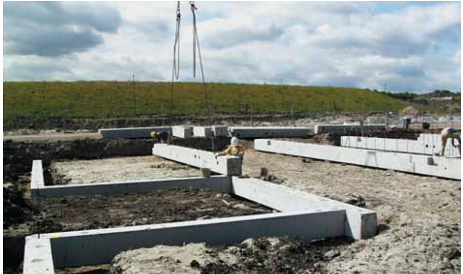
Foto 7.011: Verdere montage, de volgende balk ligt op de voorgaand gemonteerde balk!
