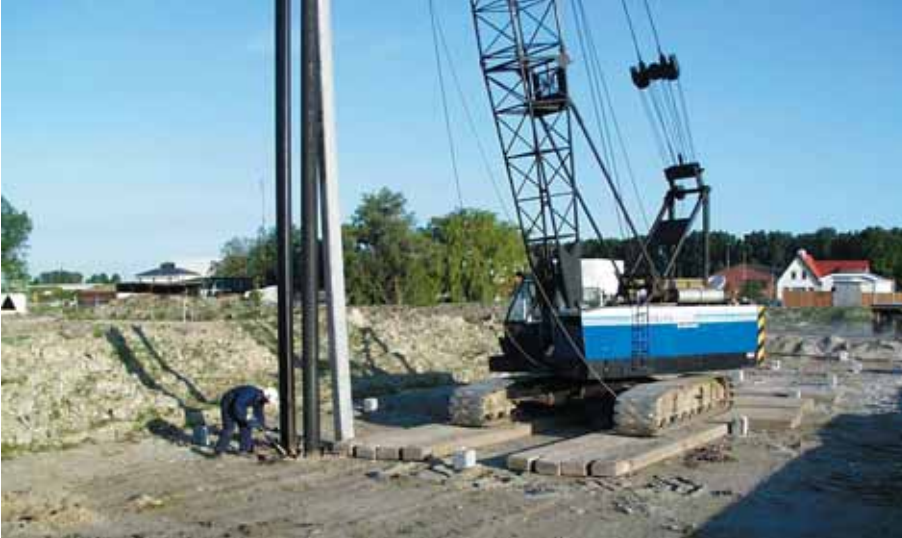
Foto 7.003: Het heien van de palen, op diepte. Hier wordt de paal onder de stelling gebracht
