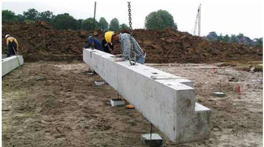
Foto 7.019: Balk positioneren, over stekken heen
