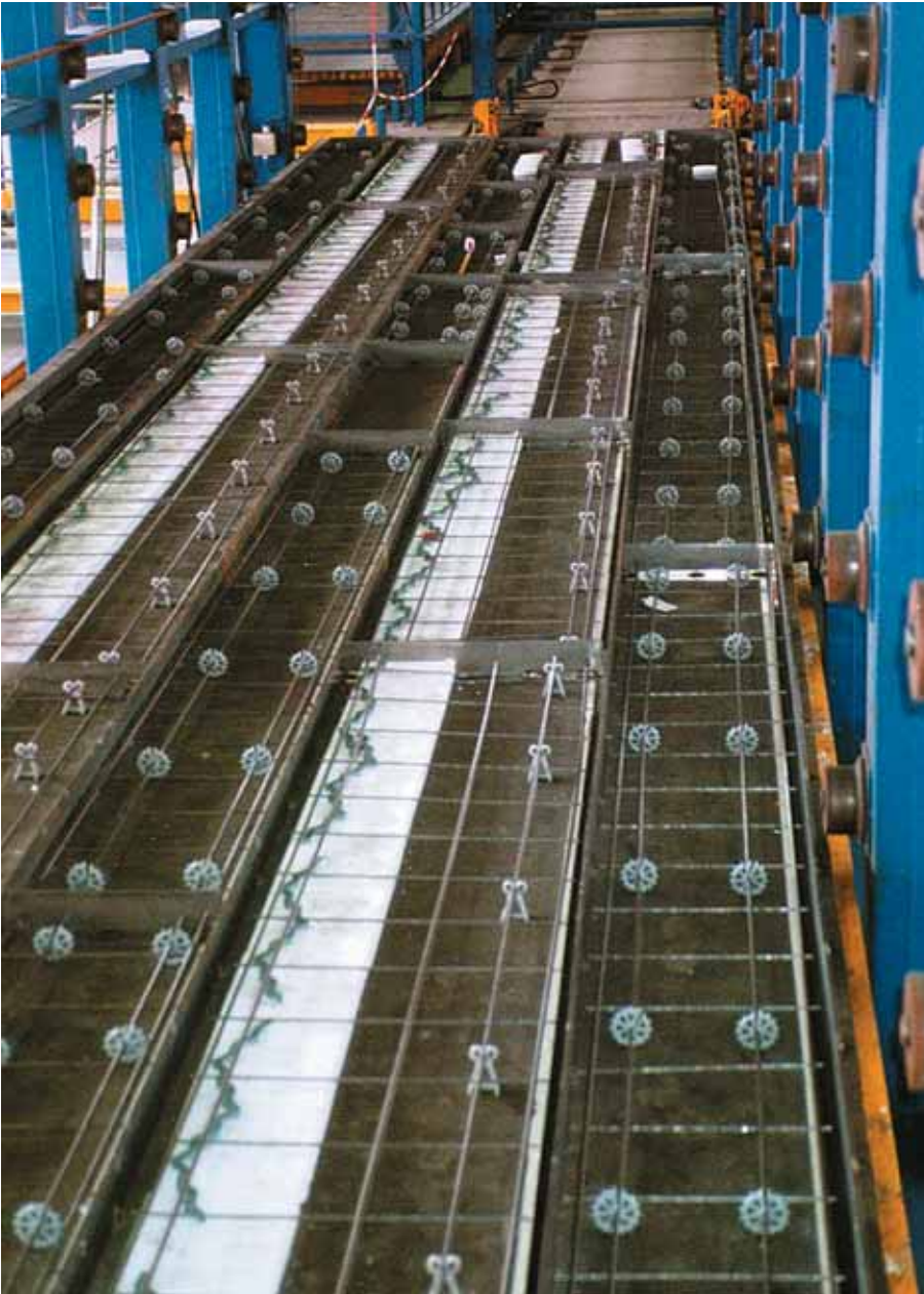
Foto 7.034: Productie. De prefab-betonelementen worden in lange stroken achter elkaar gestort. In eerste instantie worden in de bekisting tussenschotjes geplaatst, om de gewenste lengte te realiseren. Later zullen de betonnen elementen op voorraad worden geproduceerd, en wordt de gewenste lengte verkregen door afkorten van de lange strook kort voordat met de uitvoering wordt begonnen. Met op voorraad geproduceerde elementen wordt de voorbereidingstijd gereduceerd
