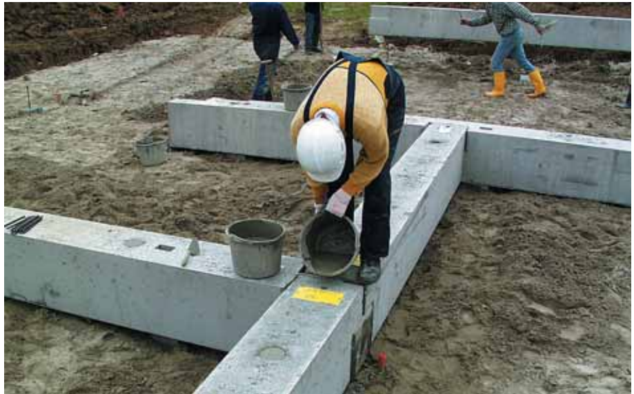
Foto 7.024: Aangieten van verbinding van 2 langsbalken op een draagbalk
