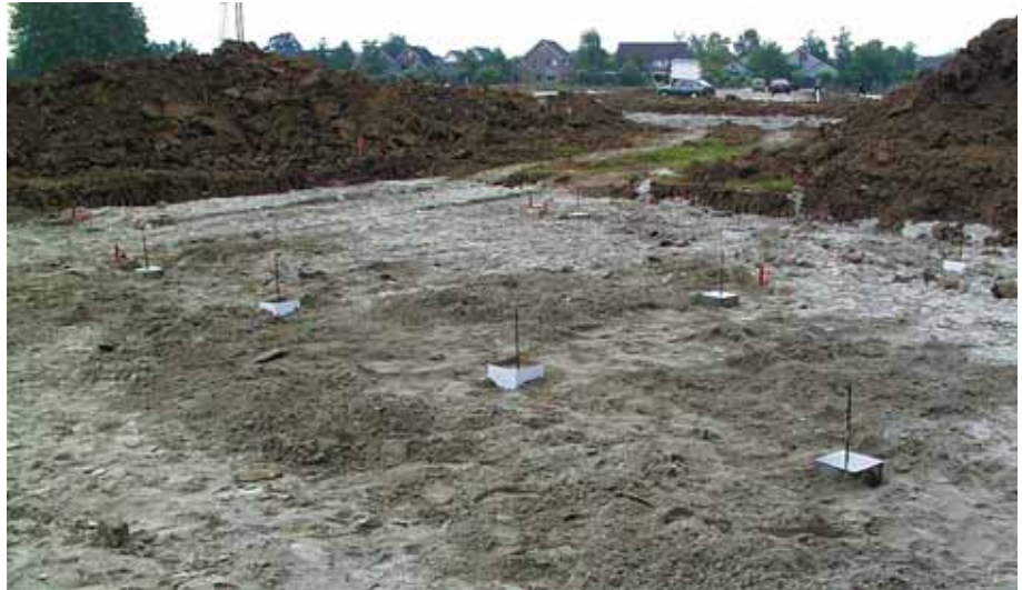
Foto 7.017: In een andere bouwput worden de palen op hoogte gebracht met een kartonnen koker waarin gietmortel is gestort
