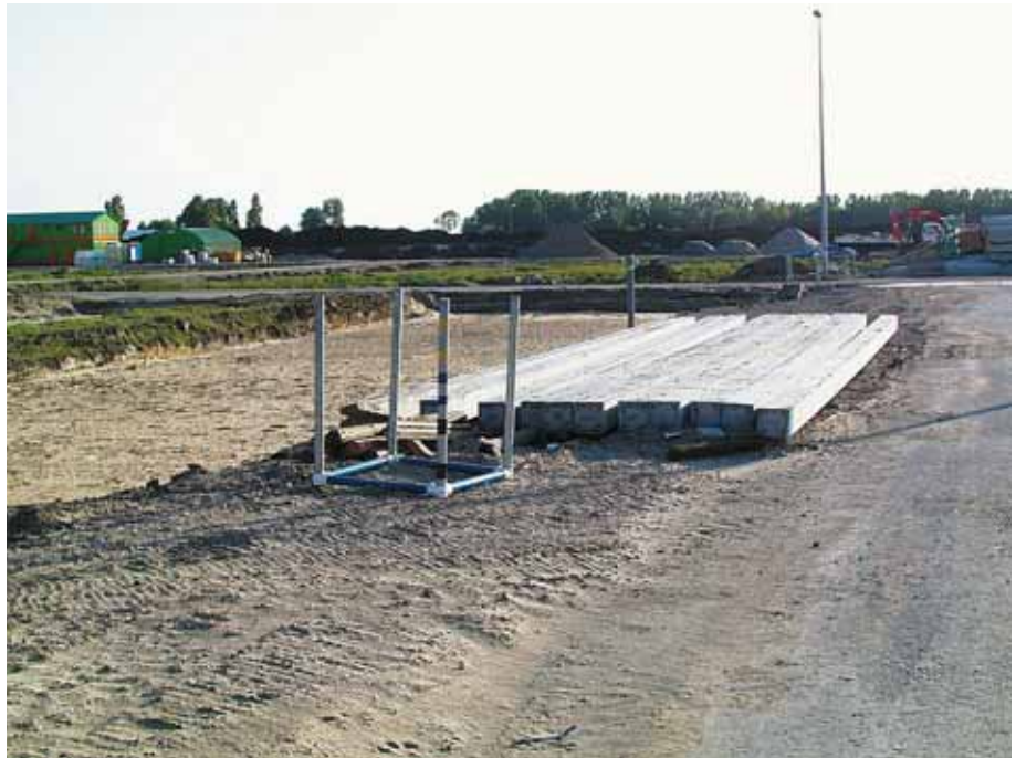
Foto 7.001: Veldmaten uitgezet, bouwput ontgraven, palen aangevoerd
