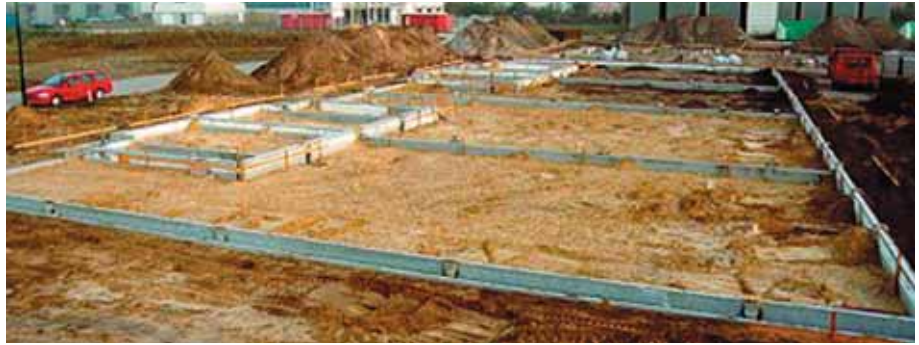
Foto 7.030: In een referentieproject zijn de organisatie-aspecten van de funderingswijze getoetst. De fundering op de voorgrond is met de funderingswijze ACE's gerealiseerd, terwijl de fundering op de achtergrond op traditionele wijze is vervaardigd
