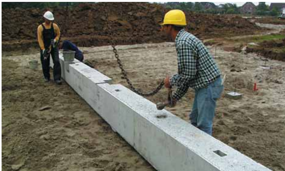
Foto 7.020: Op deze balk komt een balk te rusten, zowel vanaf de linkerzijde als vanaf de rechterzijde, zie de kepen
