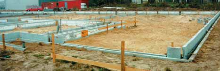
Foto 7.033: Fundering voordat de tussenruimte met beton wordt gevuld. Onder de betonnen platen is met een L-vormig afsluitstuk een verbrede voet gecreëerd, die ook met beton wordt gevuld
