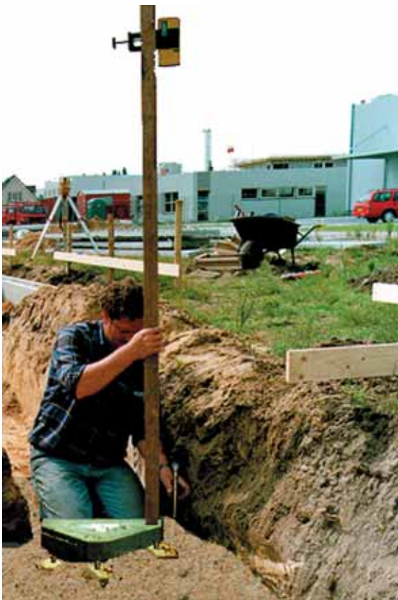
Foto 7.026: Stellen. De bovenzijde van een stel-element wordt met 3 schroeven op de gewenste hoogte gebracht
