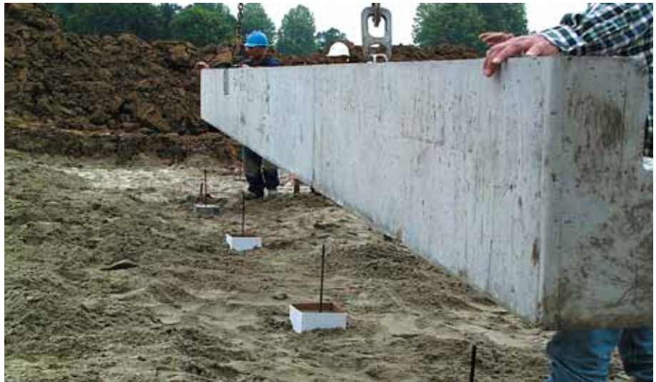
Foto 7.018: Montage balk, waarbij de tussenliggende paalkoppen slechts van een casing zijn voorzien. Deze aangieten via de sparing in de balk
