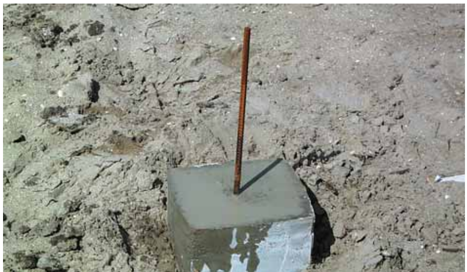
Foto 7.008: De paal is opgestort tot het juiste niveau, de stek is in het gemaakte boorgat geplaatst en de ruimte aangegoten. De paalafwijking was hier zeer klein, zodat de stek vrijwel in het hart van de paalkop staat
