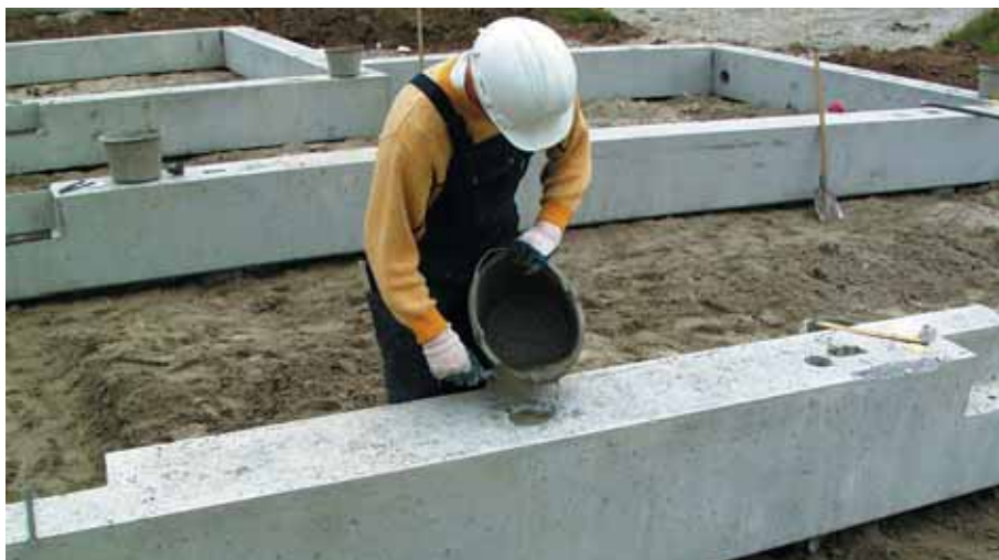
Foto 7.021: Aangieten sparing, waardoor balk en paal verbonden via stek en stelruimte tussen paal en balk gevuld is
