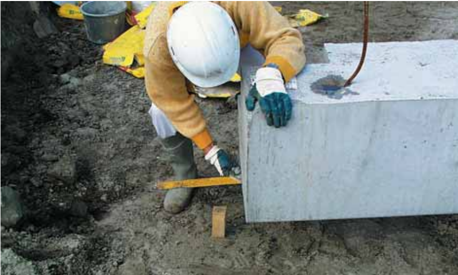
Foto 7.014: Controle positie balk. De steek zit verbogen in de balksparing, passend gemaakt
