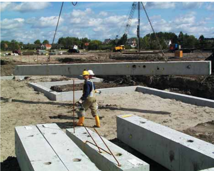
Foto 7.010: Balk in de kraan, zie nu links de inkeping voor de uitwendige hoekaansluiting. Sparingen in balken zijn zeer goed mogelijk, zolang ze de onder- en bovenwapening respecteren - 75 mm vanaf onder- en bovenzijde. Verder ter plaatse van de tand en oplegnok idem. De beugelzone voor de dwarskrachtopname naast kepen dient ook te worden ontzien
