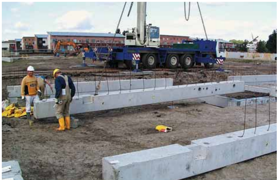
Foto 7.013: Inwendige keep in de balk voor een balk, die daarin wordt opgelegd
