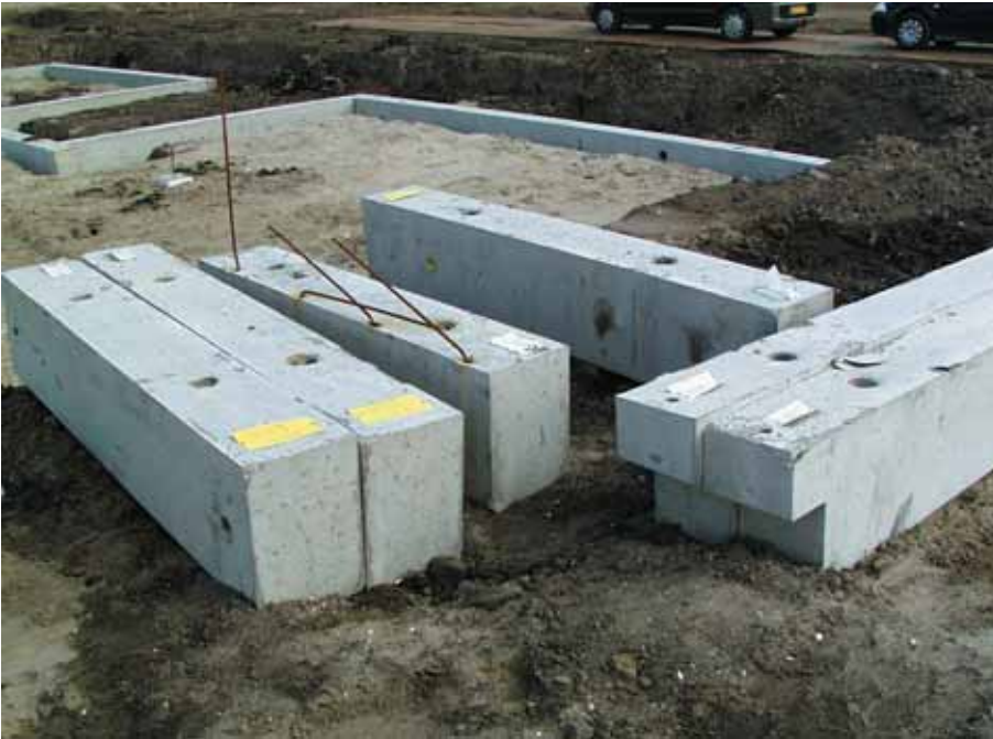
Foto 7.009: Balken aangevoerd. Zie de tand en de oplegnok, ieder een halve (balk - voeg) hoog. De stekgaten zijn duidelijk waarneembaar zowel in de tand als in de balk ter plaatse van de palen
