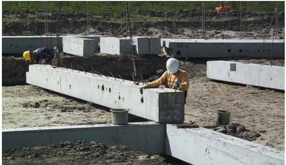
7.012: Maatvoering tijdens montage met piket en de daarin geslagen spijker, zie ook foto 7.014
