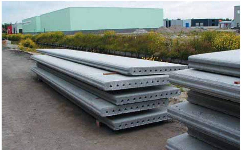
Foto 8.051: Lage kanaalplaten met kleine kanalen, bij dit type 11 kanalen
