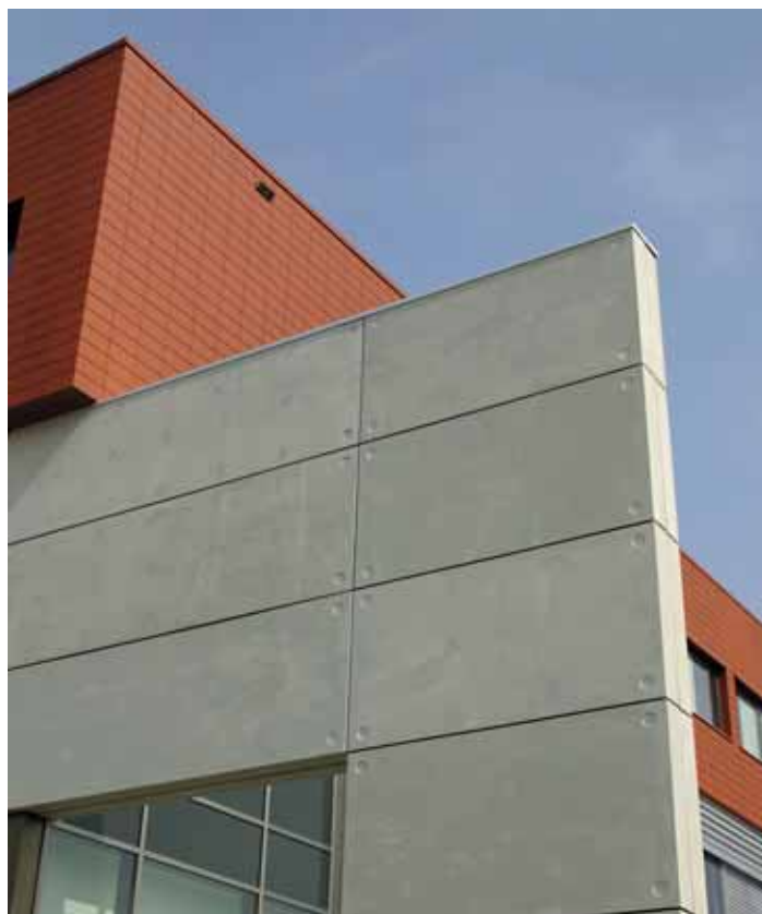
10 | Vormgevend accent de betonnen hoekgevel, eveneens in prefab elementen uitgevoerd
