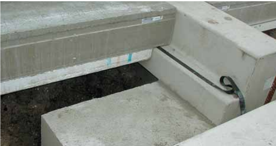
Foto 8.054: Fraai oplegdetail van kanaalplaat op de balk, met de oplegstrip 40 x 3 mm duidelijk in beeld
