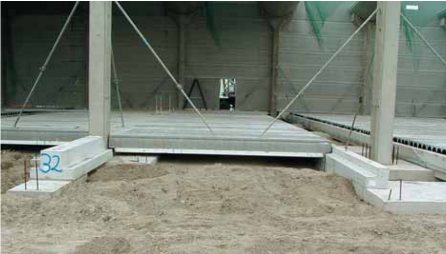
Foto 8.053: Prefab kolom vanaf de poer, vaak begint deze boven de vloer. Zie schoren kolom en oplegkolom tonschaal
