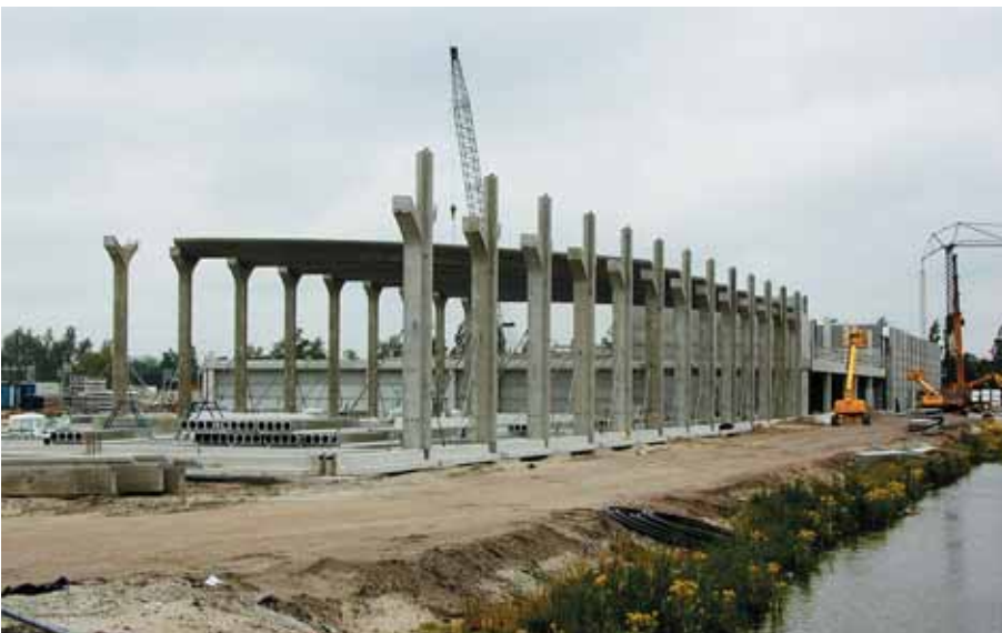
Foto 8.065: Een aantal voorgespannen tonschalen is gemonteerd
