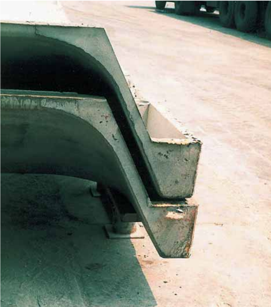
Foto 8.045: Beëindiging van het dakelement, met rechts zichtbaar de goot
