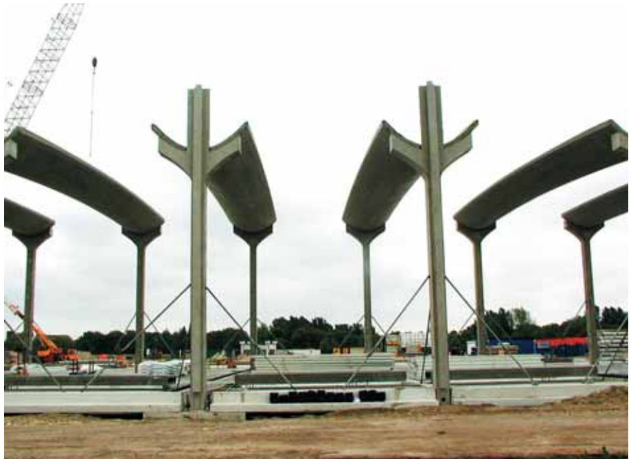
Foto 8.067: Fraai beeld van de slankheid van de constructie en een beeld kan worden verkregen van de hoeveelheid licht, die door de sky-domes straks naar binnen komt
