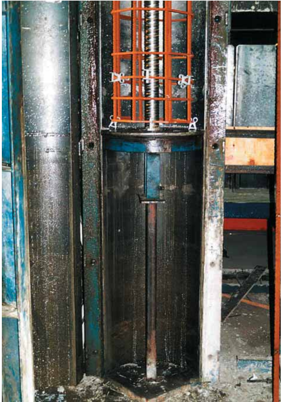
Foto 8.023: Verstelbare bodemhoogte voor een ronde kolom
