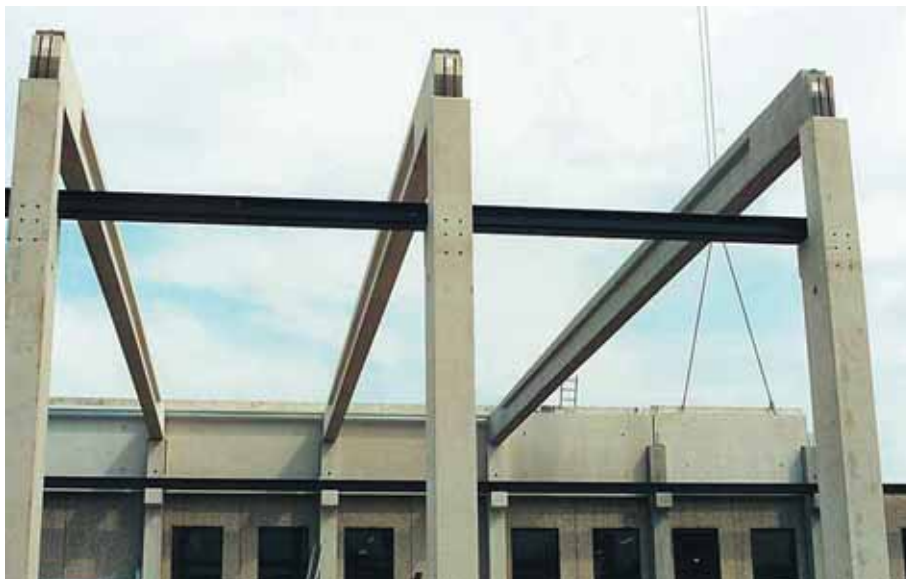
Foto 8.036: De I-balken opgelegd op de kolommen. Een volgende I-balk kan nog op dezelfde kolom. Kraanbaan aan beide zijden
