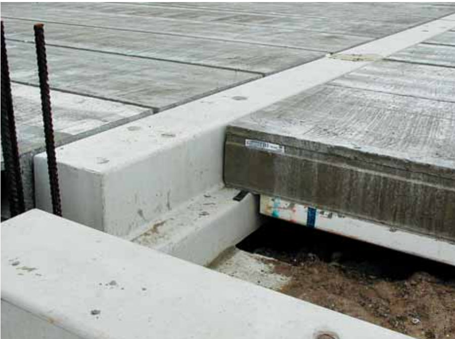
Foto 8.055: Een detail met alle componenten van de begane-grondconstructie
