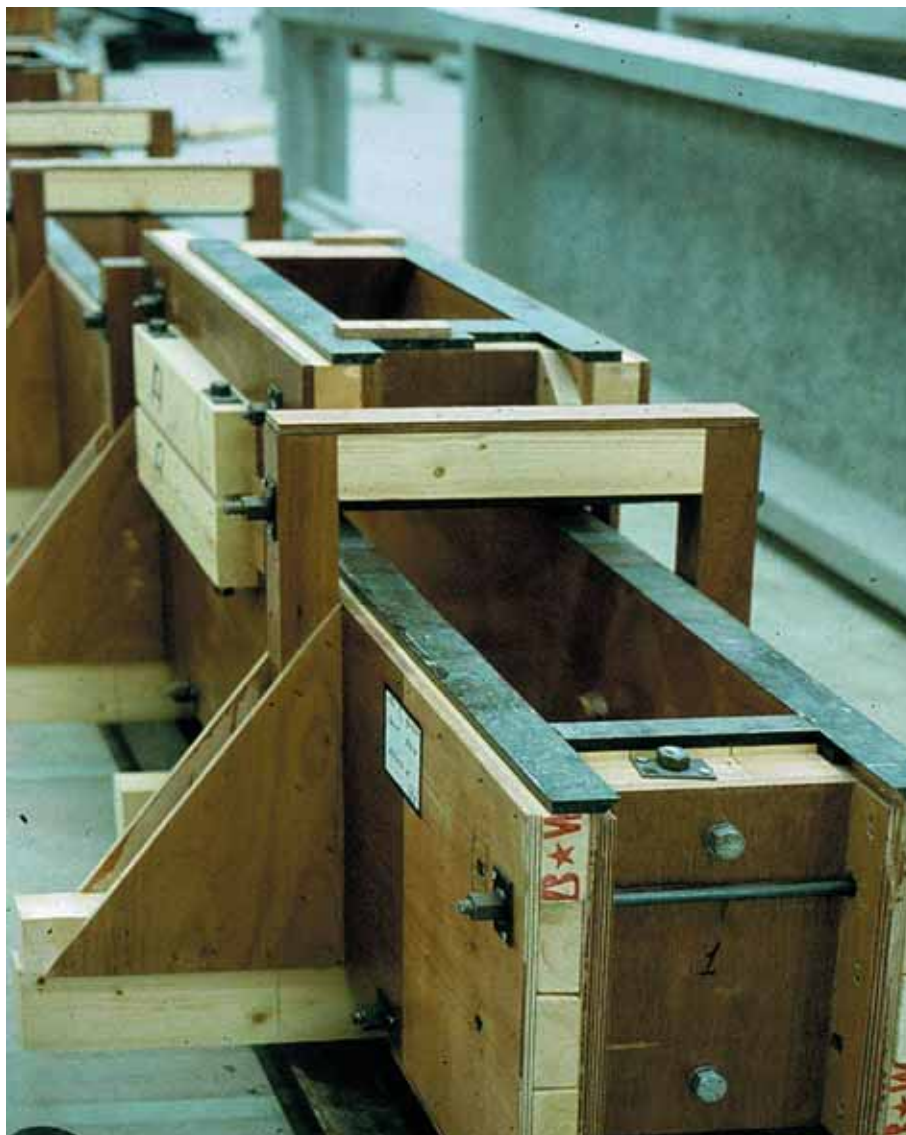
Foto 8.011: Houten mal, gereed voor inbouw voorzieningen en wapening. Zie de gelijmde uitvoering van de malzijden, symmetrisch opgebouwd. Een console aan de bovenzijde van de kolom is voorzien. Het opgesloten kopschot is duidelijk te zien. Door draadeinden en moeren wordt de breedte gefixeerd, noodzakelijk vanwege het optreden van de speciedruk bij het storten
