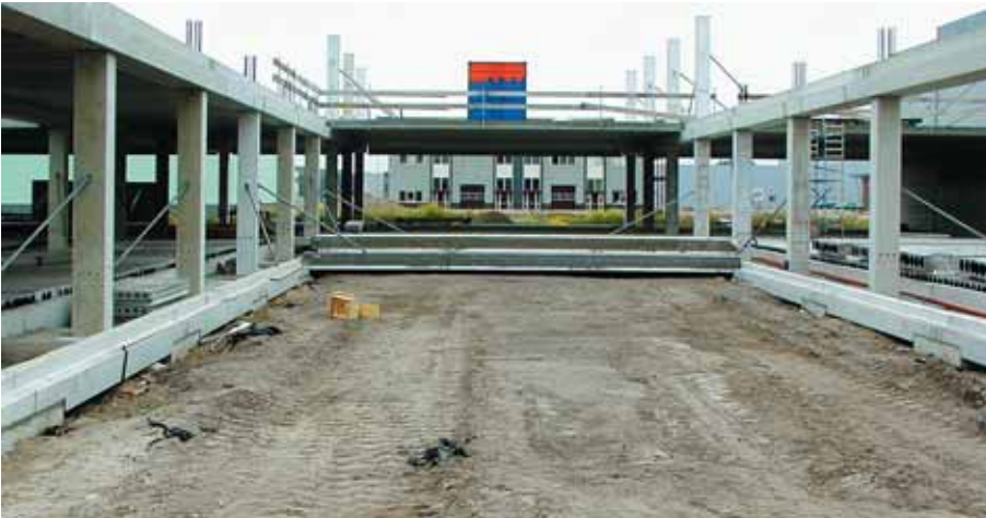
Foto 8.060: Beeld van de constructie, begane grond en eerste laag
