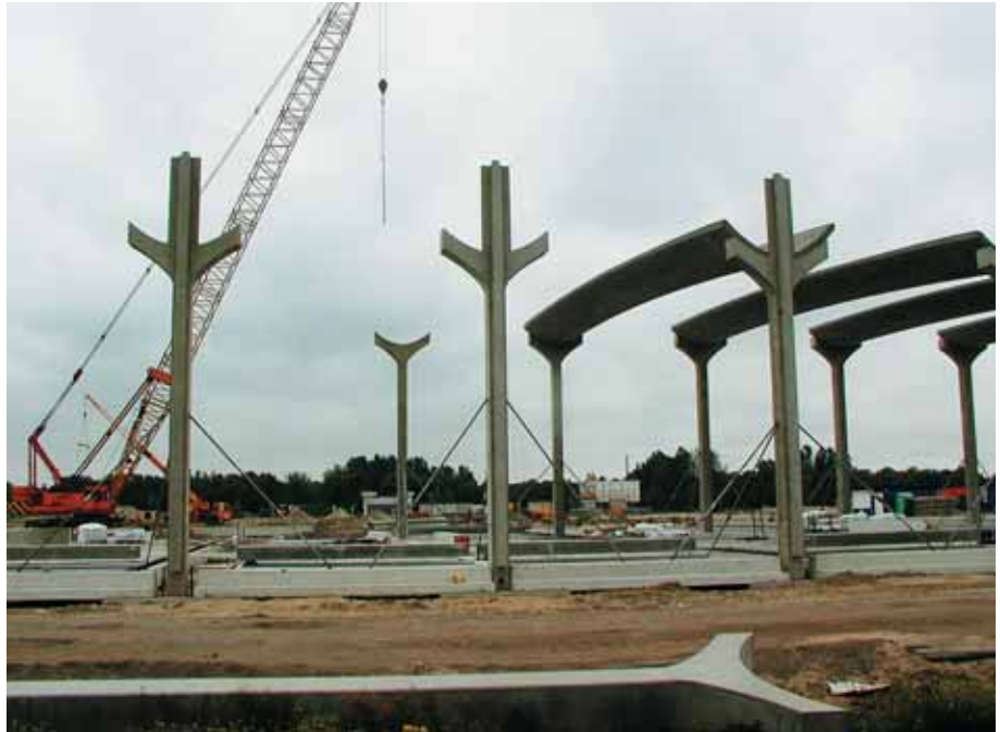
Foto 8.066: Kolommen voor directe oplegging tonschaal en die waarop ook nog verder wordt doorgebouwd
