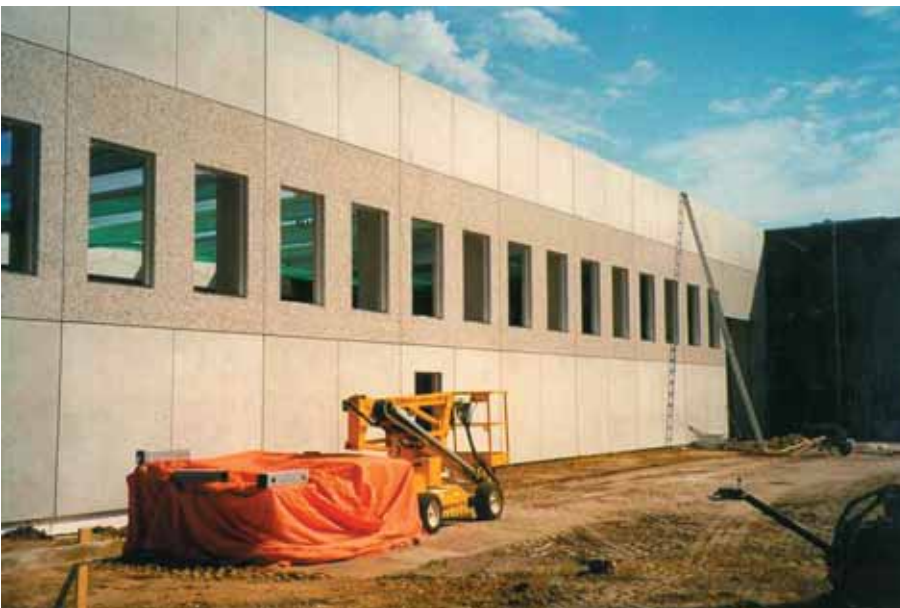
Foto 8.033: Nieuwe hal voor Hurks Beton BV. Gevel met gestraalde elementen waarin de kozijnen zijn opgenomen
