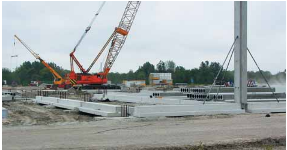
Foto 8.050: Prefab balksysteem al deels gelegd
