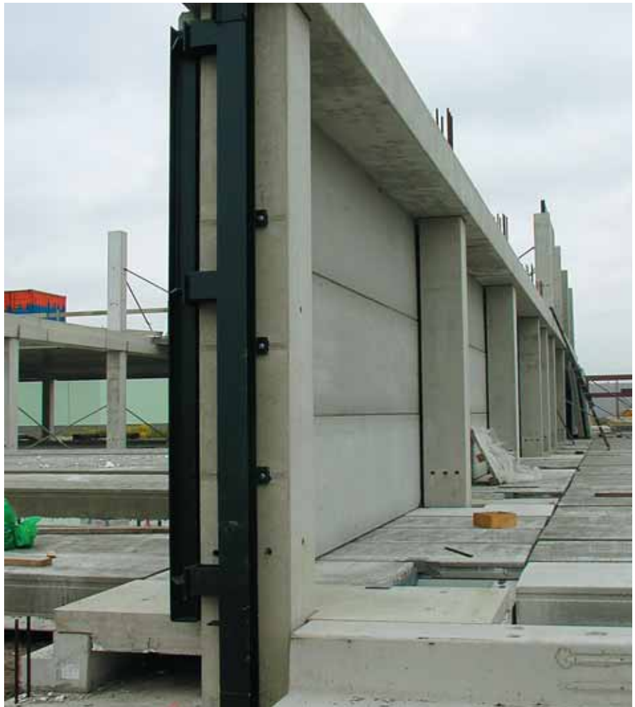
Foto 8.062: Wand voor de kolommen langs
