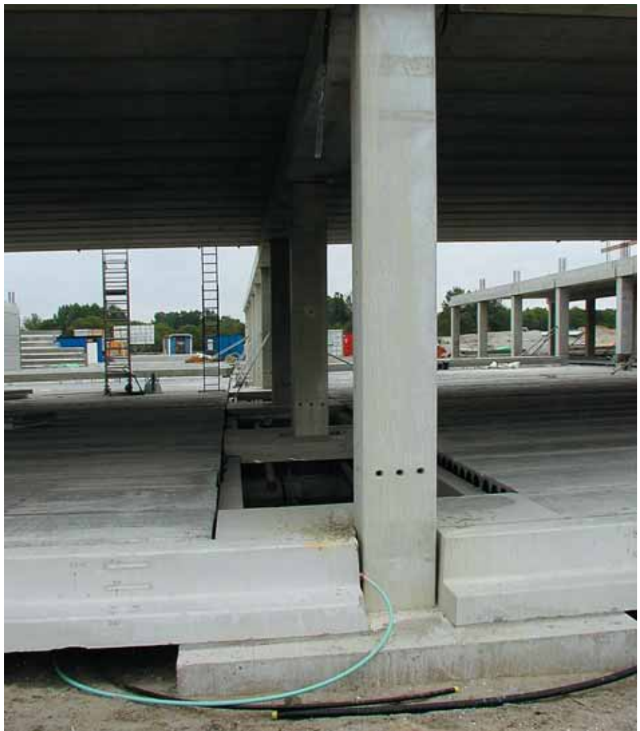
Foto 8.057: Leidingstrook langs de kolommen, Massieve plaat rond de kolom, die de voeg heeft net boven de poer
