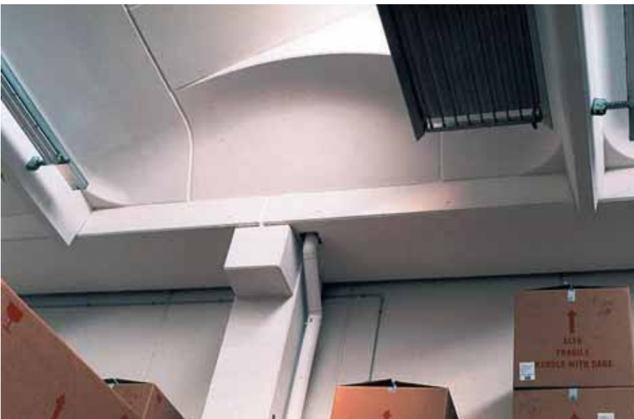
Foto 8.046: Kolom, console, platte balk, dakelement, standaard geschilderd toegeleverd in Italië. Aanzet tot glaspartij in de shed is rechtsboven zichtbaar, net naast het installatierek. De hemelwaterafvoer loopt binnenlangs, direct vanuit de goot. De klimaatomstandigheden vragen niet om dikke pakketten isolatie op het dak
