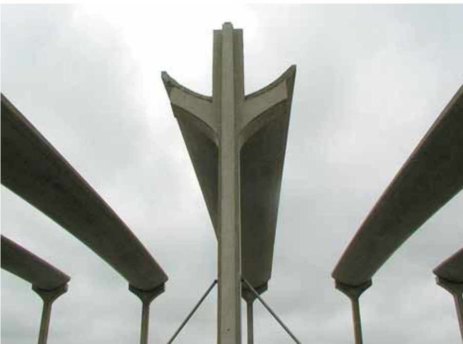
Foto 8.069: De constructie is zeker niet alledaags, een fraai staaltje samenwerking tussen opdrachtgever, architect, adviseur, de aannemer en de prefab fabrikant en leverancier
