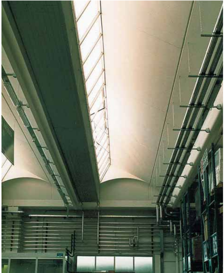
Foto 8.047: Een beter beeld van de dakconstructie in zijn geheel. Fraai ogend, ondanks de industriële omgeving
