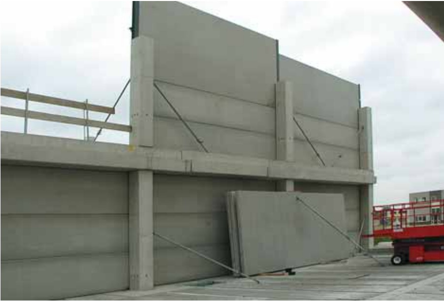
Foto 8.063: Let op montage stabiliteitsvoorzieningen en hekwerken in verband met veiligheid personeel
