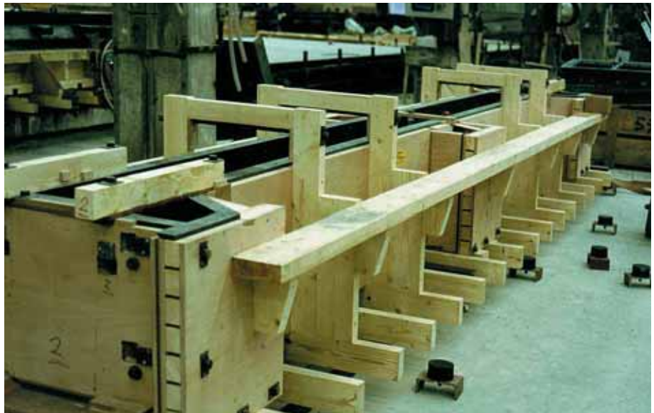
Foto 8.013: Een uitvoering van een mal voor een kolom in een hellingbaangarage. De console zit nu ook boven op de kolom. De stijfheid en vormvastheid van de kolom zijn nu anders uitgevoerd dan bij voorgaand voorbeeld
