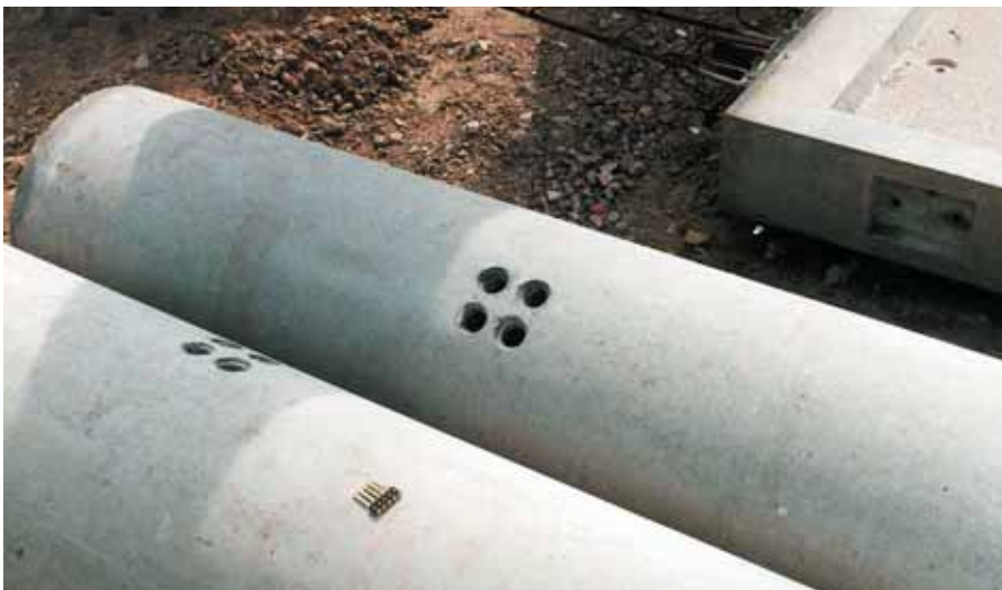
Foto 8.025: Ronde kolom meer in detail, vier gietopeningen in die kolom
