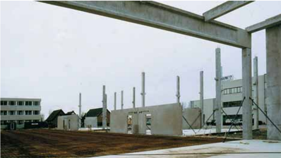
Foto 8.039: Kolommen gesteld, een aantal wanden reeds geschoord aanwezig. Consoles in de lange kolommen aanwezig voor de oplegging van een tussenvloer. De stekken voor de oplegging van de dakbalken op de kolom zijn goed zichtbaar
