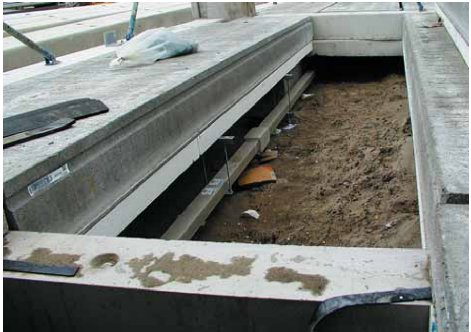
Foto 8.056: Een nog open strook voor leidingmontage
