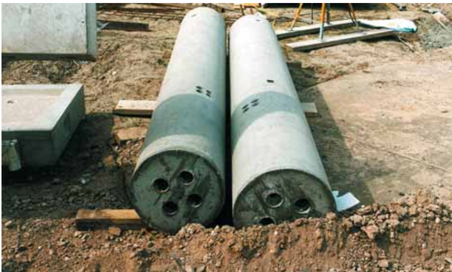
Foto 8.024: Korte ronde kolommen met vier omhullingbuizen voor stekken. De ontluchtingspunten zijn duidelijk zichtbaar en gegroepeerd. De hoogte van deze punten heeft een directe relatie met de steklengte
