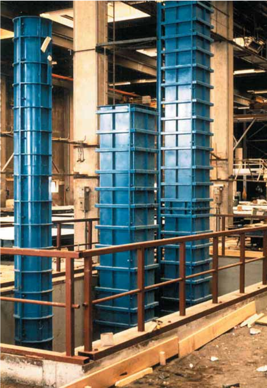
Foto 8.022: Stalen kolombekistingen, rond en rechthoekig, in een put voor staand storten. Storten via een bordes
