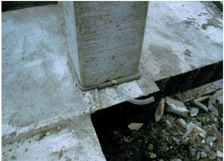
Foto 8.038: Kolomvoet met nog de voeginjectievoorzieningen aanwezig. Aan de kolom kan je een braam zien, hetgeen betekent dat de vellingkant en de malzide met ruimte op elkaar aansluiten. Er kan vuil tussen gekomen zijn
