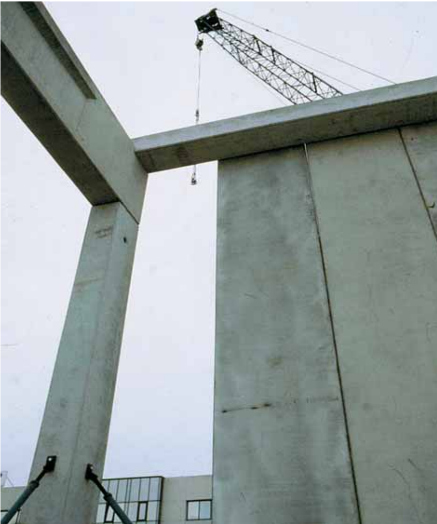
Foto 8.040: Hamereind van de I-balk goed te zien. De gordingen zijn uitgevoerd met een tand vanwege de constructiehoogte. De randgording is zwaarder uitgevoerd, met name in de horizontale richting, vanwege de windbelasting op de zijgevel
