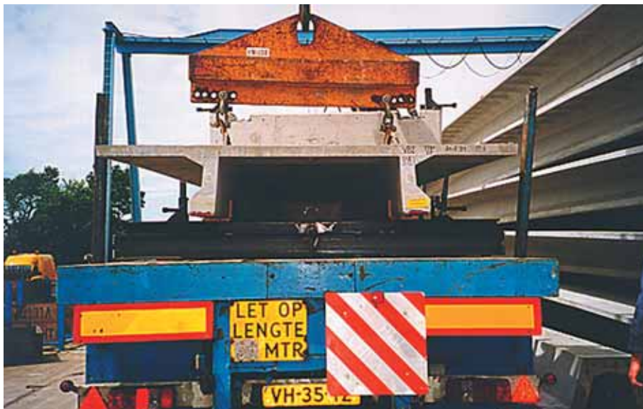
Foto 8.042: STT-dakplaten, een TT-element, waarbij de doorsnede is geoptimaliseerd, ruimte voor de voorspanning onderin is gecreëerd en de dikte van het dek plaatselijk minimaal is, doordat aan de onderzijde cassetten zijn gemaakt. Op de foto kan men deze duidelijk zien op de stapel elementen aan de rechterzijde. Aanvoer van elementen
