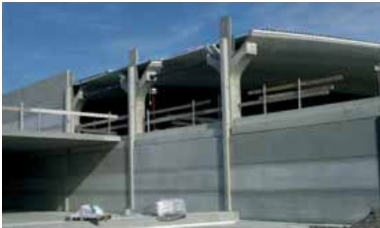
2 | Volledig prefab draagconstructie tweelaagse gebouwdelen (boven)
