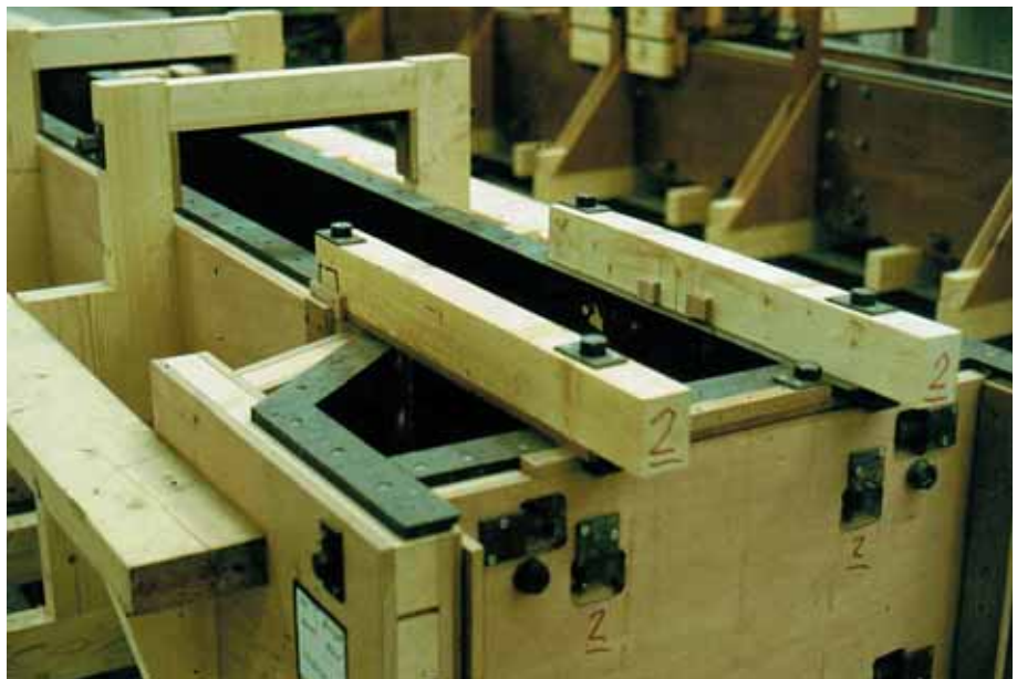
Foto 8.014: Een opname meer in detail. Zie dat de vellingkanten worden gevormd met een strook haukarit, gerecyclede kunststof. De dikte van de malzijden is noodzakelijk om de kolomzijden recht te houden tijdens het storten
