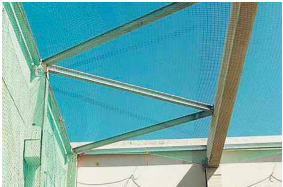
Foto 8.035: De I-balk en het schoorverband in het dakvlak, dat de windkrachten naar het gevelvlak voert
