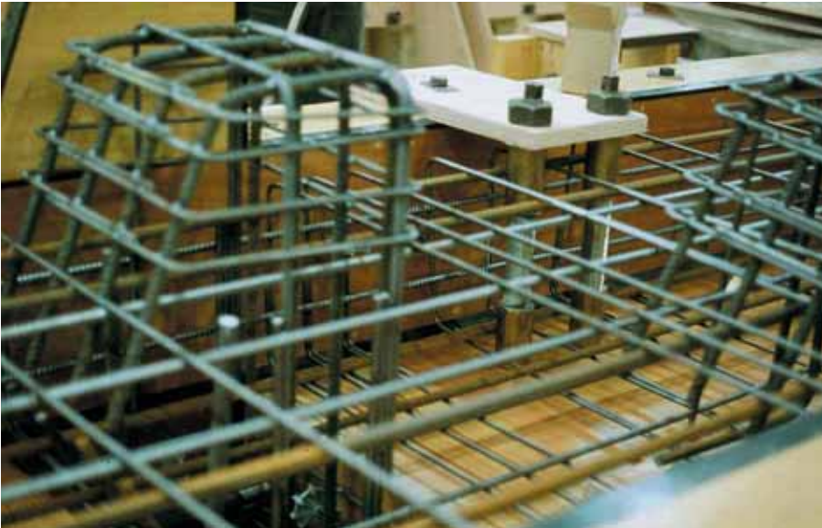
Foto 8.015: Een deels ingebouwde kolom voor een hellingbaan van een parkeergarage met een console in de bodem, zie linksonder, en op het bovenzvlak. Zie ook de wijze waarop de ankers aan de stortzijde zijn opgehangen
