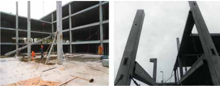
Foto 8.020b: De foto's laten het skelet in opbouw zien
