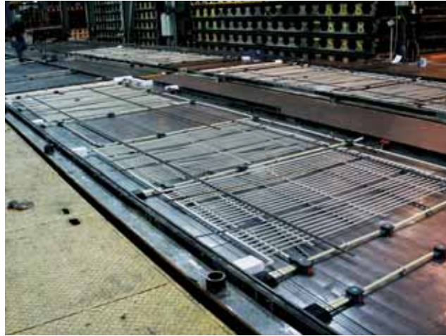
2 | Experiment met de warmtewand; verwarmingselementen worden ingestort
