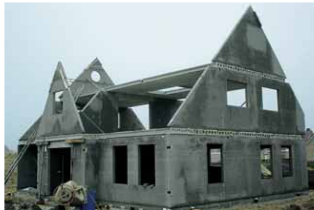
Casco (montage) in aanbouw
