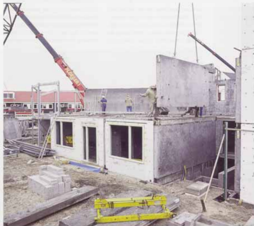
Montage wandelement Foto: Van Lee & Partners
