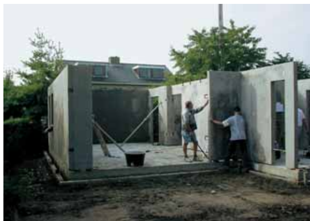
Montage begane grond
