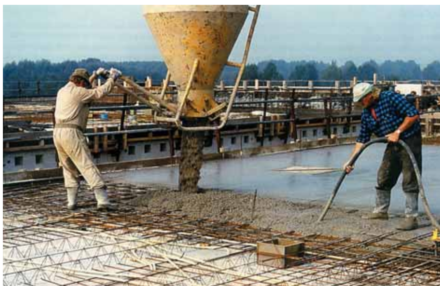
Foto 9.034: Storten druklaag bekistingsplaatvloer
