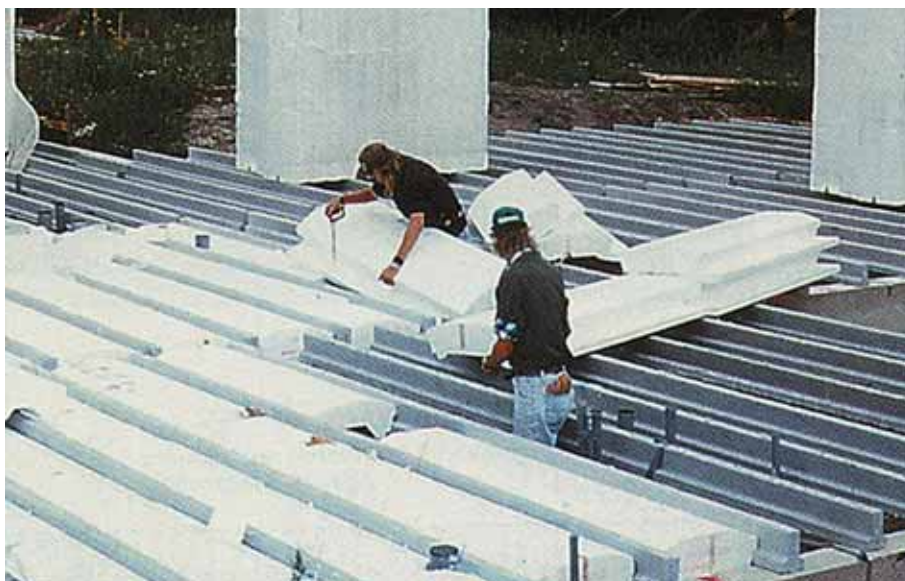
Foto 9.020: Montage combinatievloer
