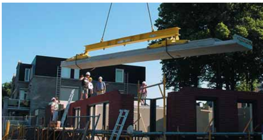
Foto 9.035: Montage van een Leidingvloer van VBI, een nieuw type kanaalplaatvloer
