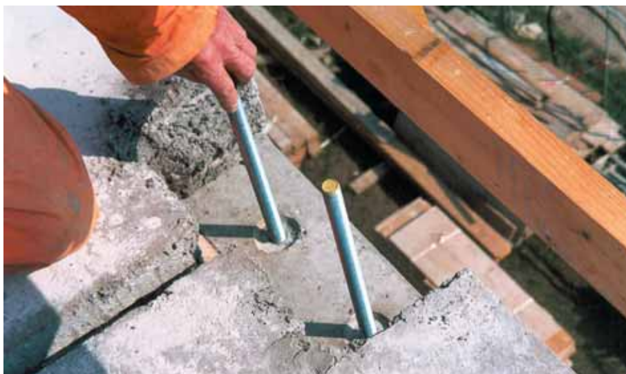
Foto 10.046: Draadeinden worden ingedraaid. Voorbereidingen voor het stellen van blok
