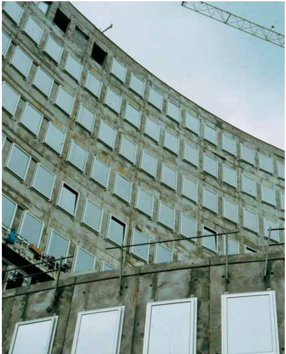
Foto 10.002: De ruwbouw is uitgevoerd met wandelementen waarin de kozijnen al waren voorgegemonteerd. Bouwmateriaal moet per verdieping worden aangevoerd, gelijk opgaand met de montage. Met de hangsteiger worden vervolgens isolatiemateriaal en gevelbekleding aangebracht. Buitenafwerking is een activiteit die los staat van de binnenafwerking van de ruwbouw
