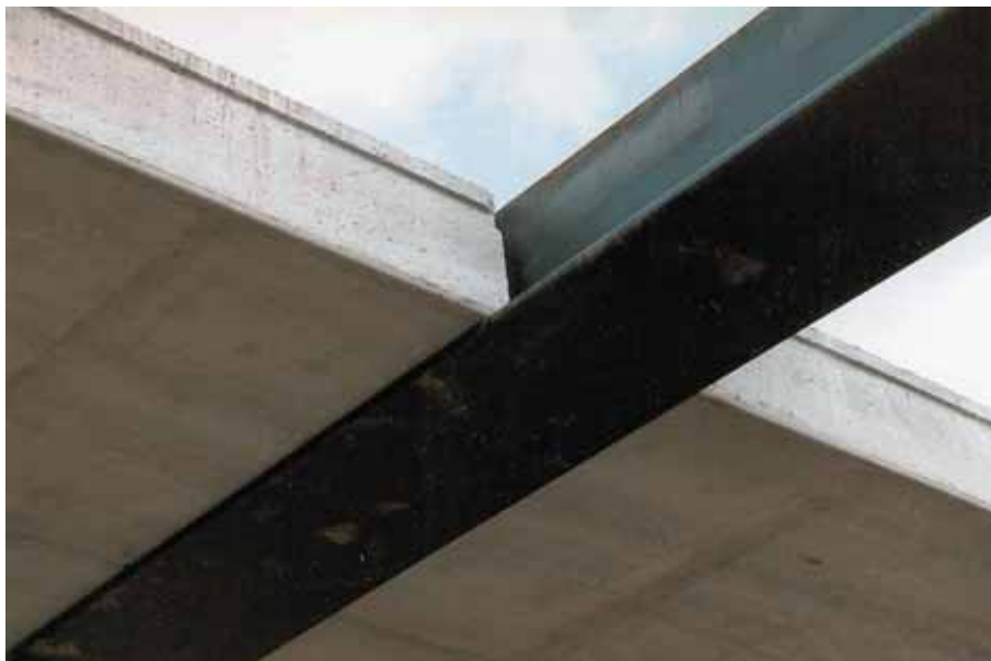
Foto 10.084: Kanaalplaten ondersteund door een hoedligger
