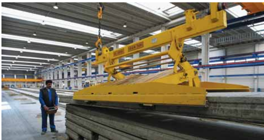
Foto 10.011: De geproduceerde kanaalplaat wordt na het verharden gezaagd en getast in de hal, voorafgaand aan de afvoer naar het tasterrein. Hier het stapelen, waarbij de gebruikelijke klem wordt gebruikt, die in de langsgroef klemt
