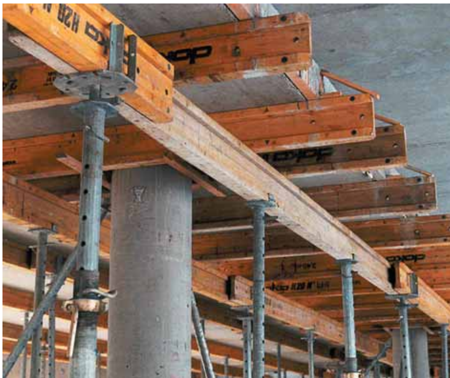
Foto 10.065: Onderstempelde bekistingplaatvloer met kolomstrook, verlaagd vloerdeel
