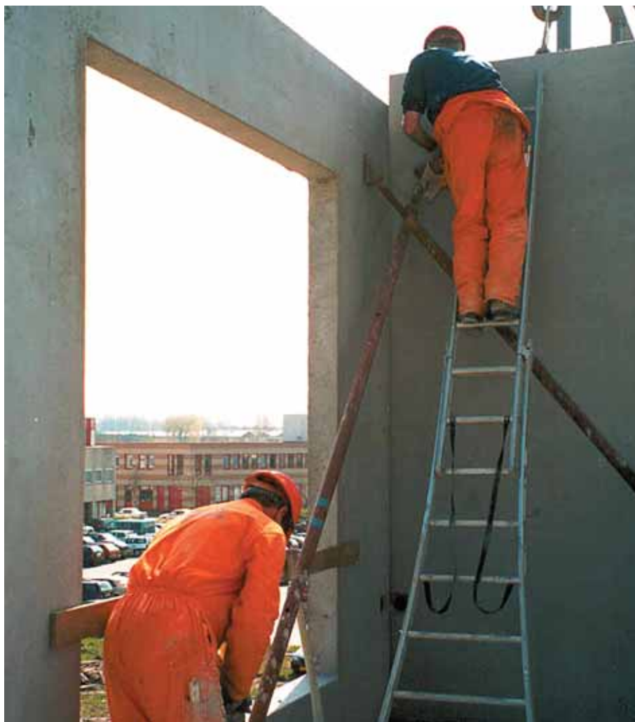
Foto 10.061: Stellen van een wand loodrecht op de langsgevel
