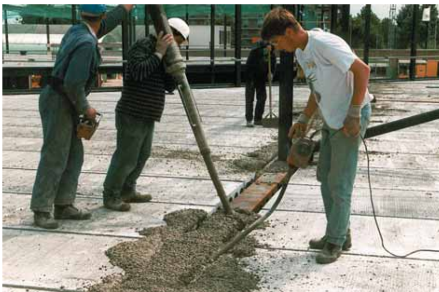
Foto 10.089: Aanstorten van de strook tussen de kanaalplaten inclusief de DELTA-beam
