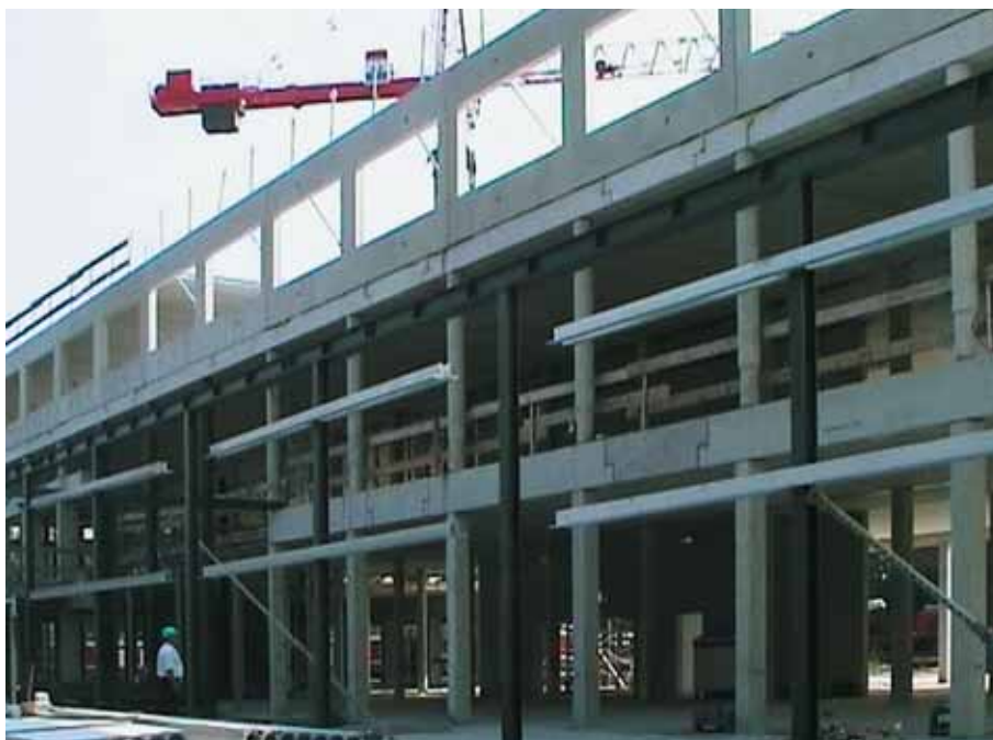
Foto 10.109: De opbouw is in volle gang. Let op de als gerber-ligger uitgevoerde betonbalken
