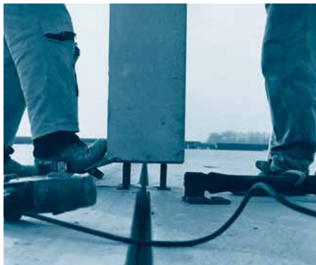
3 | Plaatsing van de kolom compleet de verbinding
