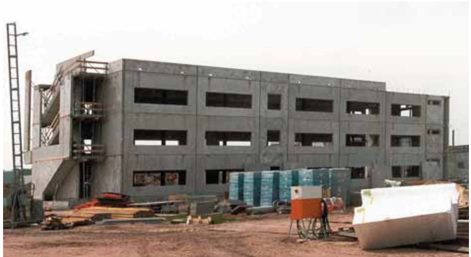
Foto 10.004: Ruwbouw, dragende wanden en bekistingplaten van een kantoorgebouw te Veldhoven
