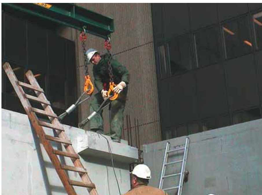
Foto 10.139: Manoeuvreren op het element, de kettingen hangen aan de evenaar, de haken kunnen los, de hijsslussen losgedraaid
