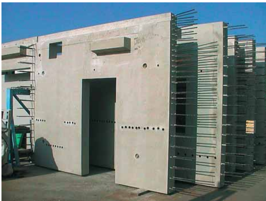
Foto 10.026: Een kernwand met zeer veel wapening en door te stekken staven, zie gietopeningen. De ingedraaide stekankers aan de zijkant worden gebruikt om een natte verbinding tussen de kern-delen te storten
