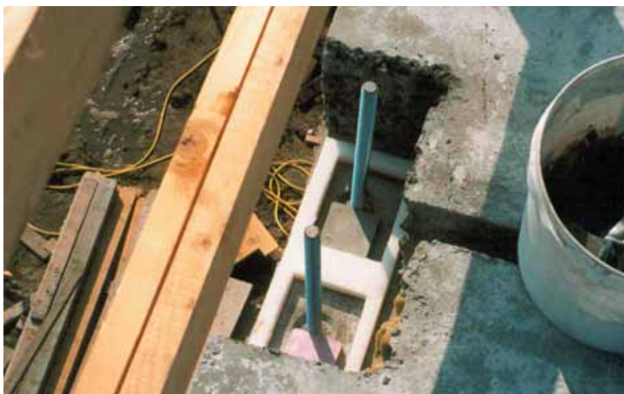
Foto 10.047: Sparingen in de kanaalplaten zijn gestoken, dus niet glad. Prop minerale wol dicht het kanaal af op de plaats van de sparing. De voorzieningen om een volgend LEVO-blok aan te brengen zijn begonnen. Kunststofmal gelegd en de draadeinden ingedraaid
