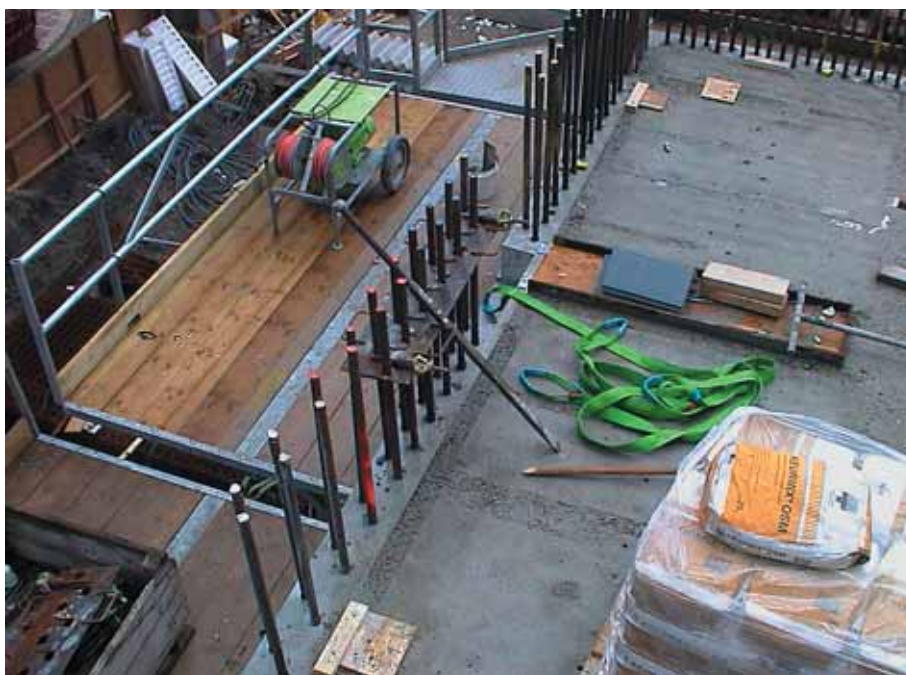
Foto 10.131: Stekken geplaatst, moeten op maat zitten, zie ook de boormal over een deel van de stekken
