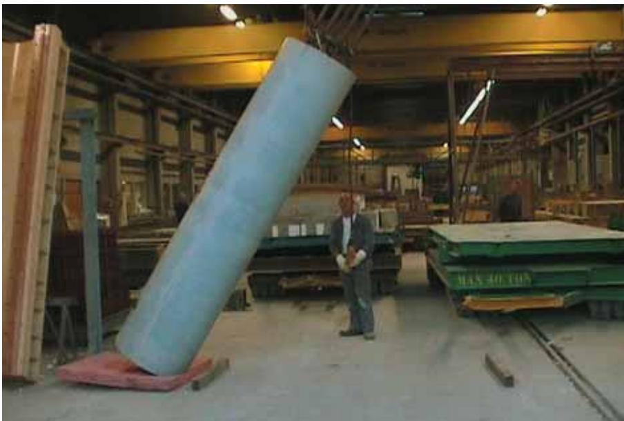
Foto 10.119: Kolom ontkist en wordt afgevoerd. Stroppen om wapeningstaven
