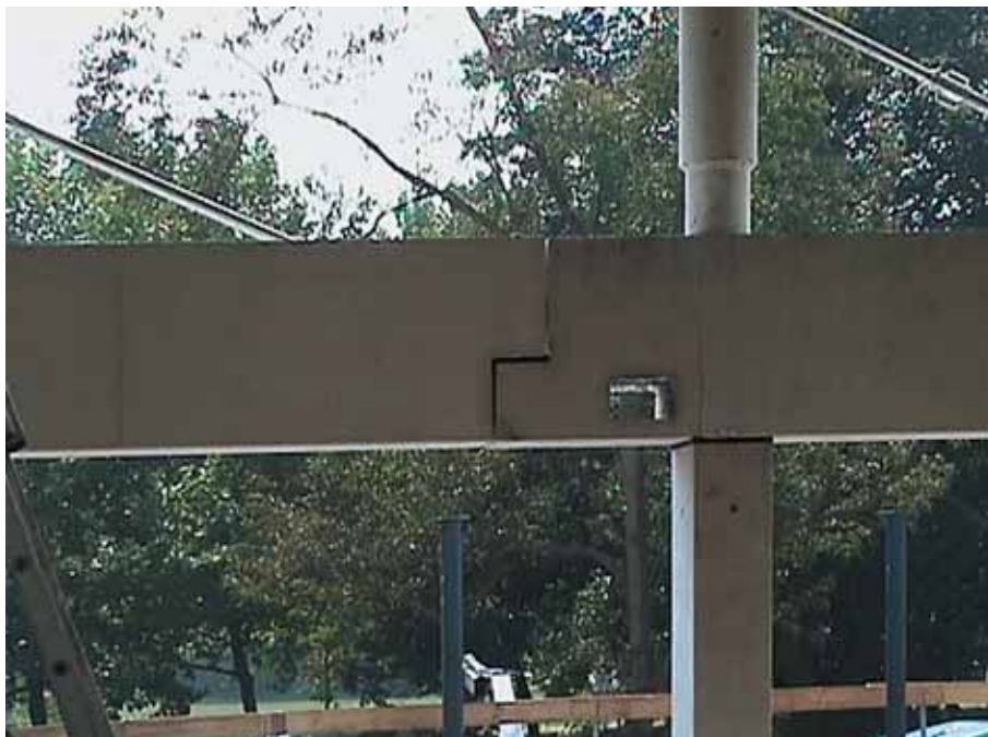
Foto 10.113: Detail, balk met overstek, daarop rust de ingehangen balk
