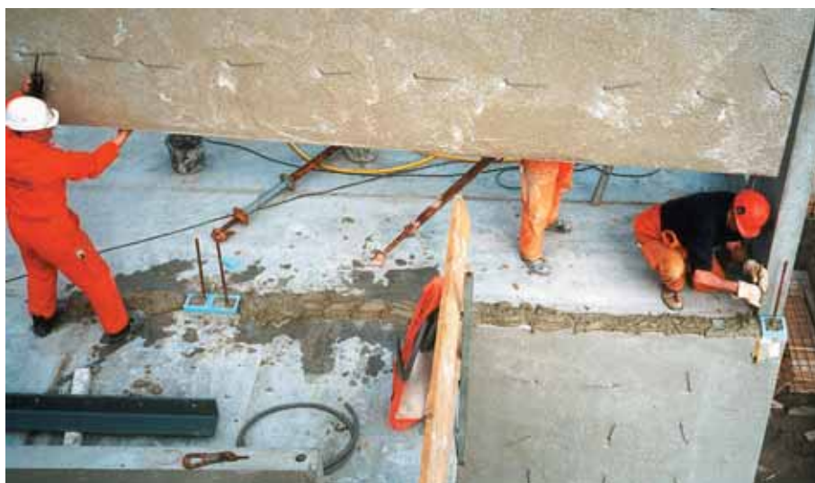
Foto 10.062: Alles is gereed om het wandelement te gaan stellen. Element in de kraan
