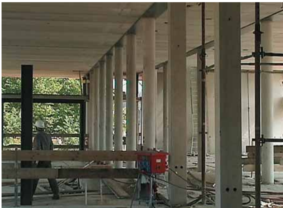
Foto 10.112: Tussenbalken voor de opvang van kanaalplaatvloer, stalen ligger
