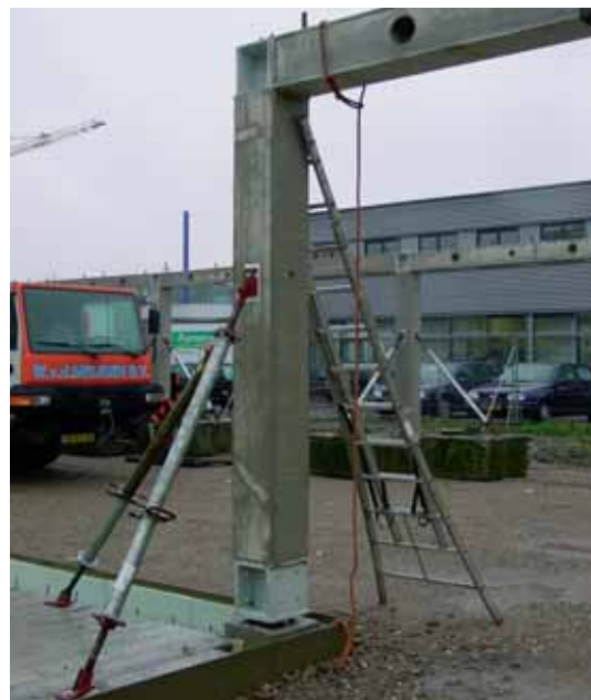
3 | Betonnen kolom in het werk gesteld
