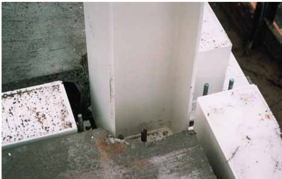
Foto 10.086: Stalen balken met kolom, omsloten door kanaalplaten
