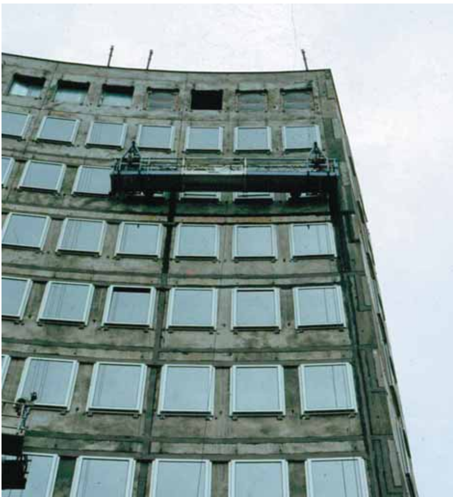
Foto 10.003: Het aanbrengen van isolatie- en gevelmateriaal gebeurt vanuit de hangsteigers. Bovenin zijn gaten gespaard voor de aanvoer tijdens de bouw
