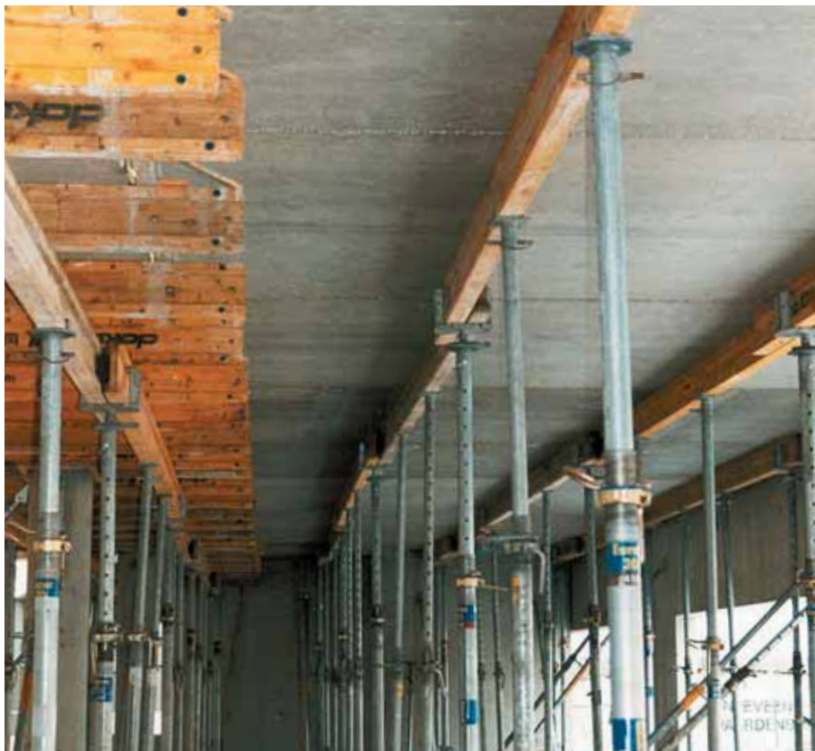
Foto 10.066: Stempels moeten blijven staan tot de bovenliggende vloer is gestort en voldoende is verhard. Het stortgewicht van de volgende vloer wordt dan verdeeld over twee vloeren!
