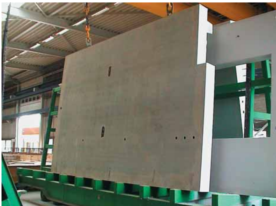
Foto 10.015: Het hangt in de kraan
