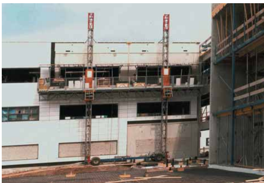
Foto 10.034: Met de hangsteiger worden vervolgens isolatiemateriaal en gevelbekleding aangebracht
