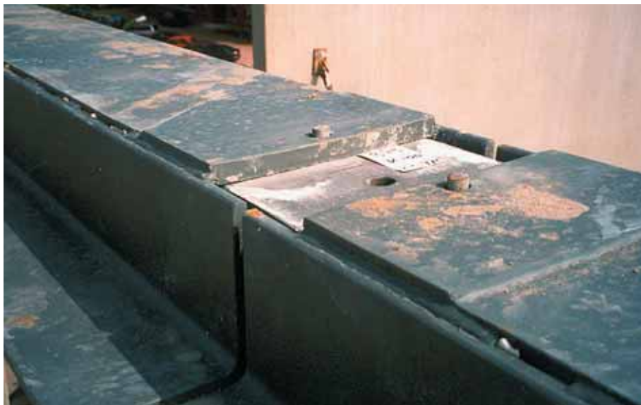
Foto 10.059: Opgelegde LEVO-balken ter plaatse van de kolom
