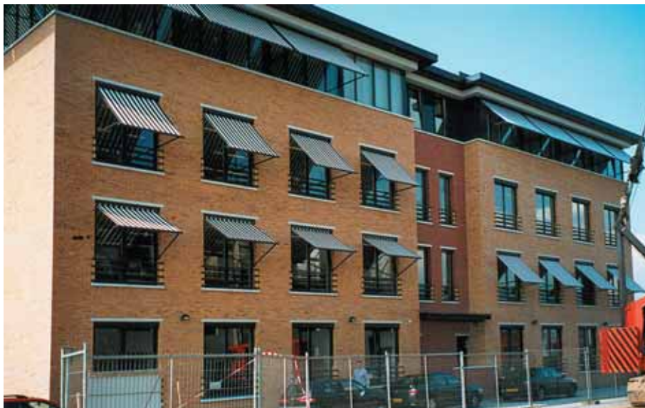
Foto 10.064: Gereed gebouw, structuur bekleed met metselwerk
