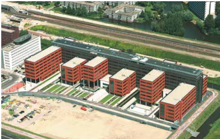
Foto 10.105: Cisco Campus te Amsterdam; voorbeeld van een uitvoering van dragende wanden met kanaalplaten, kolomondersteund
