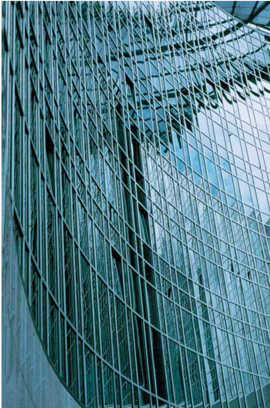
Foto 10.001: De bouwwijze met dragende wanden geeft de architect vrijheid van vorm en een vrije keuze in gevelafwerking. Dit gebouw, KPN Telecom te Amsterdam, is uitgevoerd met een rond gevelvlak, dat voor de achterliggende wanden met veelhoeken is benaderd
