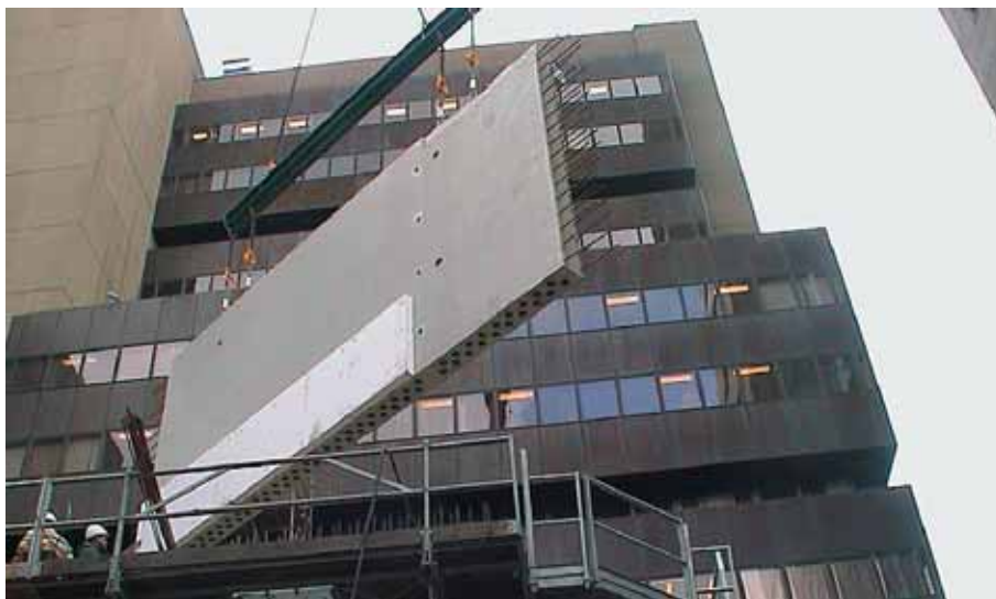
Foto 10.125: Kantoorgebouw De Splinter te Rotterdam, voorbeeld van een lastige uitvoering, zwaar belaste elementen, dus veel wapening en veel stekken
