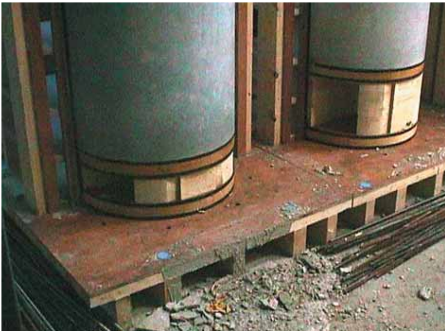
Foto 10.116: De kolommen, verticaal gestort. Steellengte aan de onderzijde gecorrigeerd
