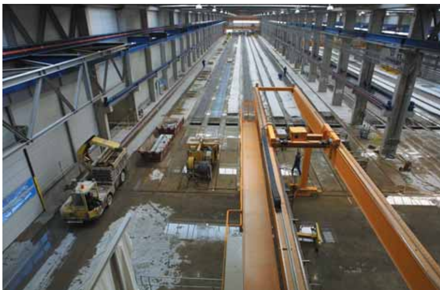
Foto 10.009: Overzicht van een productiehal voor kanaalplaatvloeren. De baanlengte is 150 m. De kanaalplaten variëren voor de kantoorbouw tussen 200 en 400 mm dikte
