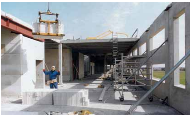
1 | Montage van het Mxb-5-systeem
