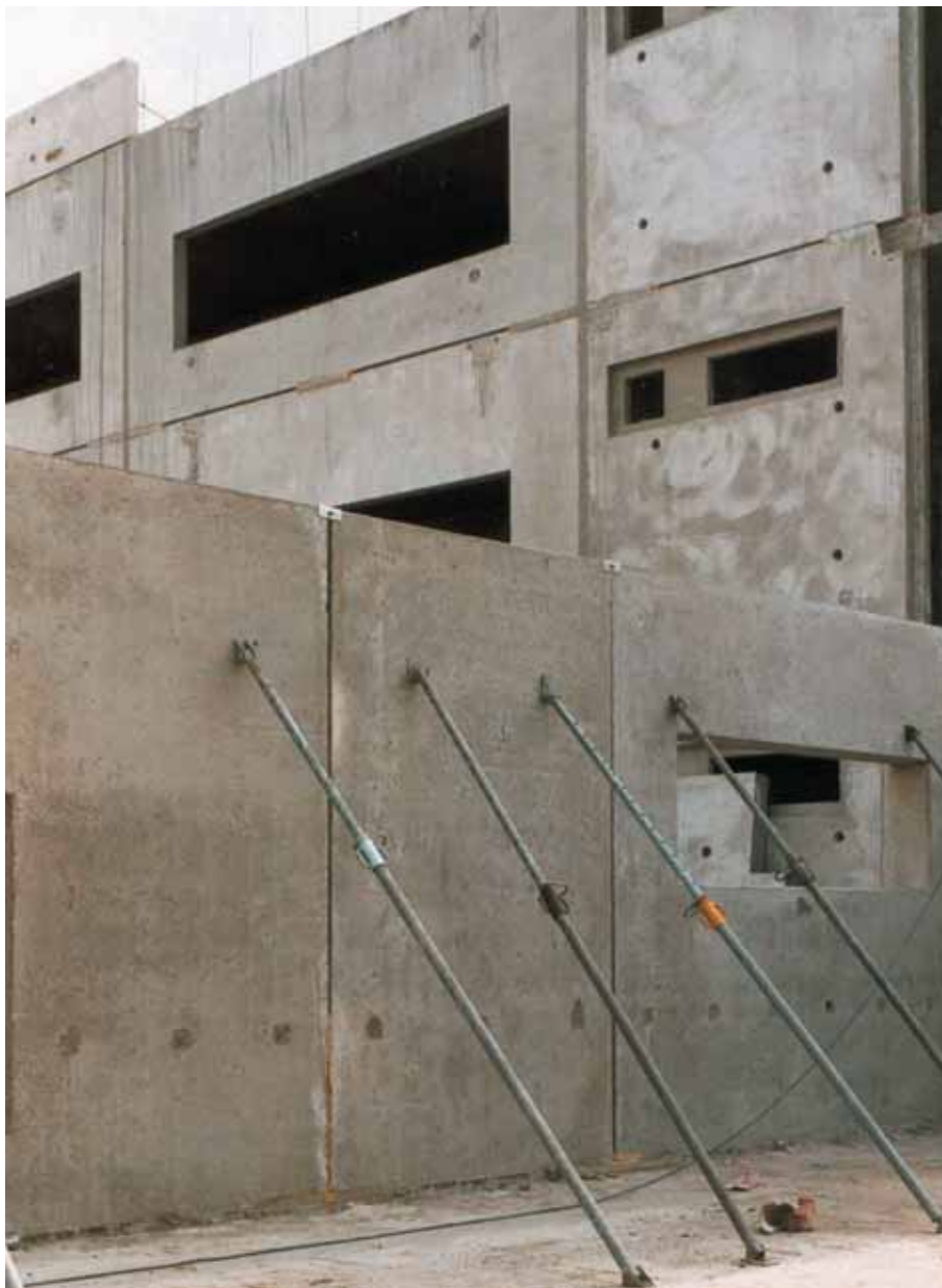
Foto 10.032: Geschoorde wand. De gebouwstructuur met de mortelvoegen onder de penanten en in het midden zijn goed waarneembaar. De middelste voeg met stek is van belang voor de horizontale krachtoverdracht (zoals wind) en niet voor de verticale, maar wordt daardoor wel beïnvloed!
