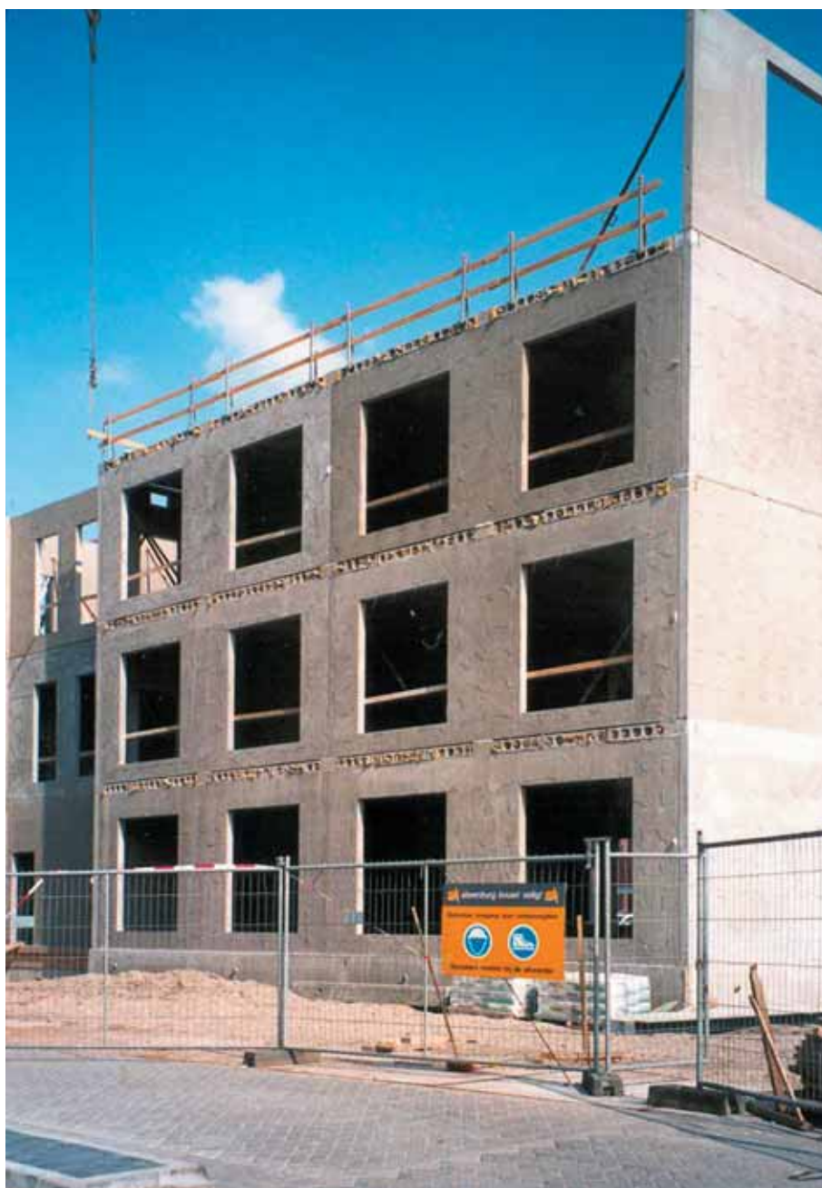
Foto 10.040: Ruwbouw gevelfragment met kanaalplaten - vrij - tussen de vloeren in. De dragende LEVO-blokken zijn duidelijk te onderscheiden. De montage gaat verder
