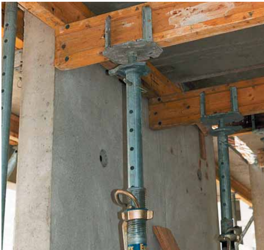
Foto 10.067: Vloeraansluiting bij de wand
