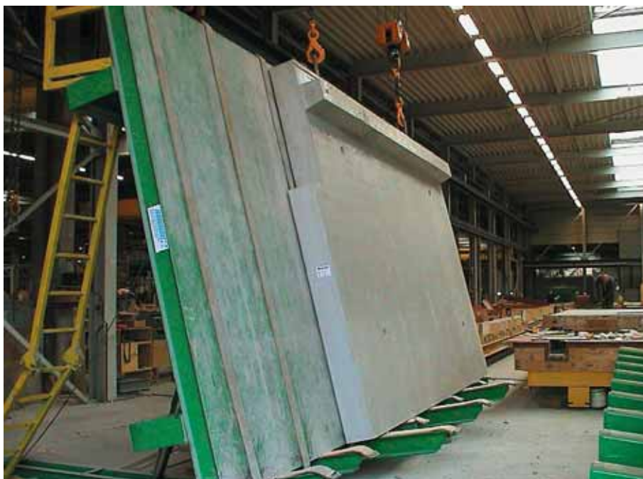
Foto 10.013: Het gebruik van kanteltafels voorkomt scheurvorming in de jonge elementen bij het ontkisten en spaart wapening. In het vlak van de wand is deze sterk en stijf. Ook het hijsmiddel wordt op de juiste wijze gebruikt; in de asrichting belast
