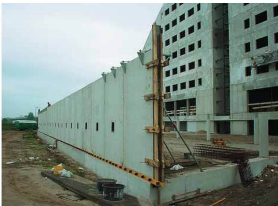
Foto 10.150: Wand toegepast boven maaiveld voor een parkeergarage
