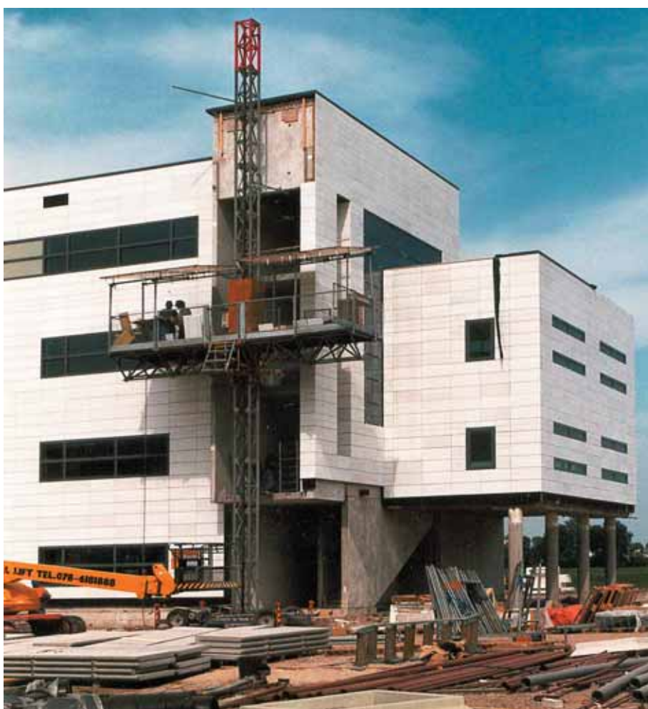
Foto 10.080: Kantoorgebouw te Veldhoven; de gevel is grotendeels gereed
