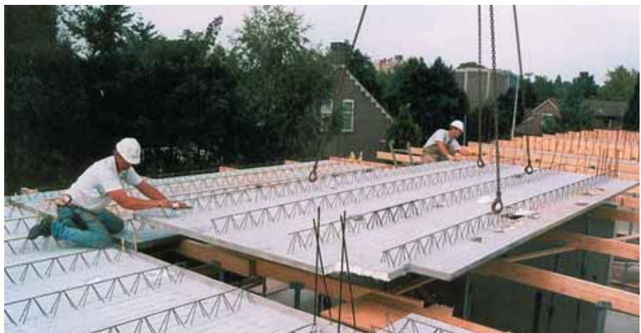
Foto 10.069: Leggen van een bekistingplaatvloer. Hijsen aan de tralieliggers
