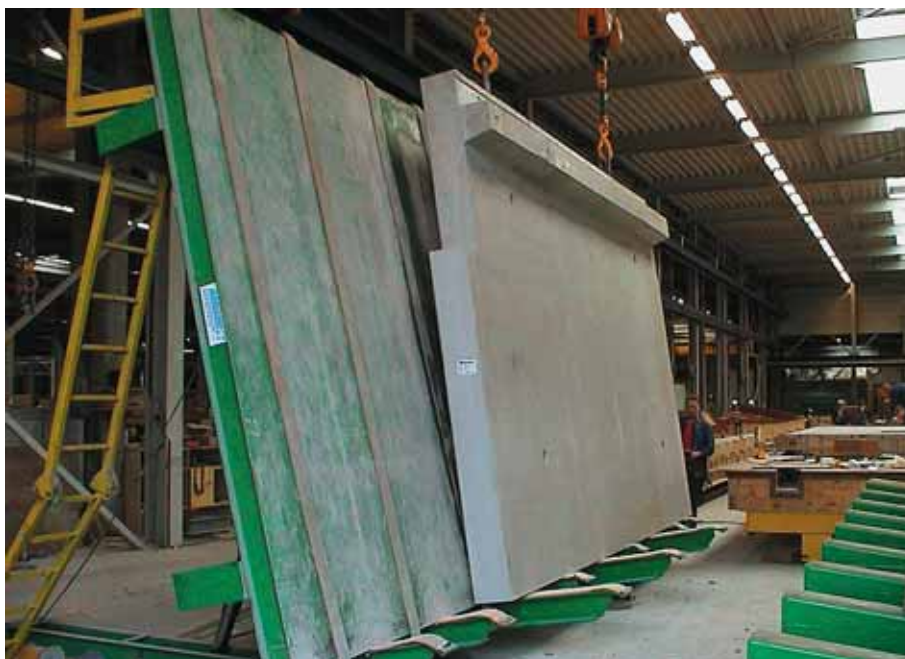
Foto 10.014: Het wandelement komt los
