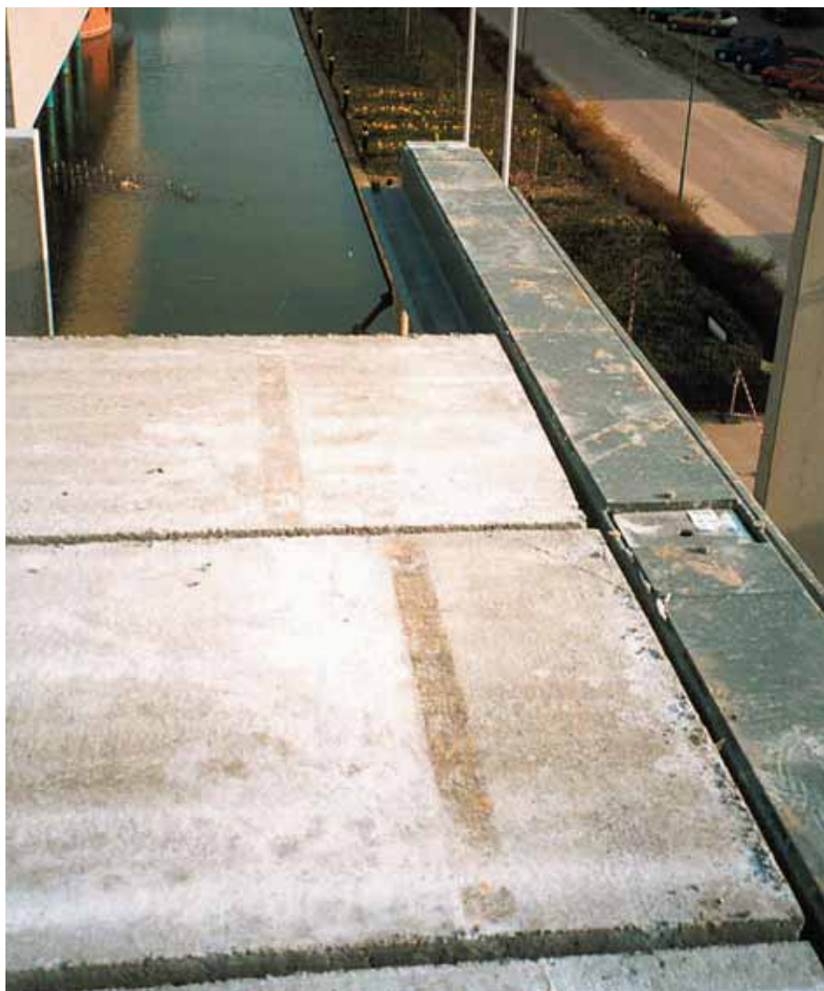
Foto 10.057: Stalen randbalk. De oplegplaat is duidelijk te zien, waar nog geen kanaalplaat is neergelegd
