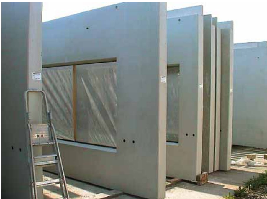
Foto 10.025: Elementen in opslag op de tas. Tijdelijke voorziening om raamsparing te dichten is aangebracht
