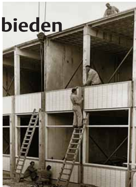
1 | Scholenbouw in de jaren zestig werd gekenmerkt door starre systeembouw
