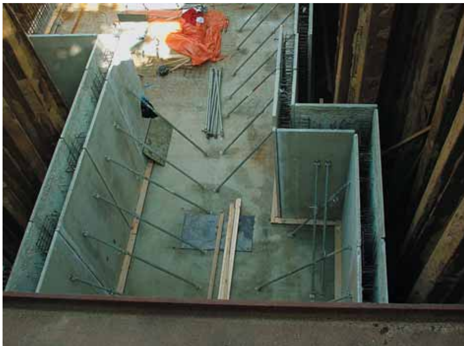
Foto 10.149: Kelder in 3 lagen onder maaiveld. De verbindingswapening bij de naden is nu goed te zien
