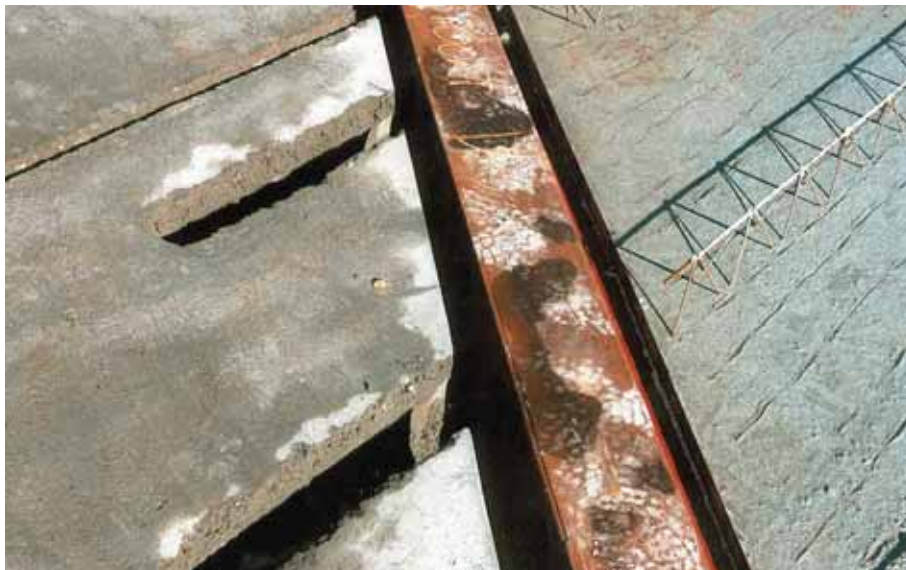
Foto 10.071: Schuine ontmoeting kanaalplaat, stalen balk en bekistingplaat
