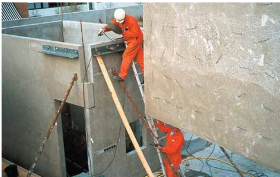
Foto 10.063: Het wandelement hangt gereed. Nog even lassen ter plaatse van de kern
