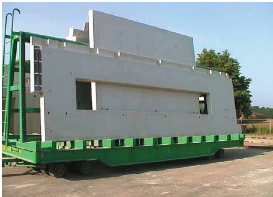
Foto 10.024: Een verzameling elementen op weg naar het tasterrein. Zie de gietopeningen in het element onder de raamsparing
