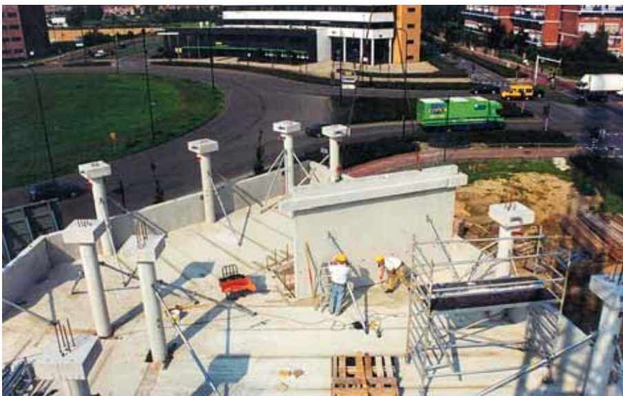
Foto 10.093: Gebouw met een gemengde uitvoering van skelet en wanden.
