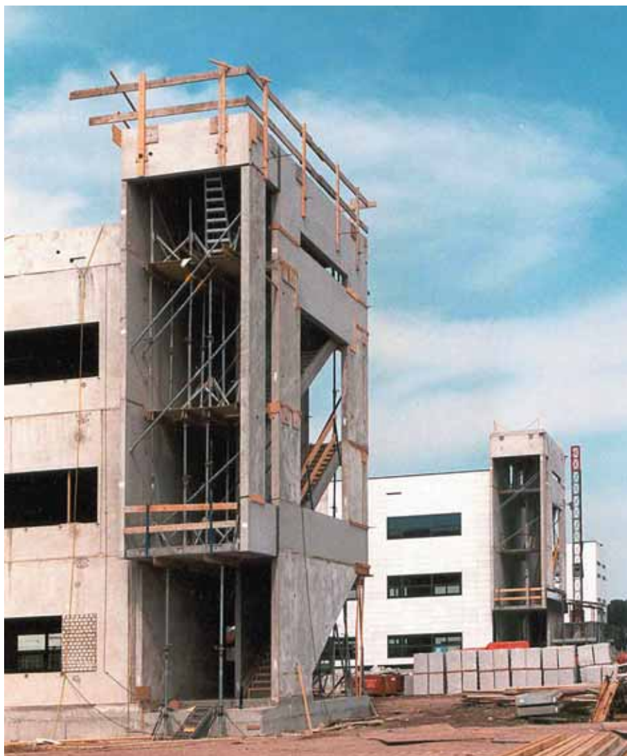
Foto 10.033: Trappenhuis staat nog in de stempels
