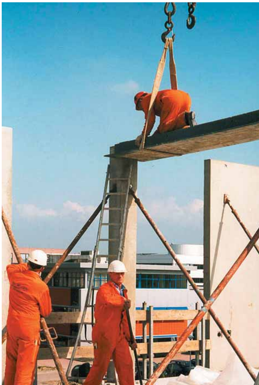
Foto 10.056: LEVO-balk wordt neergelegd op de gestelde kolom. Een trapje is nog steeds onmisbaar in de bouw
