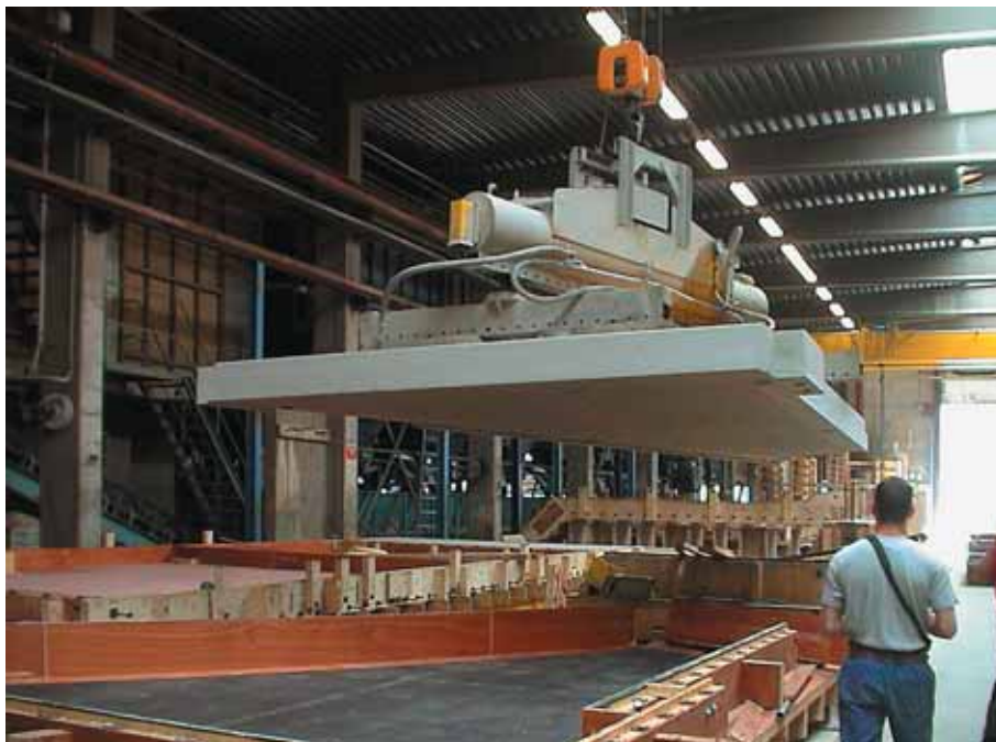
Foto 10.023: Fraaie mal voor een balkonplaat met een ingelegde rubbermat voor het verkrijgen van een stroef oppervlak. De bovenzijde van de balkonplaat is altijd malzijde
