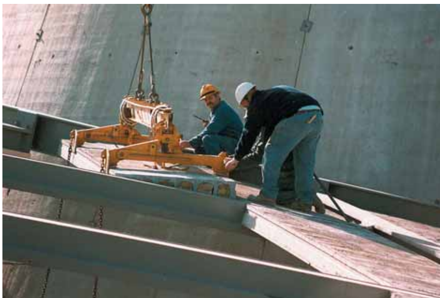
Foto 10.088: Montage kanaalplaat tussen balken
