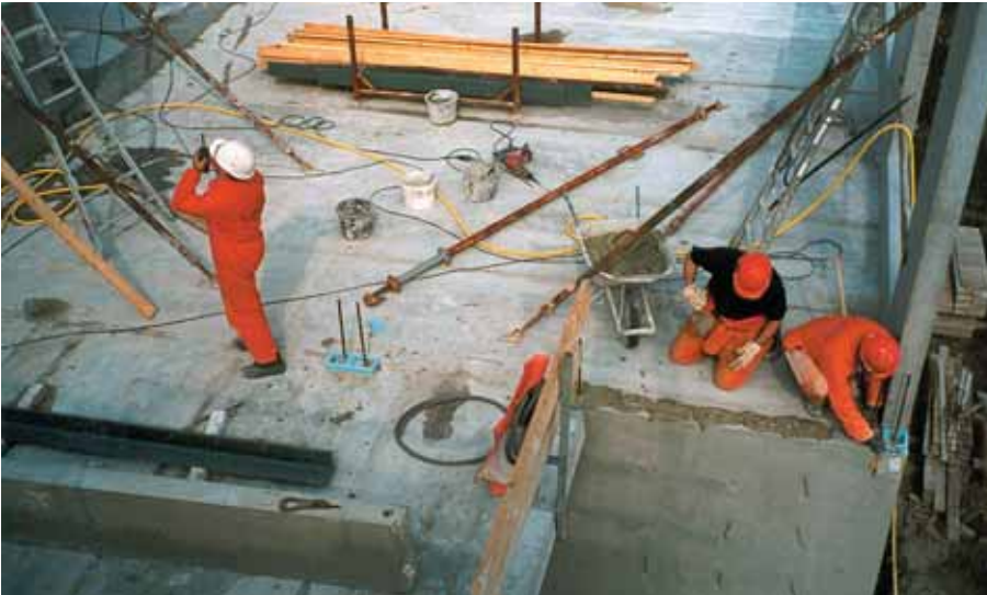
Foto 10.051: Communicatie met de kraandrijver. Materialen op de vloer, mallen voor voegen gesteld op de hoek en op de vloer. Aanbrengen van de specielaag voor de afsluiting van de voegruimte, bij hoek gebouw. Beveiliging op de plek waar niet gewerkt wordt wel aanwezig
