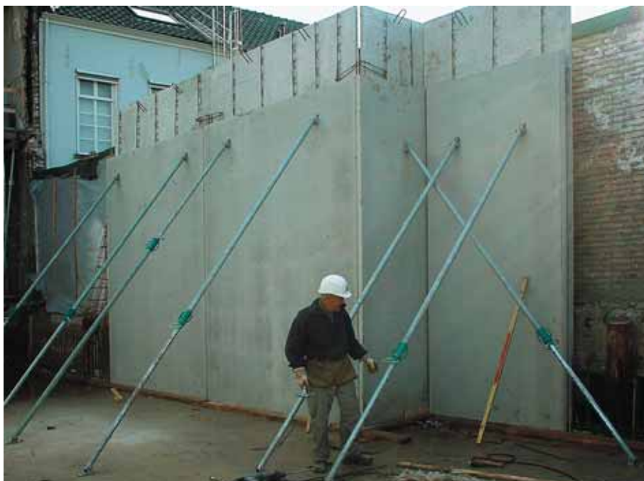
Foto 10.145: Holle wand verticaal toegepast. Lengte buitenschil aanzienlijk groter dan die van de binnenschil
