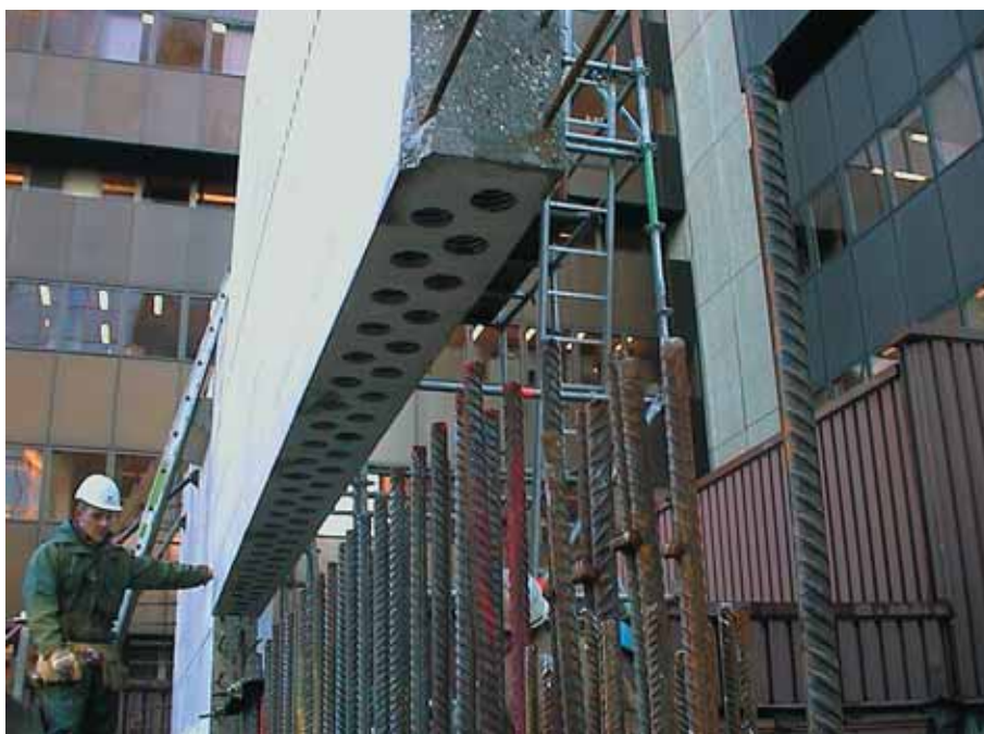
Foto 10.133: Aanzicht van stekken en omhullingbuizen, sparingen in het element. Altijd spannend of het wel past
