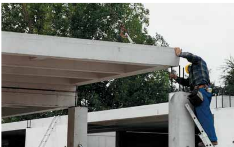
1 | Plaatsing van een vloerelement
