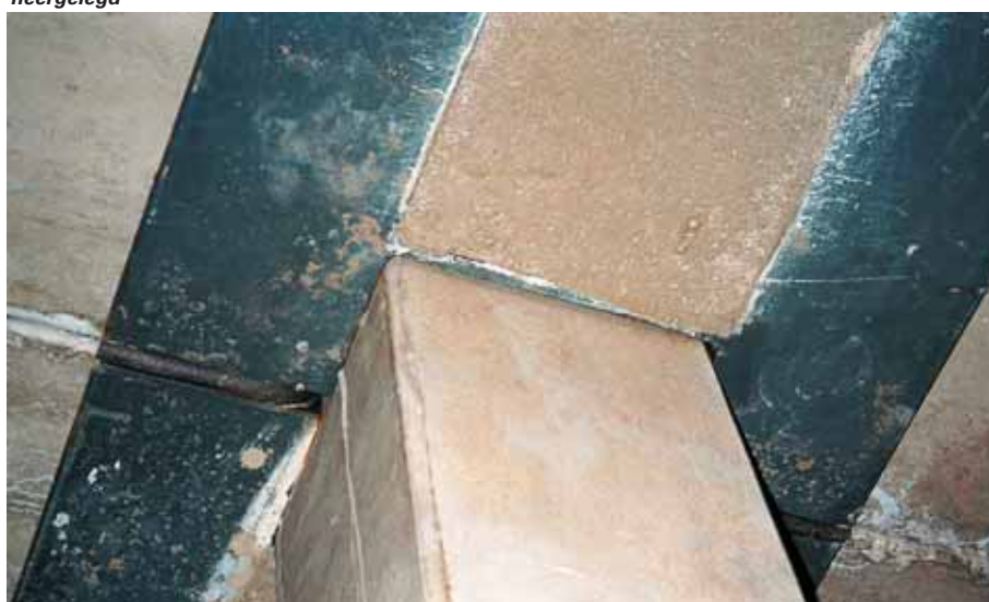
Foto 10.058: LEVO-balk, kolom, vloerontmoeting vanaf onderen gezien. Het gestorte beton tussen de hoekstalen is duidelijk te onderscheiden. Dat beton verstijft de balk en neemt deel aan de krachtopname
