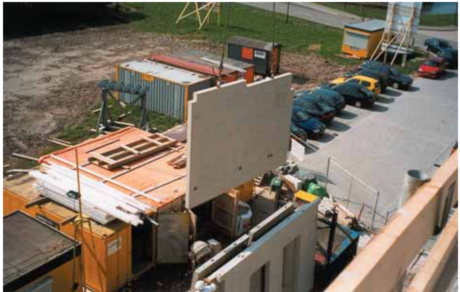
Foto 10.043: Wandelement in de kraan, op weg naar zijn positie
