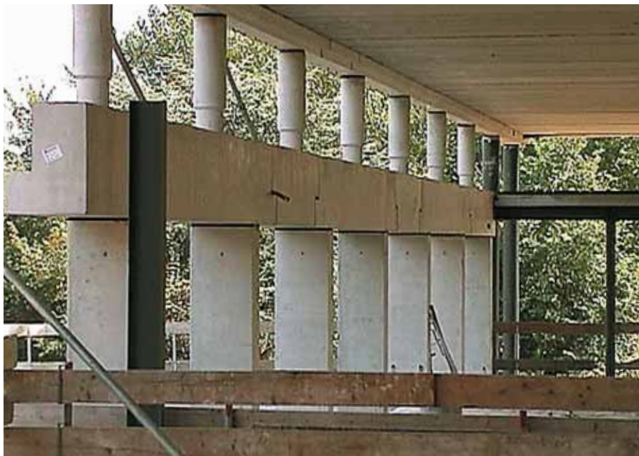
Foto 10.111: Nogmaals de kolom-balkconstructie. Alle uitgevoerd in ZVB
