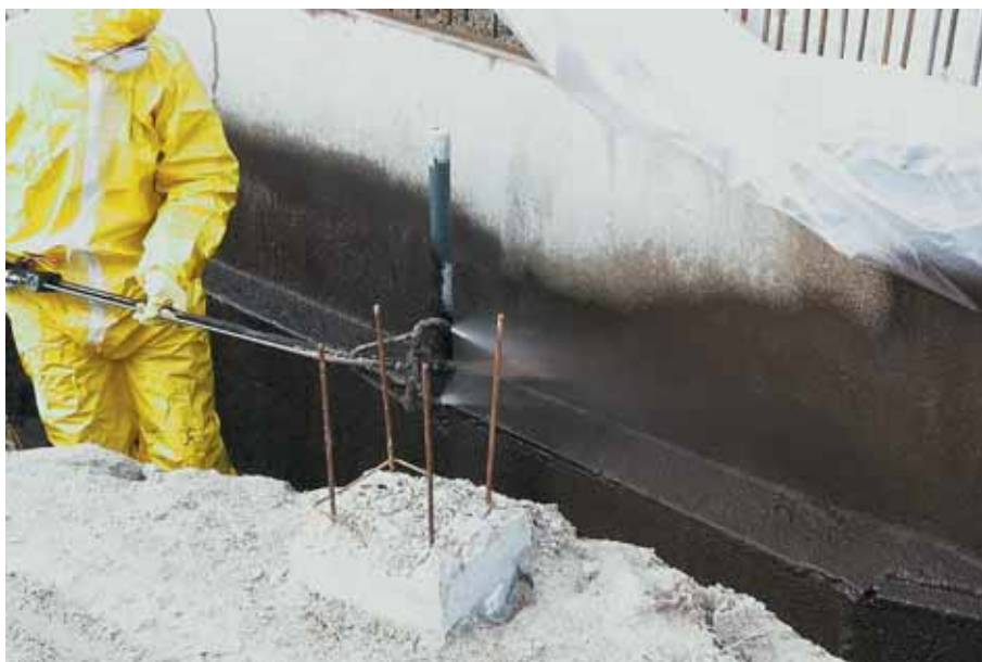
Foto 10.147: De kim spuiten met bitumen
