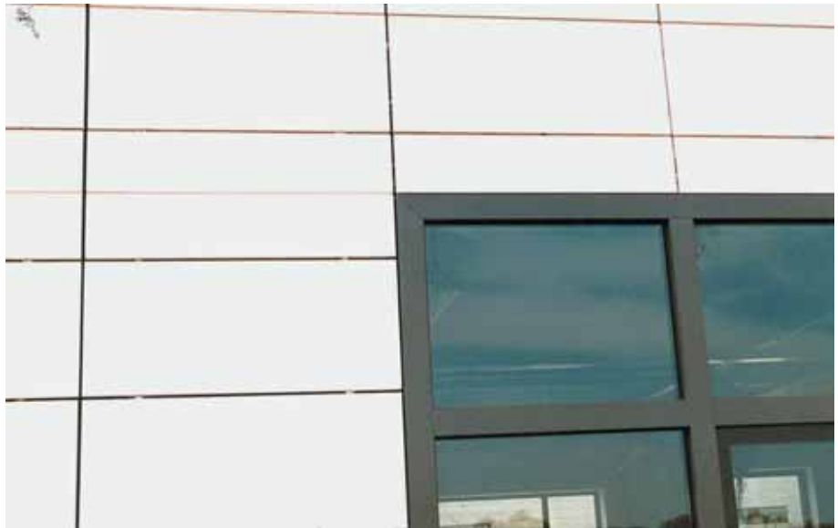
Foto 10.081: Een detail van de gevel
