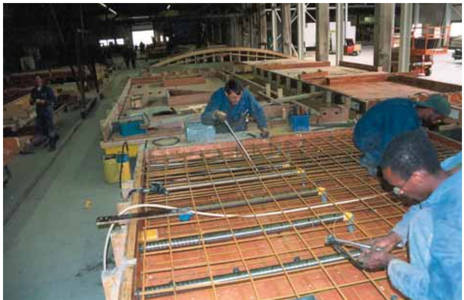
Foto 10.007: Inbouw van de voorzieningen en de wapening voor een niet zwaar belast wandelement
