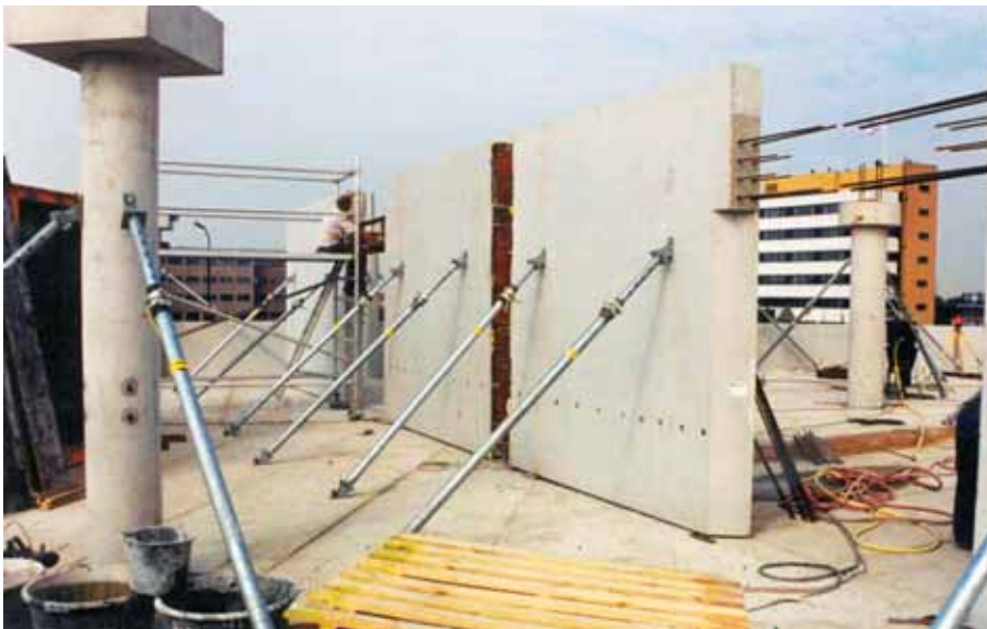
Foto 10.098: Details kernwanden, nog te storten natte verbindingen, schoorwerk kolommen
