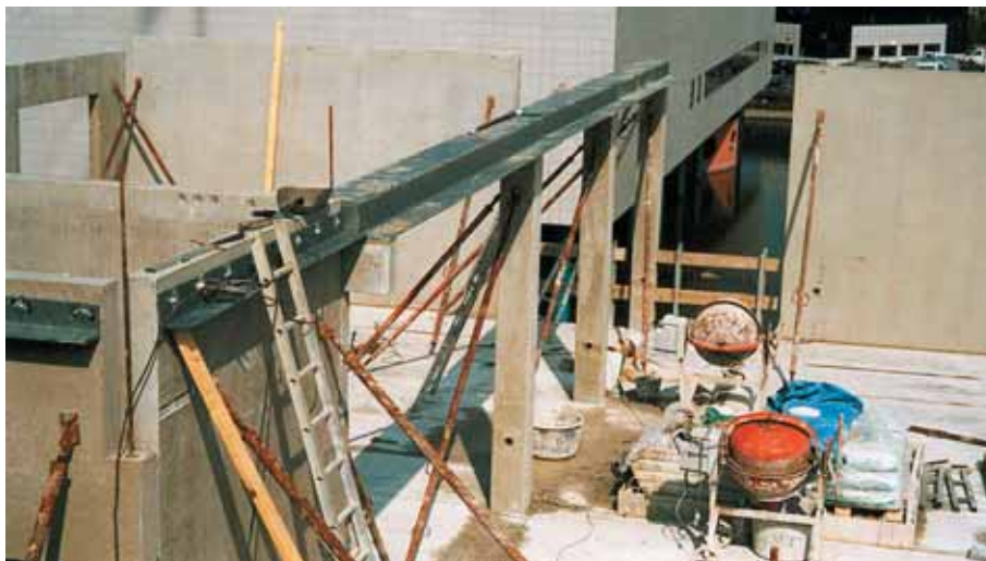
Foto 10.054: Hoekstaal aan de kern voor het ondersteunen van de kanaalplaten. Verder de LEVO-balk, samengesteld uit stalen handelsprofielen en inwendig gevuld met beton en langswapening
