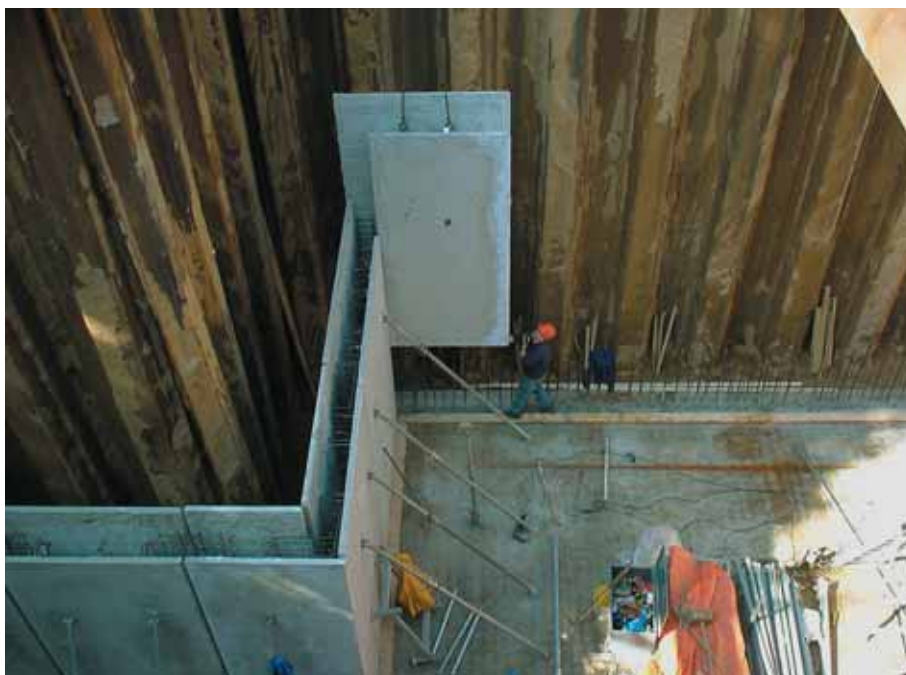
Foto 10.146: Toepassing in de bouwput, hoeken maken met de holle wand is geen probleem
