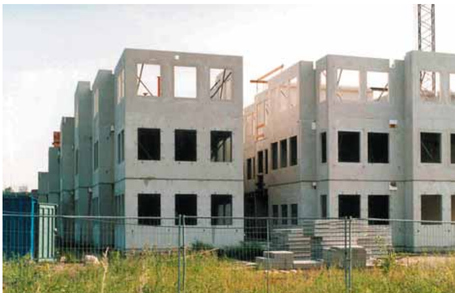
Foto 10.017: Zeer gevarieerde gebouwworm met strakke elementen. Toepassing van bekistingsplaatvloeren
