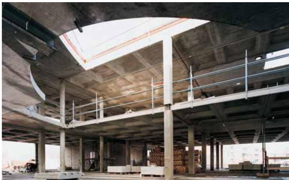
7 | Videconstructie in het Bestcon-30-systeem
