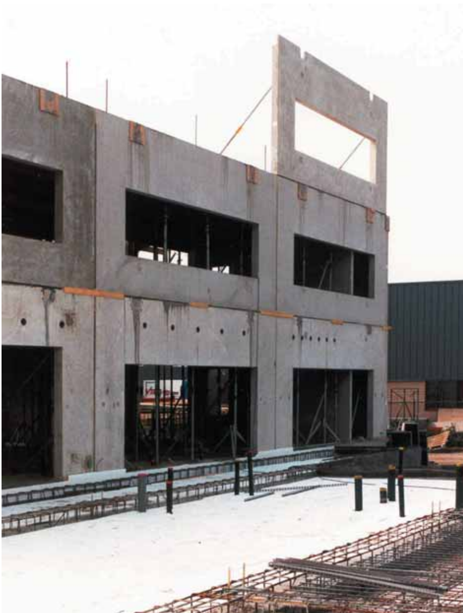
Foto 10.027: Gebouw in het montagestadium. Bekistingplaatvloeren, zie de stempels onder de vloer op de twee bouwlagen. Plaatselijk is een constructieve voeg tussen de wandelementen aangebracht
