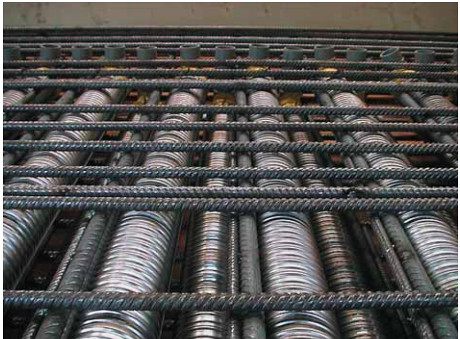
Foto 10.128: Dicht patroon van omhullingbuizen en gietopeningen
