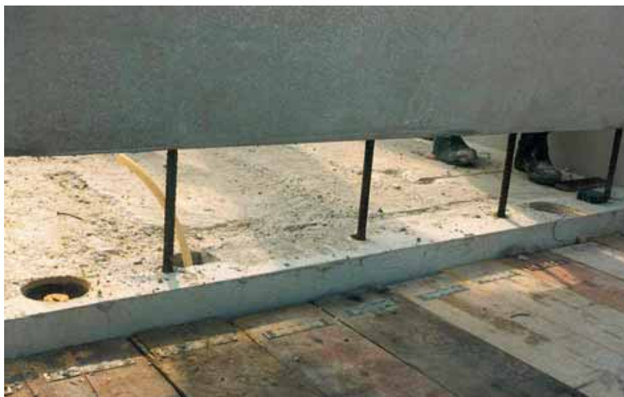
Foto 10.096: Meer in detail. De voeg wordt later aangebracht. Rechts is een stelblokje zichtbaar
