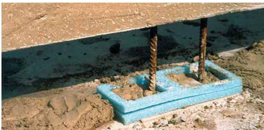
Foto 10.050: Kunststofmal boven op LEVO-blok aanwezig. Voegmortel nog maar deels in de voegruimte aangebracht. Naast de kunststofmal is voegmortel aanwezig voor het bouwkundig afsluiten van de voeg tussen vloer en wand. Is constructief niet noodzakelijk en zelfs minder gewenst: het krachtenverloop moet helder blijven. Het wandelement zakt over de stekken heen
