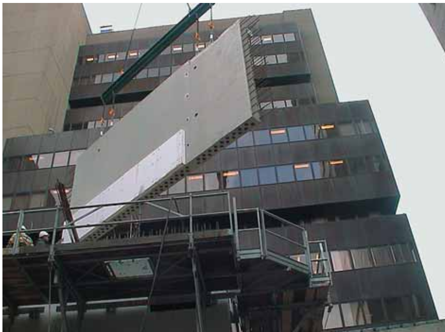
Foto 10.132: Het wandelement in de kraan
