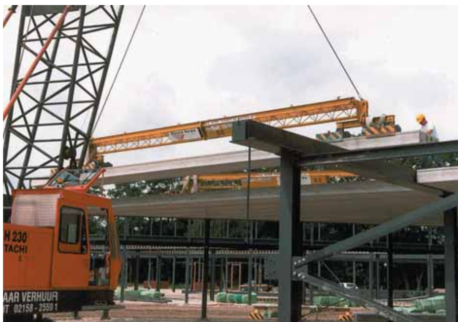
Foto 10.085: Kanaalplaten en hoedliggers
