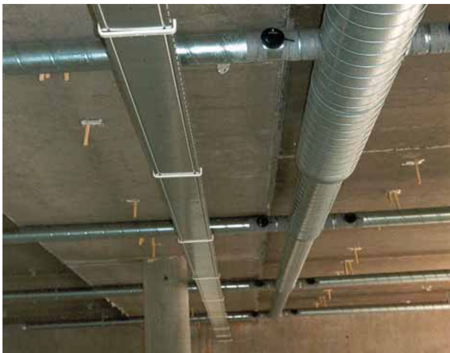
Foto 10.079: Bekistingplaatvloer uitgevoerd met een kolomstrook in het kantoorgebouw van 10.080
