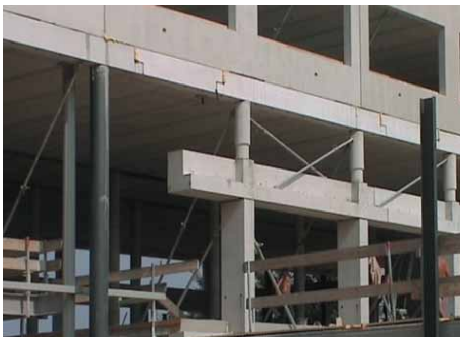
Foto 10.108: Meer in detail, met aanzicht van draagconstructie en overgangsbalk
