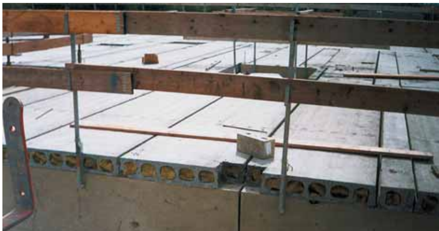
Foto 10.045: De vloer is aangebracht. De werkzaamheden om een nieuw blok te stellen kunnen gaan beginnen. Kanalen zijn voorzien van proppen minerale wol. Veiligheidshelmen zijn vereist
