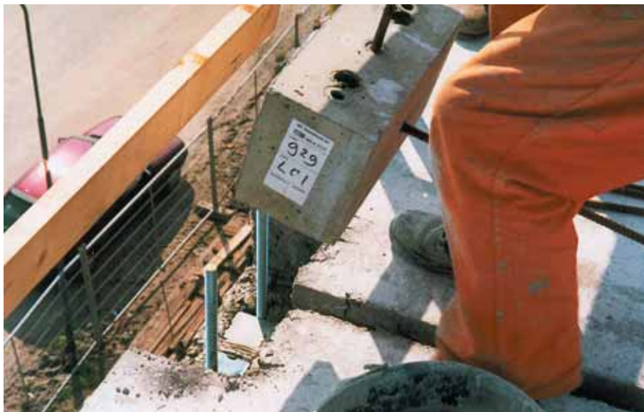
Foto 10.048: LEVO-blok wordt over de draadeinden geschoven. Voegmortel onderin aanwezig
