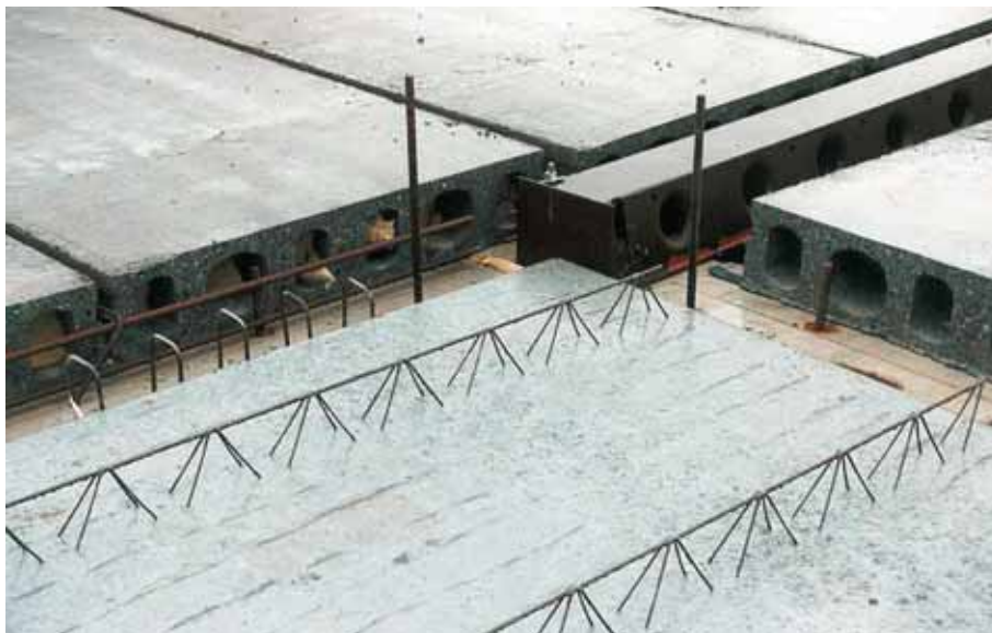
Foto 10.070: Toepassing van zowel kanaalplaat als bekistingplaat. Verder een DELTA-ligger
