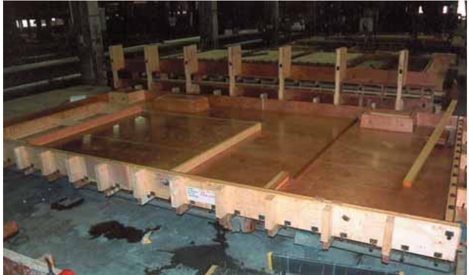
Foto 10.006: De mal is gereedgemaakt voor de inbouw van voorzieningen en wapening
