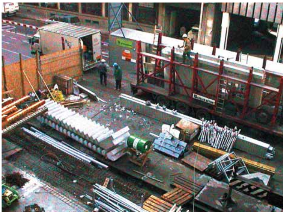
Foto 10.130: Aanvoer elementen met de wagen
