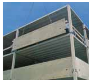
2 | Montage van een borstweringselement van het CD20-systeem
