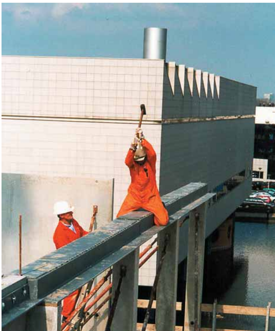
Foto 10.055: Een tikje is hier nodig om de balk tussen de andere te passen
