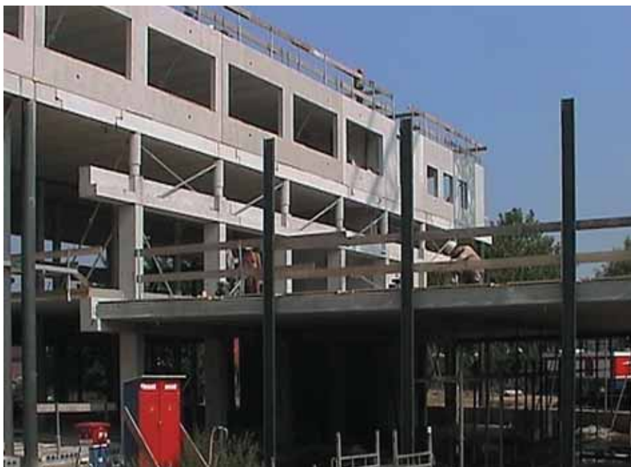
Foto 10.107: Aanzicht wandconstructie op onderbouw
