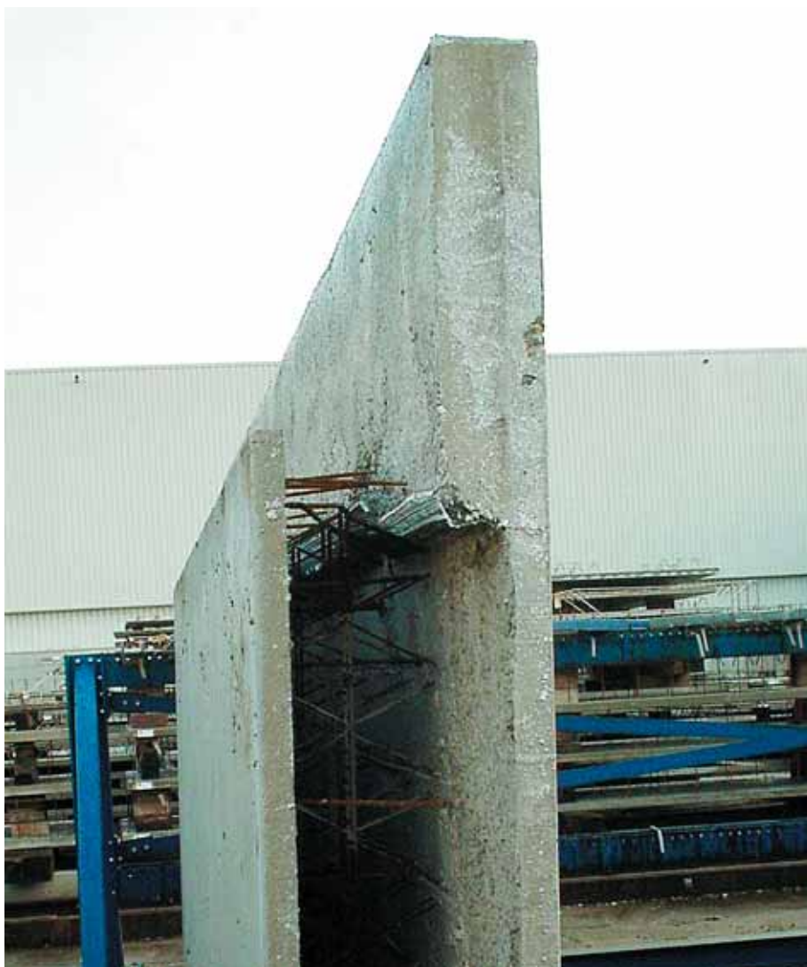
Foto 10.142: De holle wand uitgevoerd met een variatie in de schil
