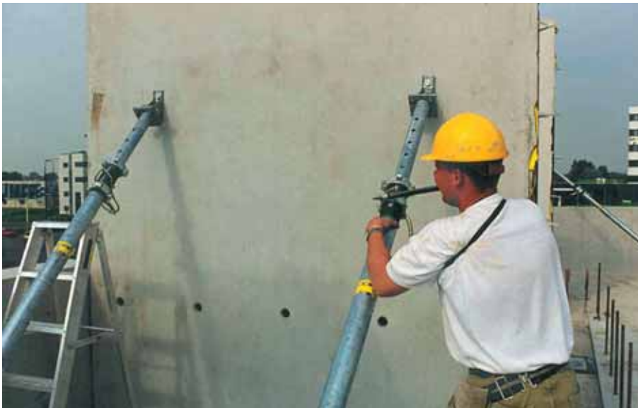
Foto 10.097: Wand wordt geschoord en verticaal gezet
