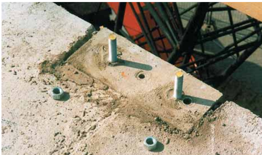
Foto 10.049: LEVO-blok opgenomen in de vloer, doorlopend draadeind voor opgaande stek. De voorzieningen voor de volgende voeg kunnen worden aangebracht
