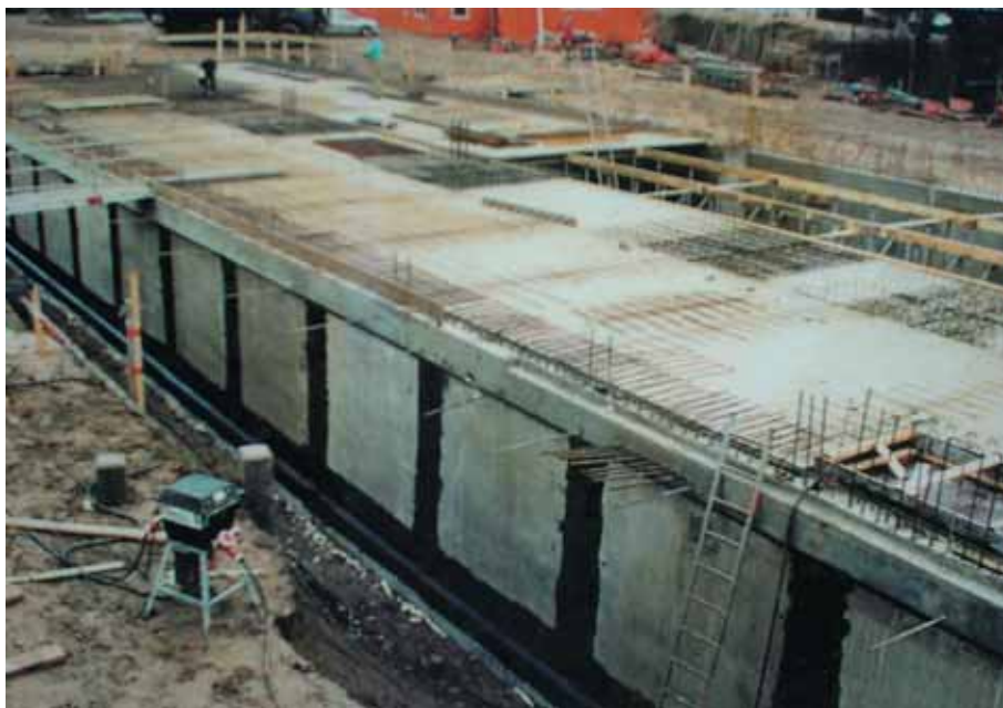
Foto 10.148: Kelderwanden bij kim en naden wand afgeplakt met bitumen
