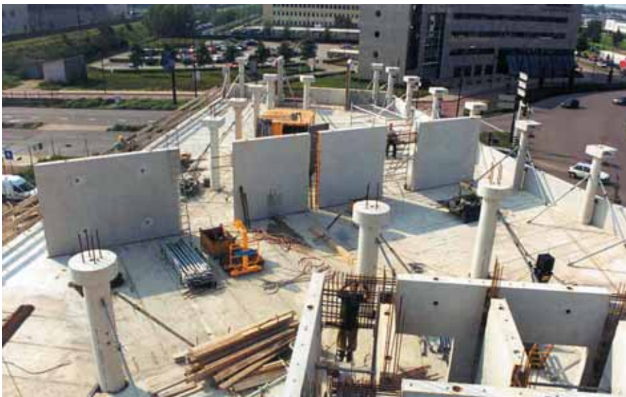
Foto 10.094: Wanden gesteld, natte verbindingen nog uit te voeren
