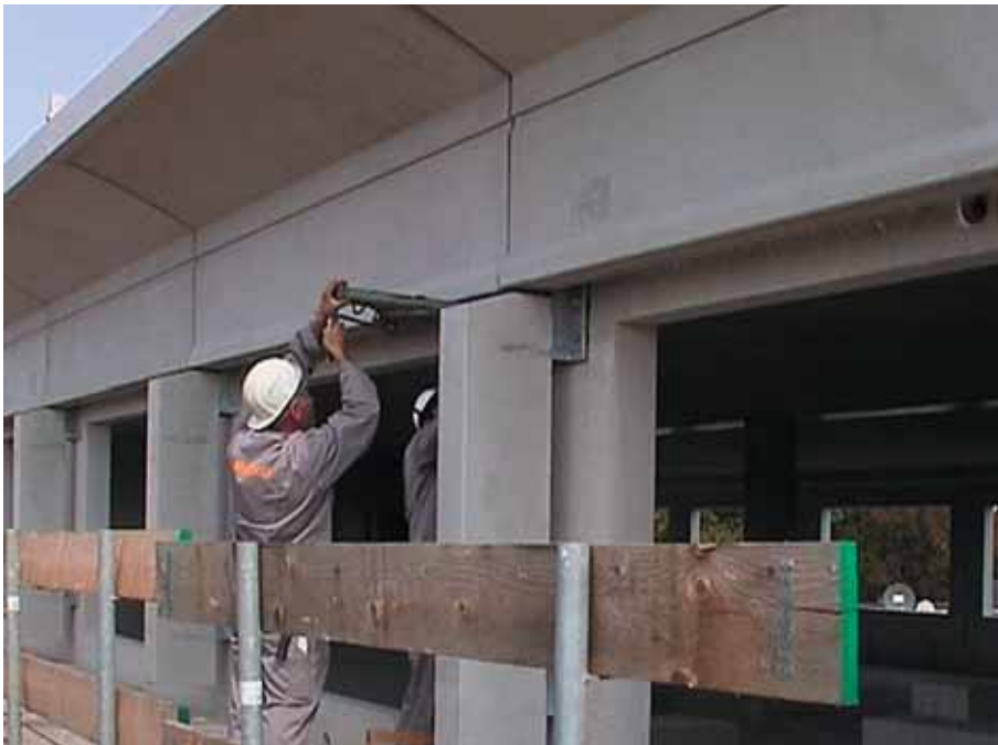
Foto 10.115: De gevelstructuur, geplaatst voor de dragende wanden. De dakrand zoals hier uitgevoerd komt nog zelden voor
