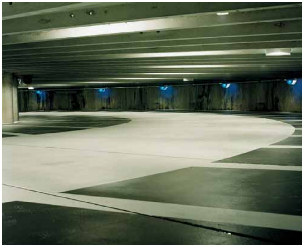
Kolomvrije rij-/parkeervloer met door middel van zwarte vlakken aangegeven parkeervakken
