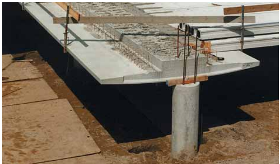
Foto 11.027: Balk met verzwaarde stroken om de overspanning van de kanaalplaten te reduceren
