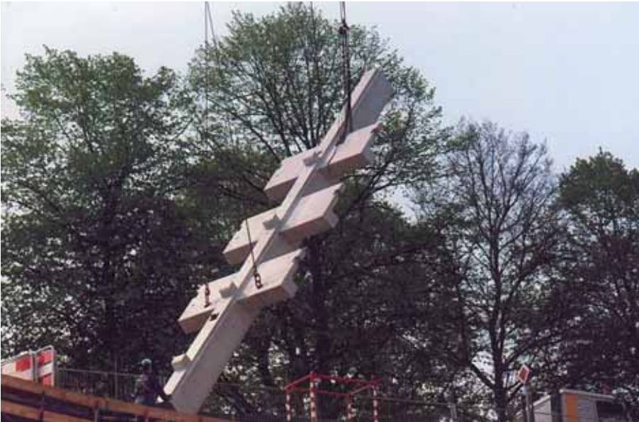
Foto 11.024: Geïntegreerde kolom/balk
