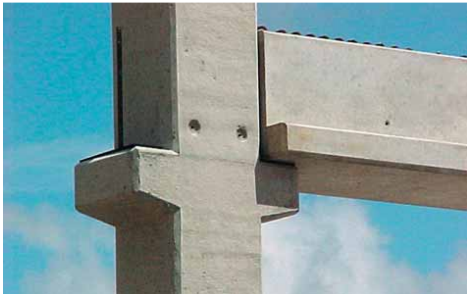
Foto 11.010: Aansluitdetail sponningbalk-kolom
