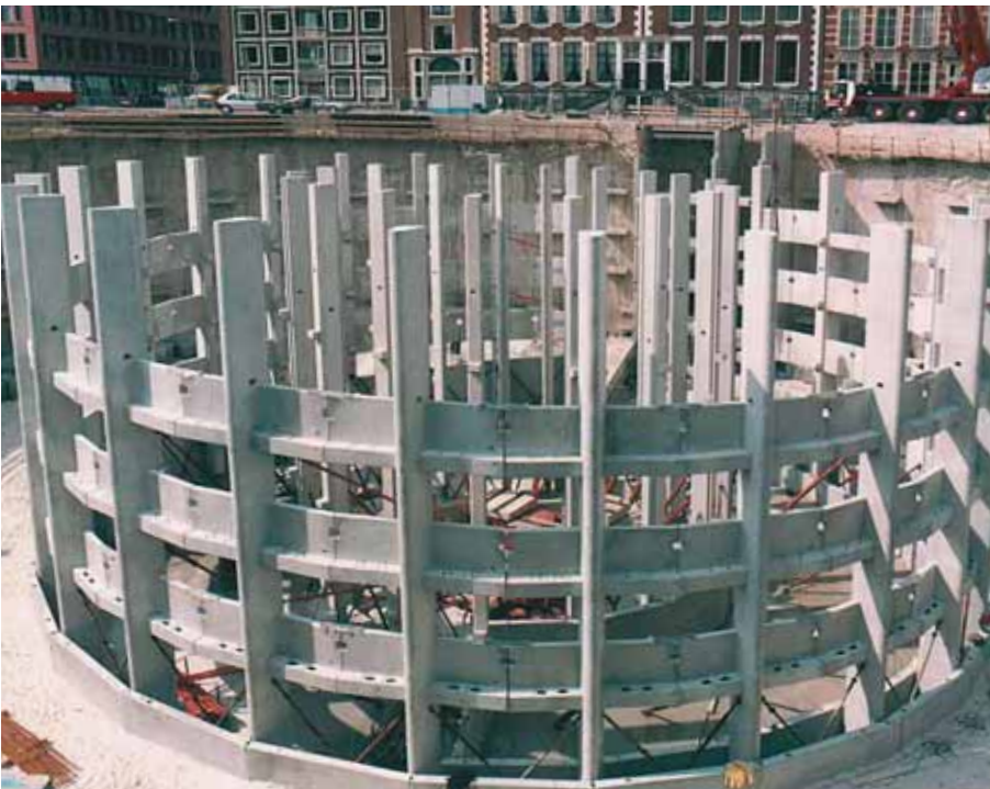
Foto 11.022: Montage 15 m lange kolommen
