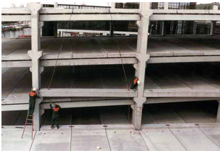
Foto 11.003: Montage balk hellingbaangarage
