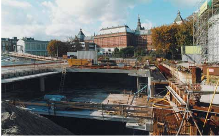
Foto 11.025: Tweelaagse, ondergrondse parkeergarage
