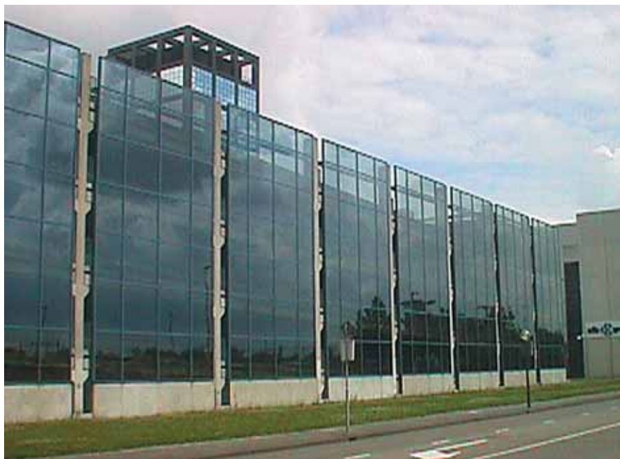
Foto 11.011: Vliesgevel parkeergarage Leeuwarden
