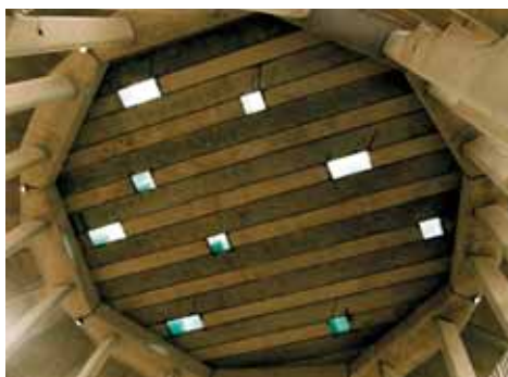
(boven) Ossenmarkt met massieve 'glasdruppels' en op de achtergrond de hoofd- in- en uitgang voor voetgangers (links) Onderzijde garage-dak met daarin opgenomen negen 'glasdruppels' annex daklichten (onder) De in de kade van Het Diep geïntegreerde hoofd- in- en uitgang voor voetgangers
