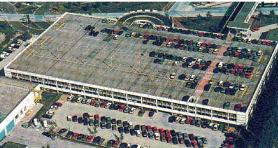
Foto 11.001: Vlakke-vloergarage met uitwendige hellingbaan
