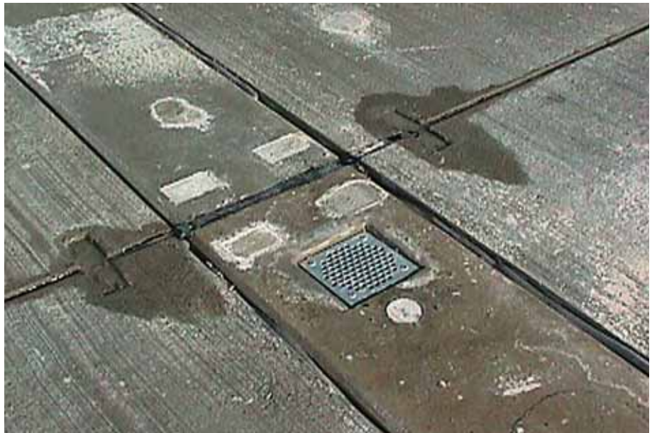
Foto 11.015: Trekbandkoppeling; waterafvoer door middenbalk
