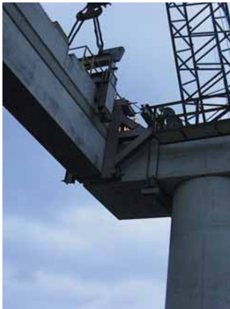
Montage ligger op kolomtafel
