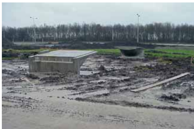
Landhoofden wachten op overbrugging
