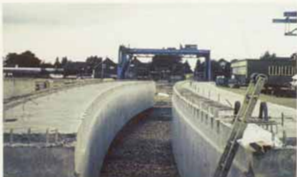
Bild 12. Transportfertige gebogene Träger auf dem Lagerplatz Fig. 12. Curved beams on the stockyard, ready for transportation Fig. 12. Poutres courbes prêtes au transport sur aire de stockage
