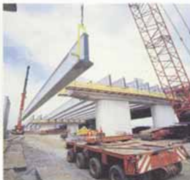
Bild 5. Veränderungen von Länge und Breite bei Fertigteilbrücken in den Niederlanden. Van-Brieneoord-Brücke in Rotterdam (a); Fertigteilträger von über 50 Meter Länge (b); Spannanlage mit einer Kapazität von mehr als 1600 Tonnen (c)
