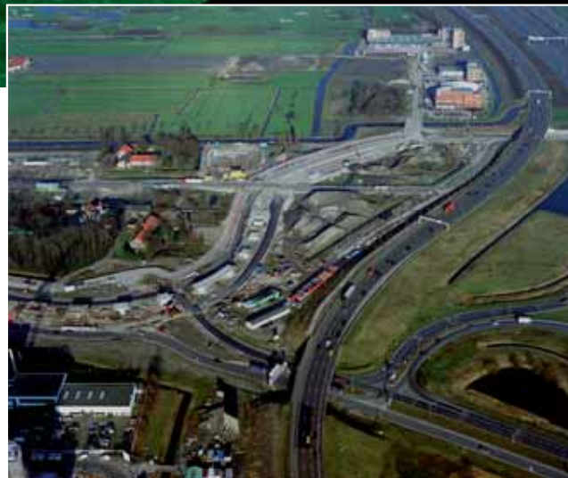
1 | Situatie fly-over; rechts is de aanzet van verkeersplein Ypenburg te zien
