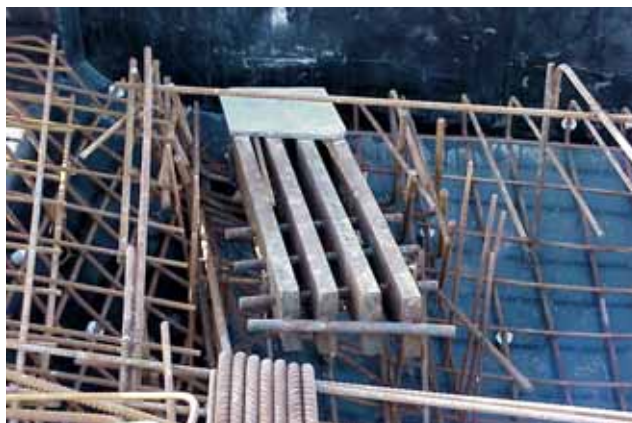
Staalconstructie in het landhoofd
