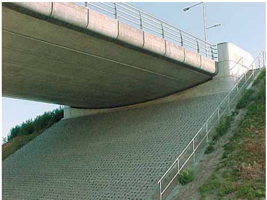
Foto 13.005: Landhoofd met oplegging vleugelbrug
