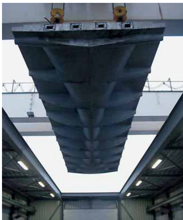
Prefab element wordt naar tasveld getransporteerd
