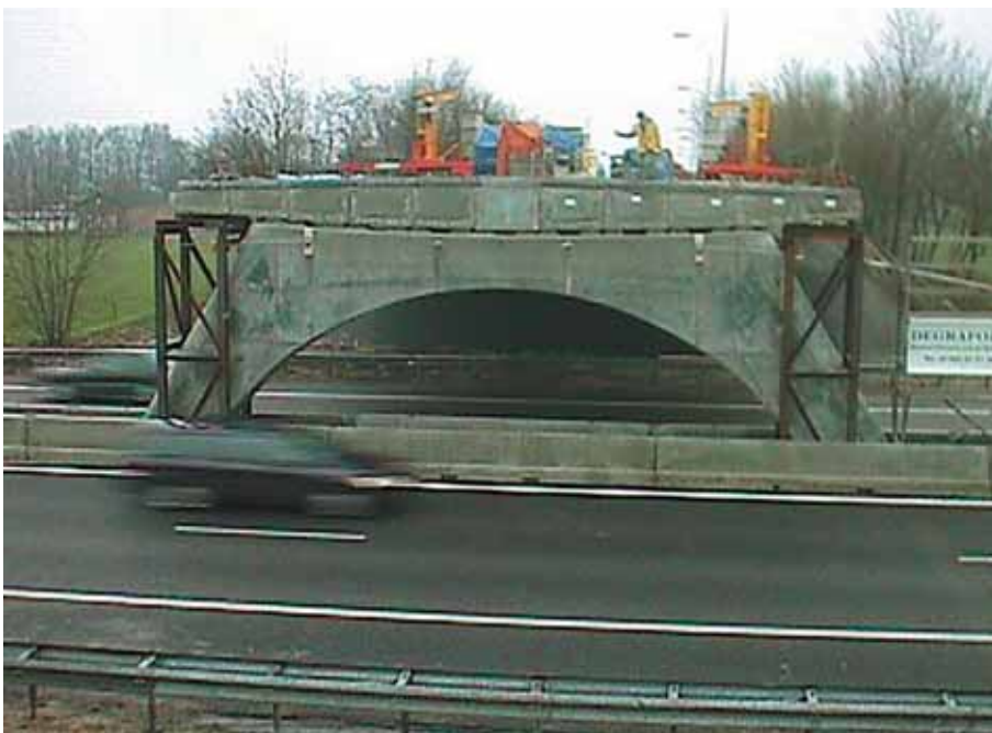
Foto 13.003: Montage vleugelbrug met tijdelijke ondersteuning randligger
