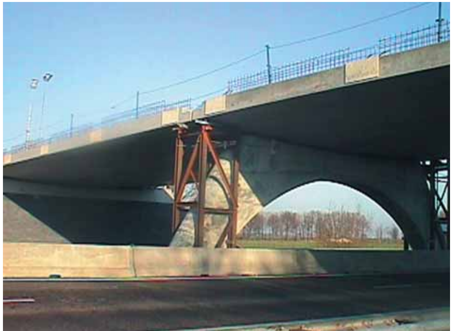
Foto 13.004: Vleugelbrug met tijdelijke ondersteuning randligger
