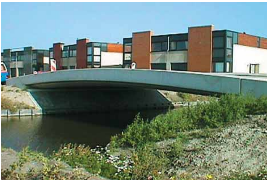
Foto 13.006: Voorgespannen boogbrug uit U-liggers met in het werk gestorte druklaag
