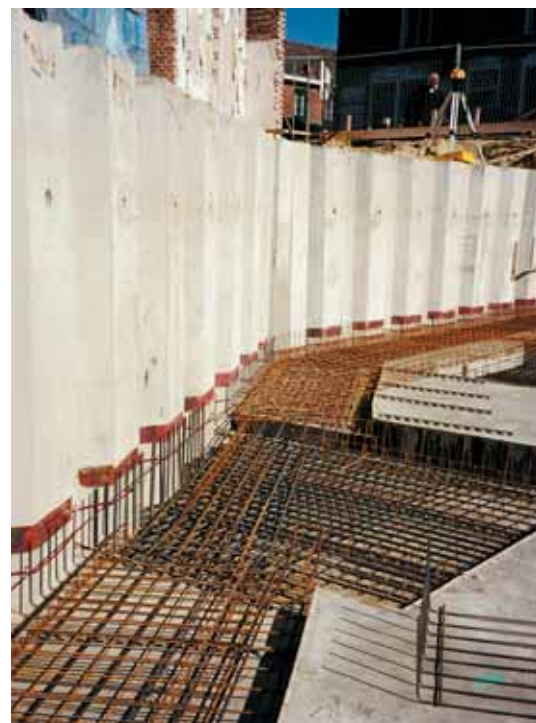
10 | Verdikte stroken langs de vloerand zorgen voor belastingsspreiding en opname van momenten en ponskrachten
