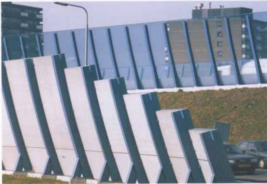
Geluidschermen Arnhem-Eindhoven Bron: Geelen Beton Wierzon BV
