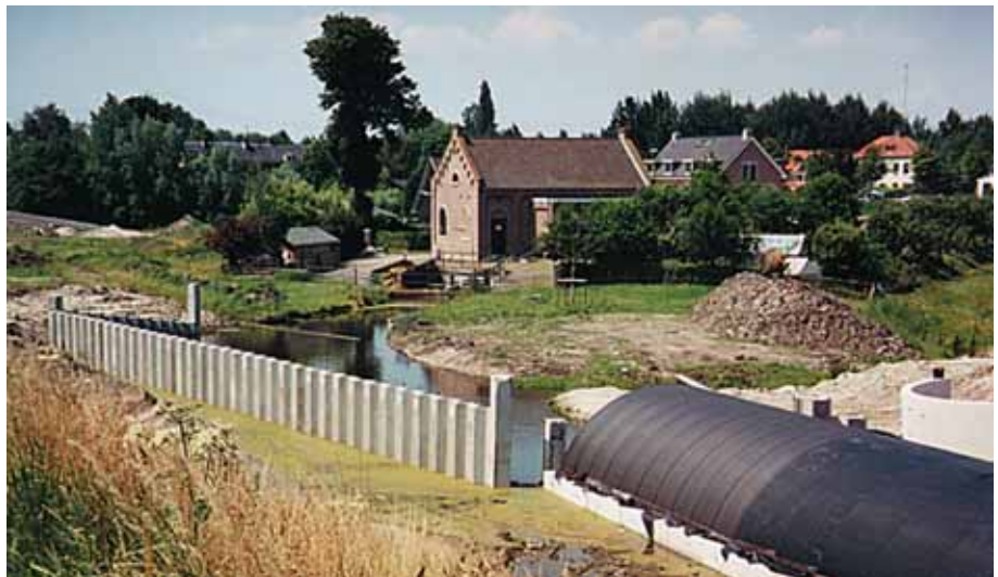
Foto 14.014: Grondkering, duiker Smalweesp te Weesp. Projectlengte 240 m. Damwand SPW 450 lang 9,0 tot 11,0 m
