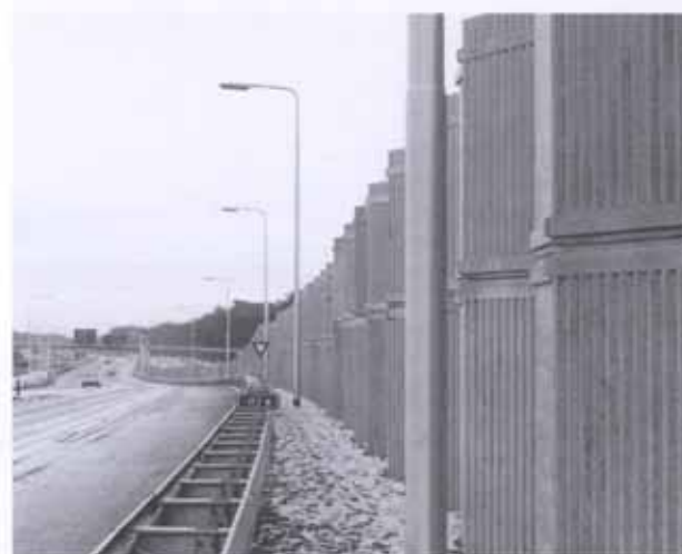
Geluidscherm Leusden Bron: Haco Beton BV
