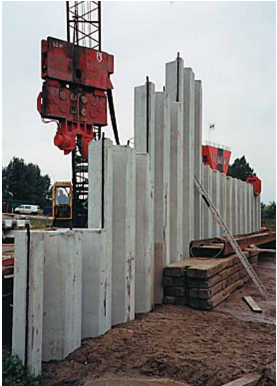
Foto 14.008: Damwandelementen worden met een trilblok op diepte gebracht. Zoals hier is te zien, in fasen op diepte, zoals af te lezen aan de verschillende hoogten van de damwandelementen boven het maaiveld
