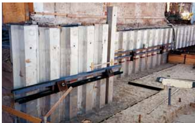
9 | Een stalen constructie zorgt voor de koppeling aan de keldervloer
