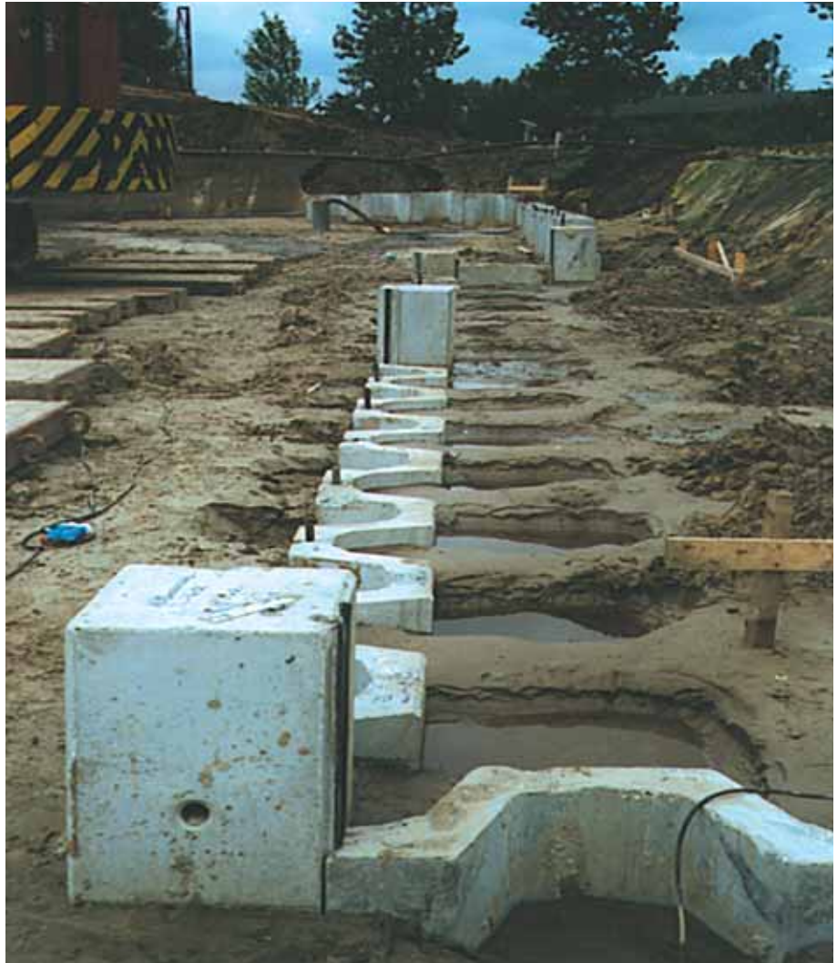
Foto 14.017: Uitvoering van een hoek in de wand, waarbij in hetzelfde project de andere wand in cirkelboog is geplaatst
