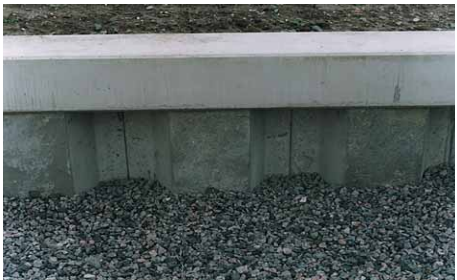
Foto 14.018: Sloof gestort op damwand langs de spoorbaan. Daarmee is de onderlinge horizontale verplaatsing van de bovenzijde van de wand geminimaliseerd en is een visueel aanvaardbare beëindiging van de wand ontstaan
