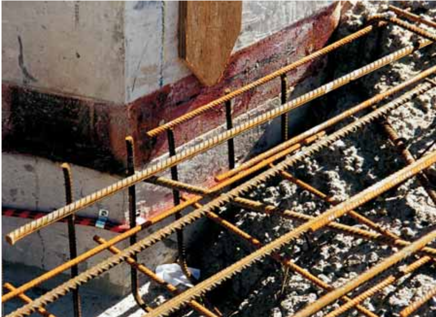
11 | Door persmortel in een persslang te pompen kan waterdichtheid ook bij een stijgende water-spiegel worden gegarandeerd
