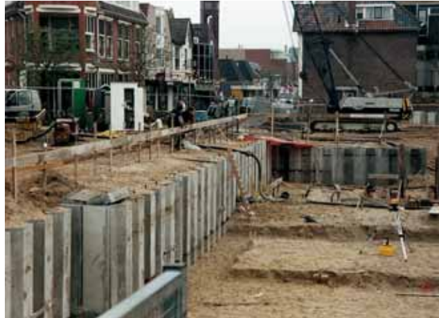
6 | Situatie rondom de bouwplaats ten tijde van het inbrengen van de Spanwand
