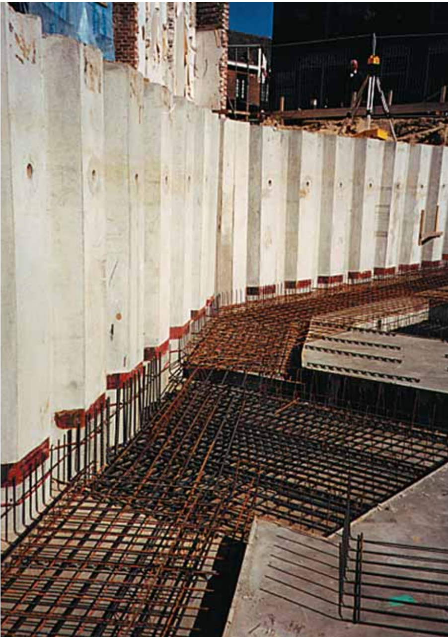
Foto 14.007: Damwand uitgevoerd met voorzieningen om de constructieve verbinding tussen de damwand en de keldervloer te realiseren
