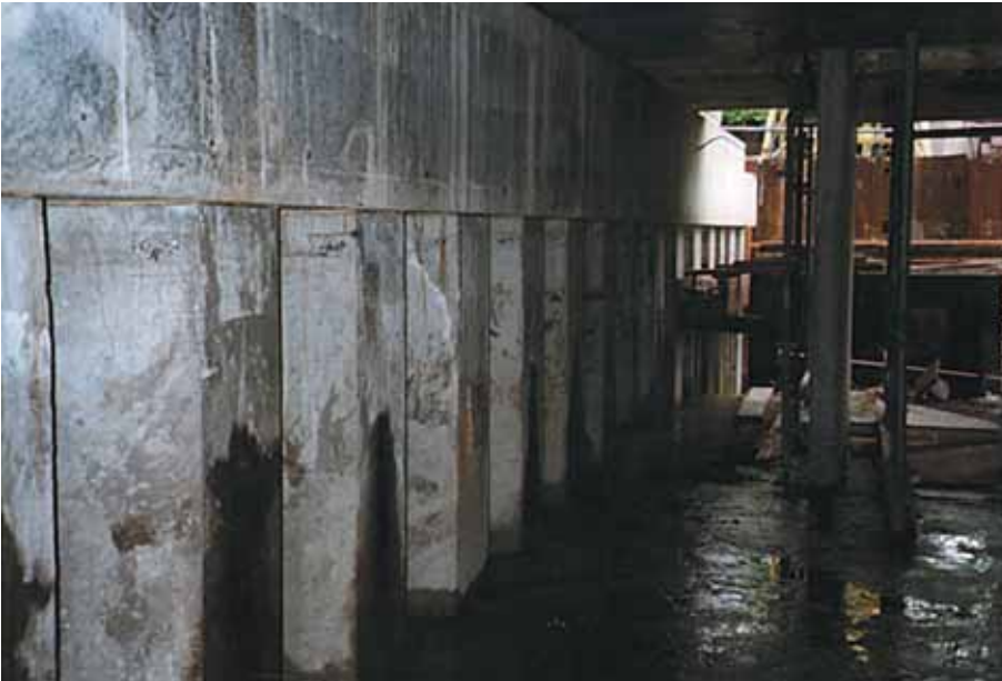
Foto 14.015: Dragende en kerende kelderwanden in parkeergarages, kantoren en wooncomplexen
