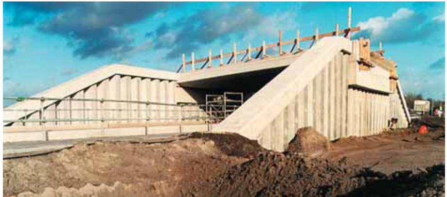
Foto 14.013: Kunstwerk 6A, Zuidtangent, busbaan te Vijfhuizen. Damwand SPW 600, lang 18,0 m
