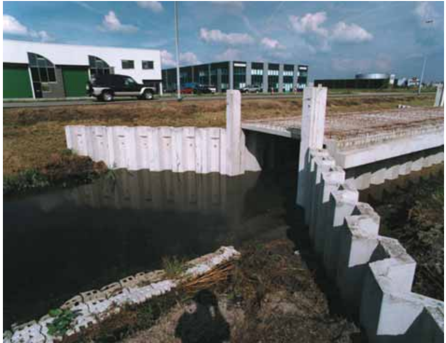
Foto 14.012: Landhoofden voor viaducten en oplegbalken of pijlers
