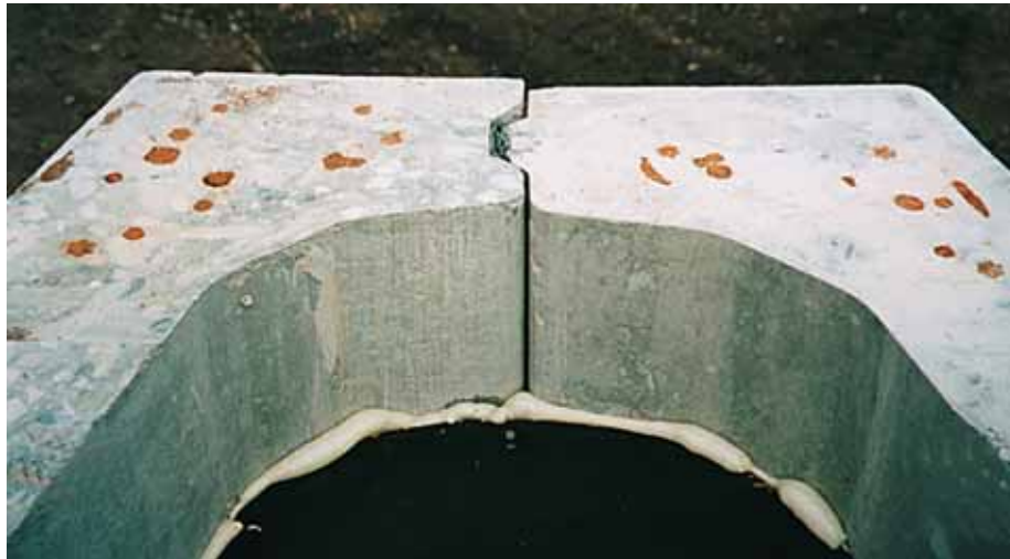
Foto 14.006: De aansluiting van twee damwandelementen met een rubber voegprofiel ingestort in de rechter damwandplank dat zich voegt naar de ruimte in de sponning van de linker damwandplank. Hiermee zijn grond- en waterdichte aansluitingen te maken
