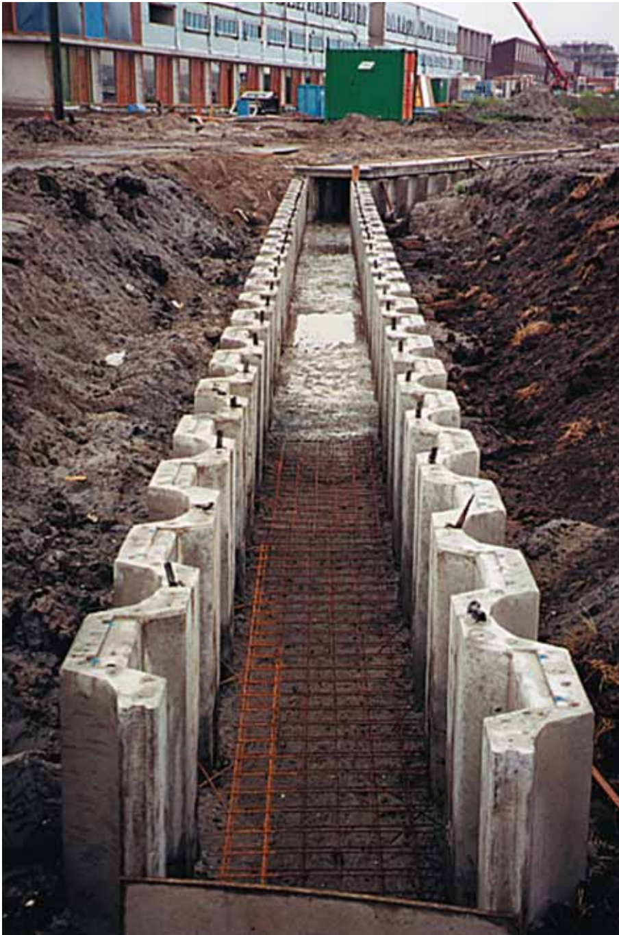
Foto 14.011: Leidingkoker in uitvoering. De leiding mag niet verzakken en zeker niet ongelijk. Verkeer moet er later overheen kunnen gaan
