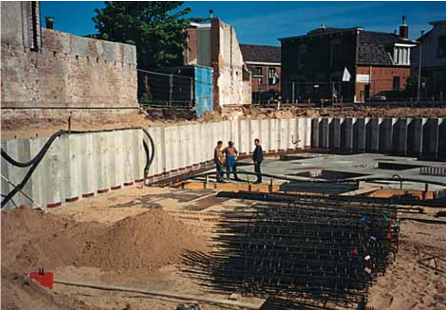
Foto 14.016: Uitvoering van een damwand als kelderwand, waarop de vloeren aansluiten
