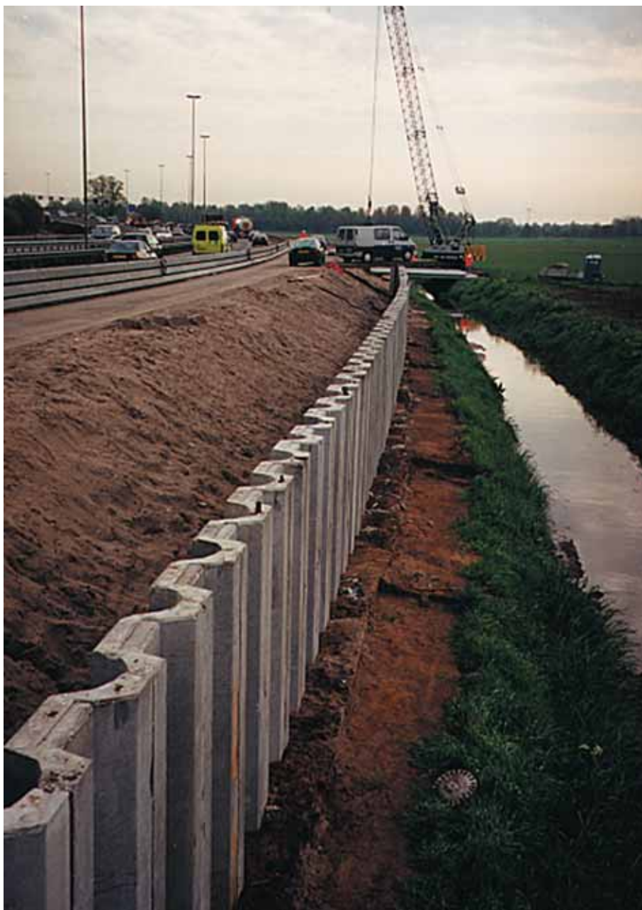
Foto 14.009: Damwand geheid voor een wegverbreding langs de bestaande en in gebruik zijnde snelweg. De damwandelementen zijn op hoogte afgeheid.
