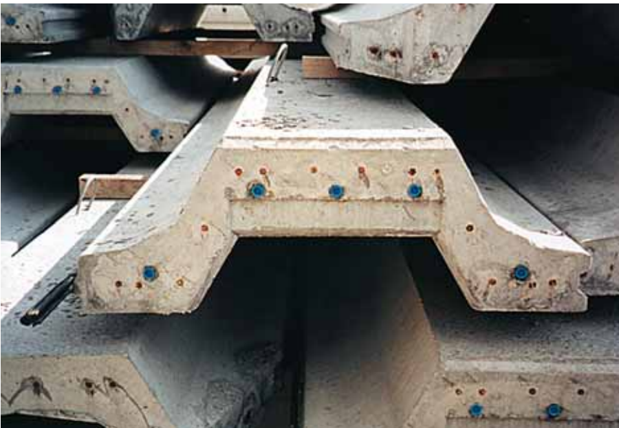
Foto 14.005: Spanwanden getast. De verlopende doorsnede is duidelijk waarneembaar alsmede de verzwarening van de kop en de doppen op de pijpen voor het fluideren
