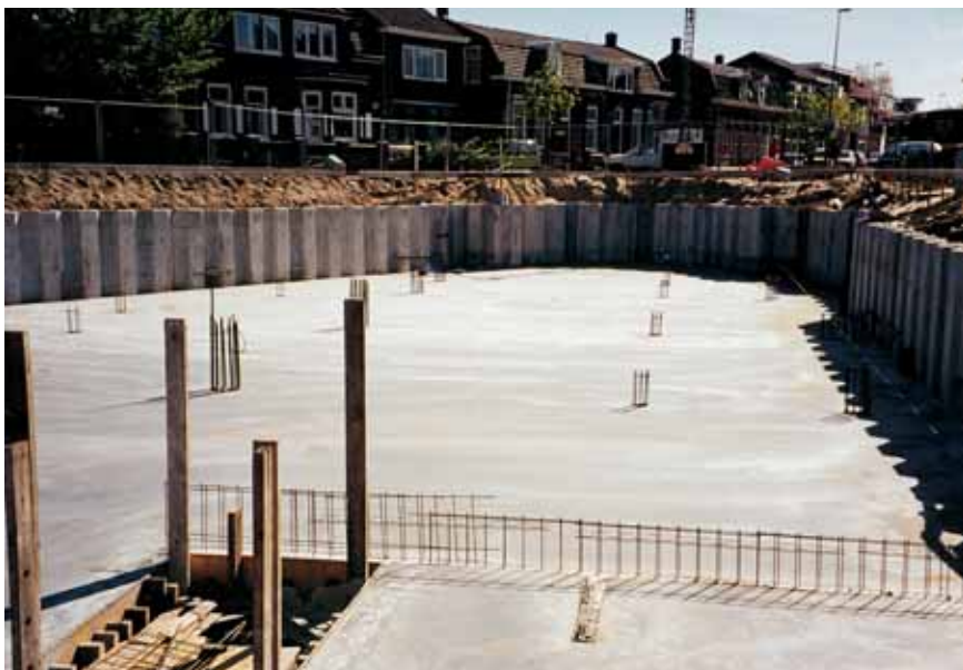
1 | Een betonnen Spanwand fungeert als kelderwand van een ondergrondse parkeergarage in Noordwijk
