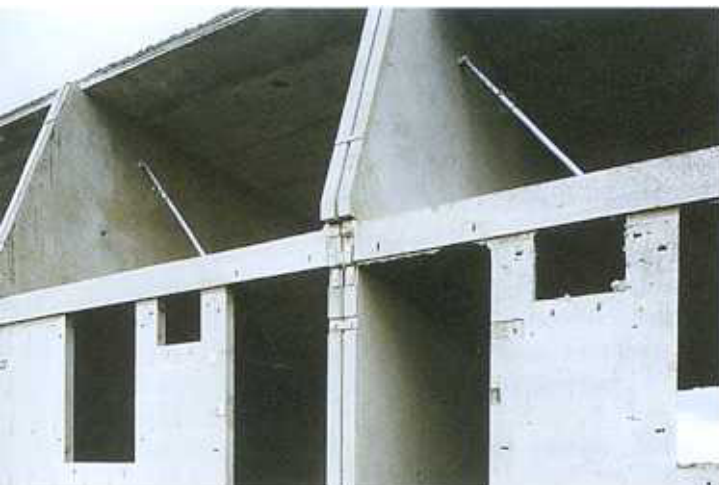
Betonnen casco met ankerloze dubbele bouwmuur
