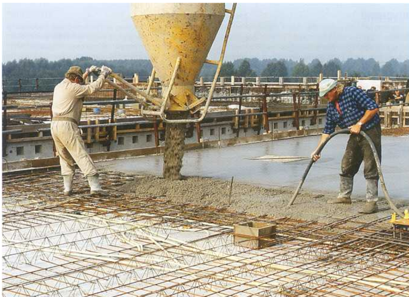
Aanbrengen druklaag
