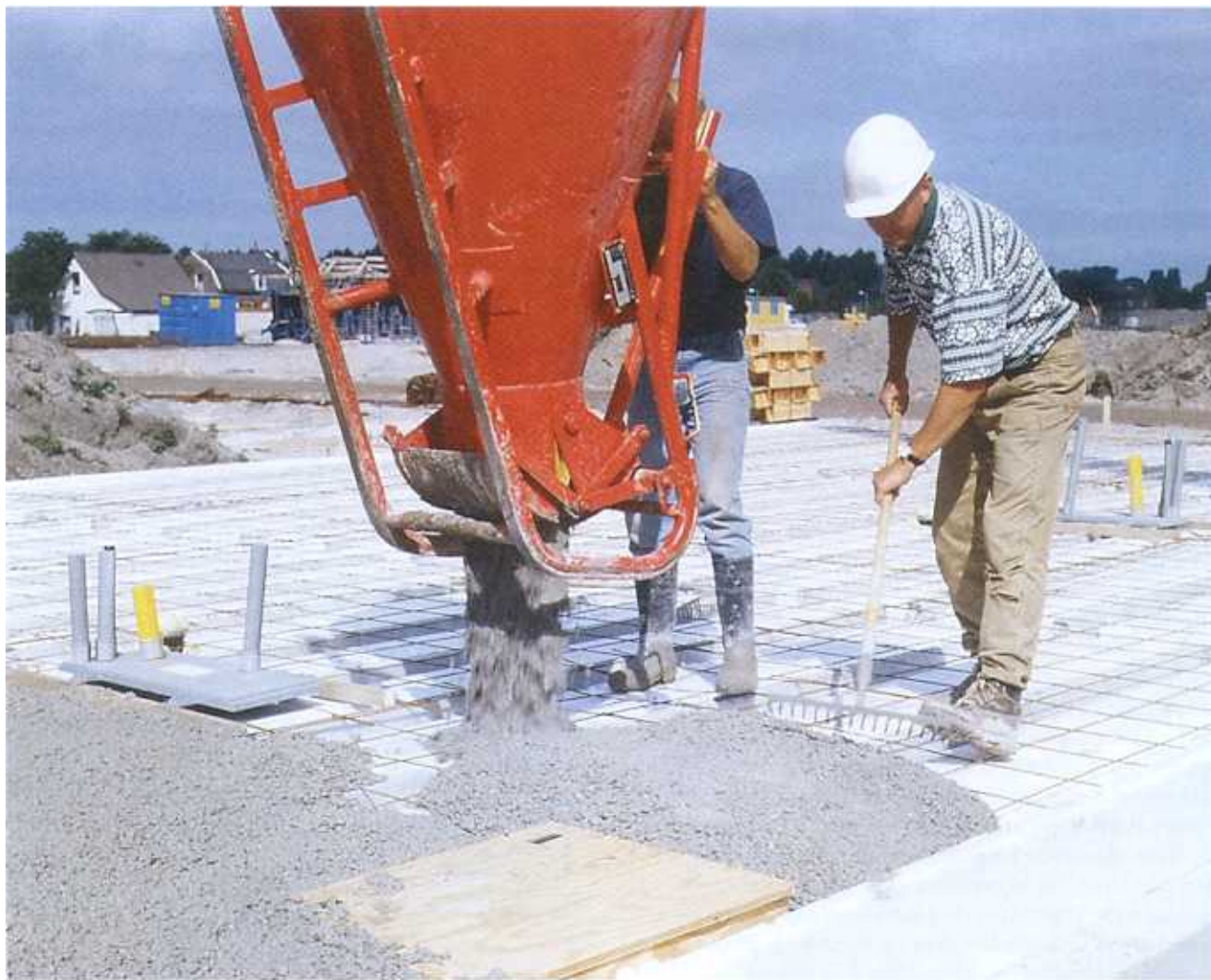
Aanbrengen druklaag
