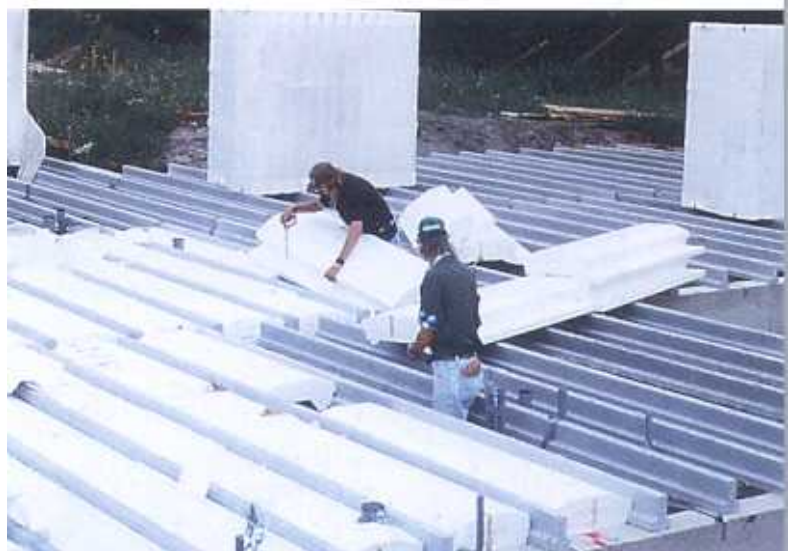
Aanbrengen vulelementen
