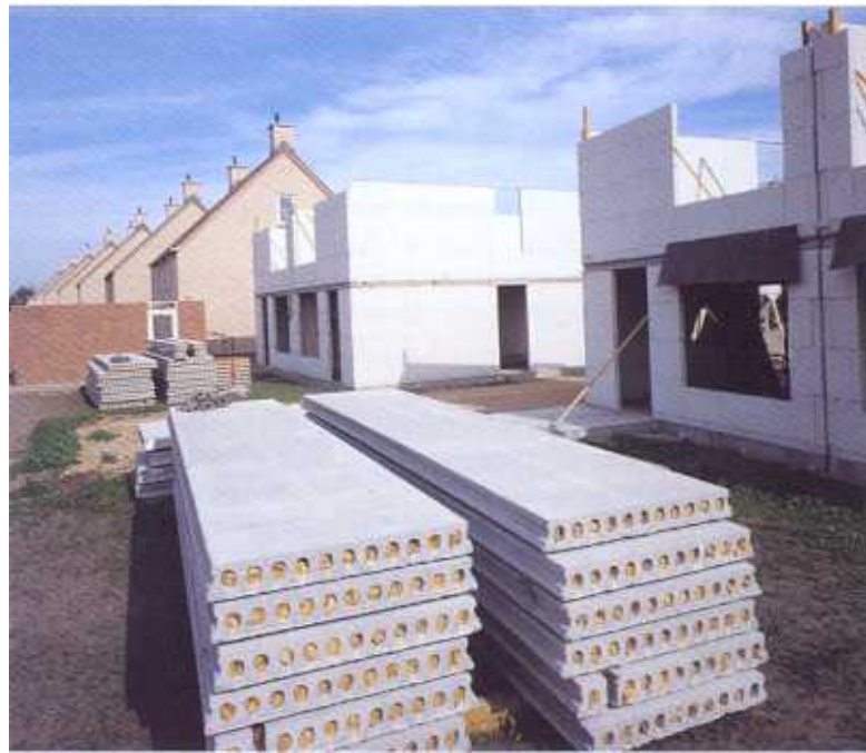
Tussenopslag kanaalplaatvloeren op de bouwplaats
