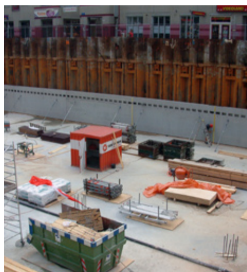
Maatwerk op de bouwplaats.
