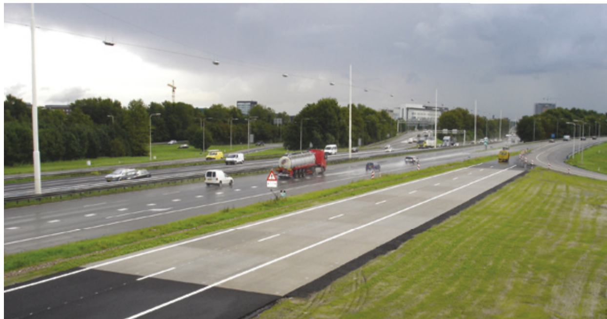
Pilot met de prefab wegdekplaat op knooppunt Oudenrijn bij Utrecht.
