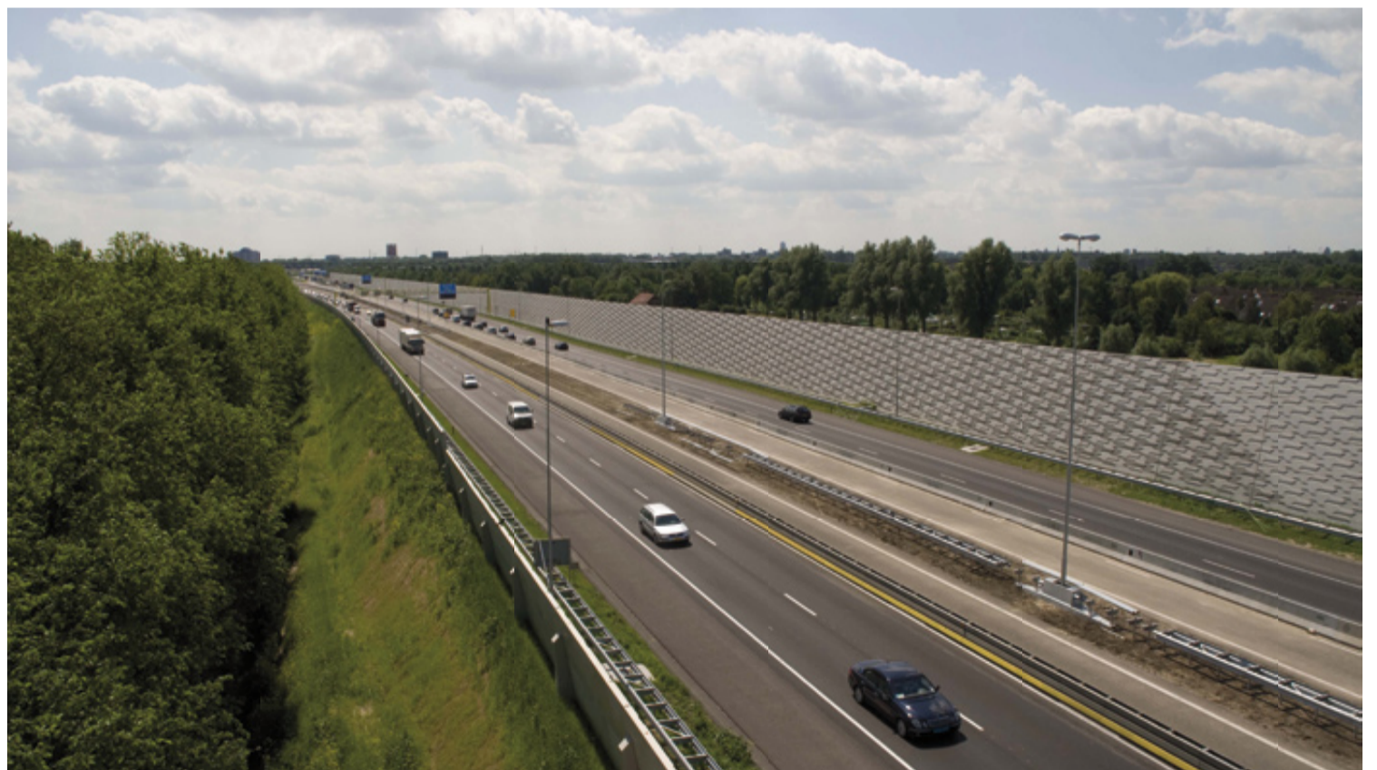
Snelle realisatie dankzij een perfect passende puzzel van kolommen, plinten en panelen.
