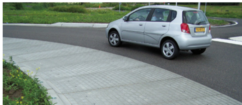
Prefab rammelstroken op een rotonde.
