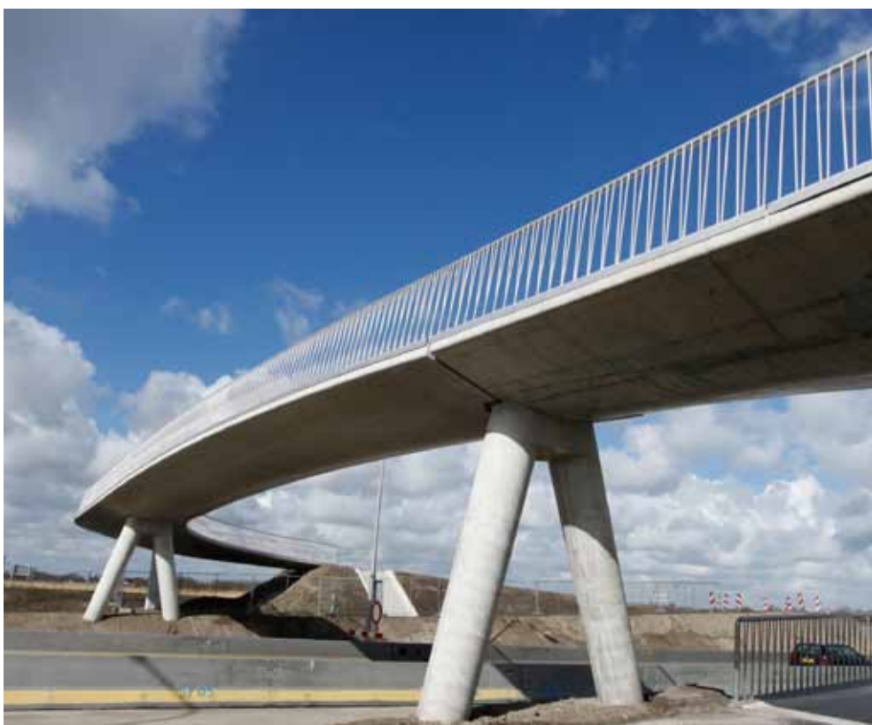
Moeiteloze overspanning in slanke prefab betonconstructie.
