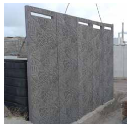
Fraaie uitwerking kerende grondconstructie in prefab sierbeton.
