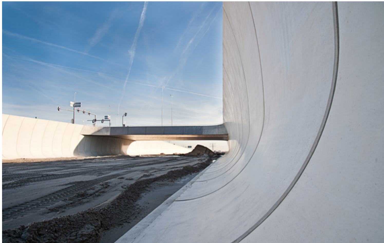
Volledig prefab beton en toch heeft elk element een eigen 'boogstraal'.
