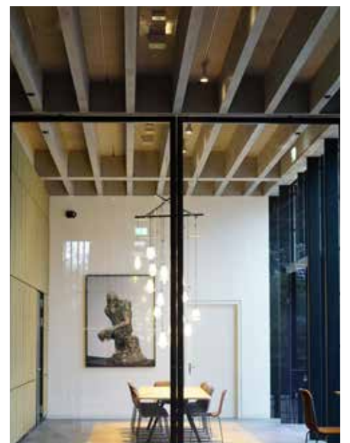
Ruwbouw is afbouw; geen verlaagd plafond.
