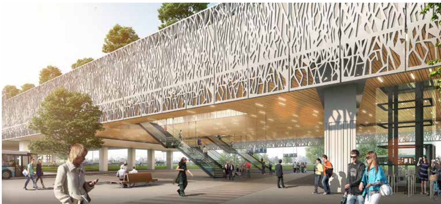
Ook het bovenste wat u ziet is prefab beton.
