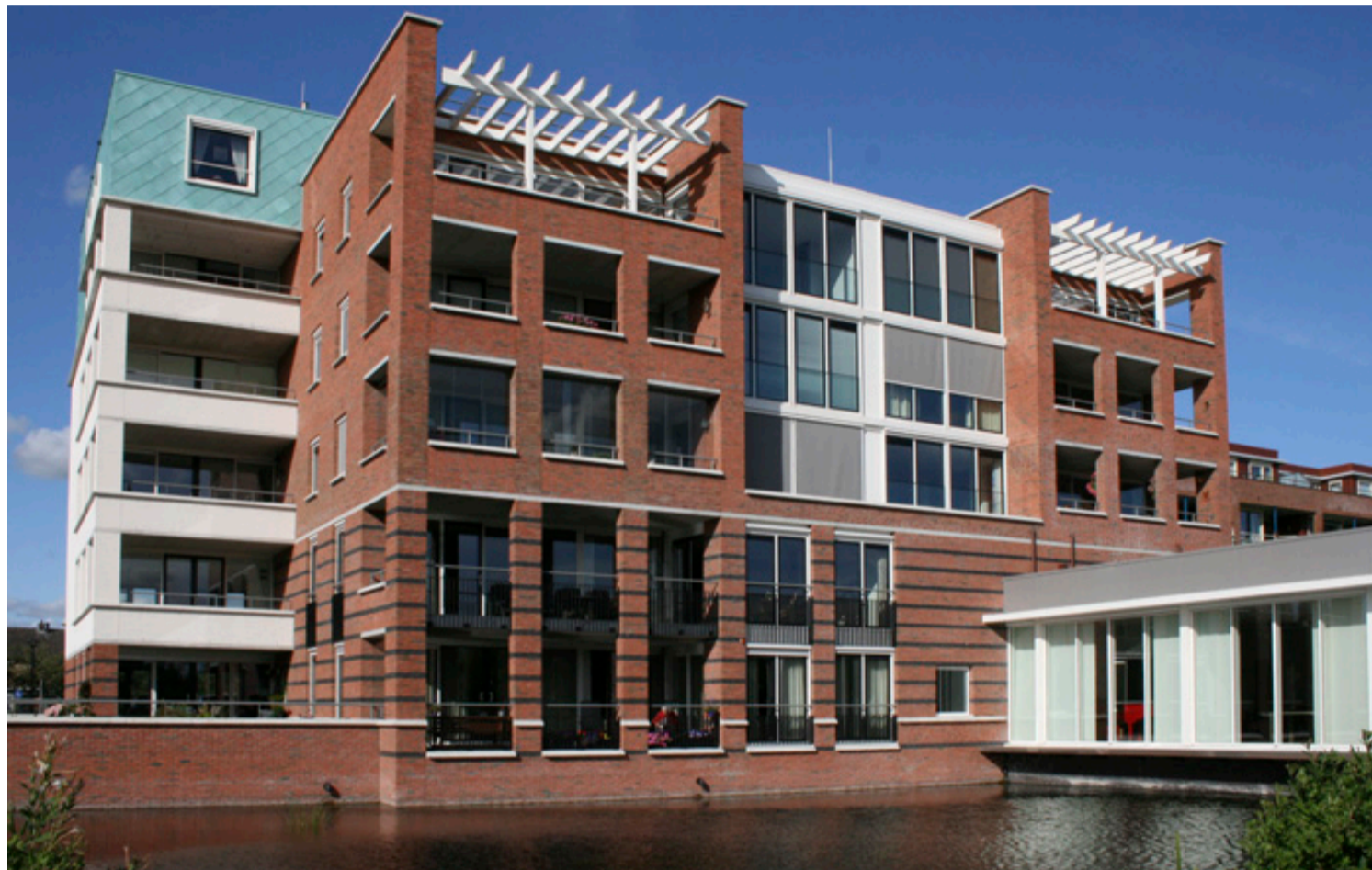
Bij hoge grondwaterstand en geen goede waterafsluitende laag bieden prefab betonpalen uitkomst, zoals bij dit appartementen/seniorencomplex in Reeuwijk.
