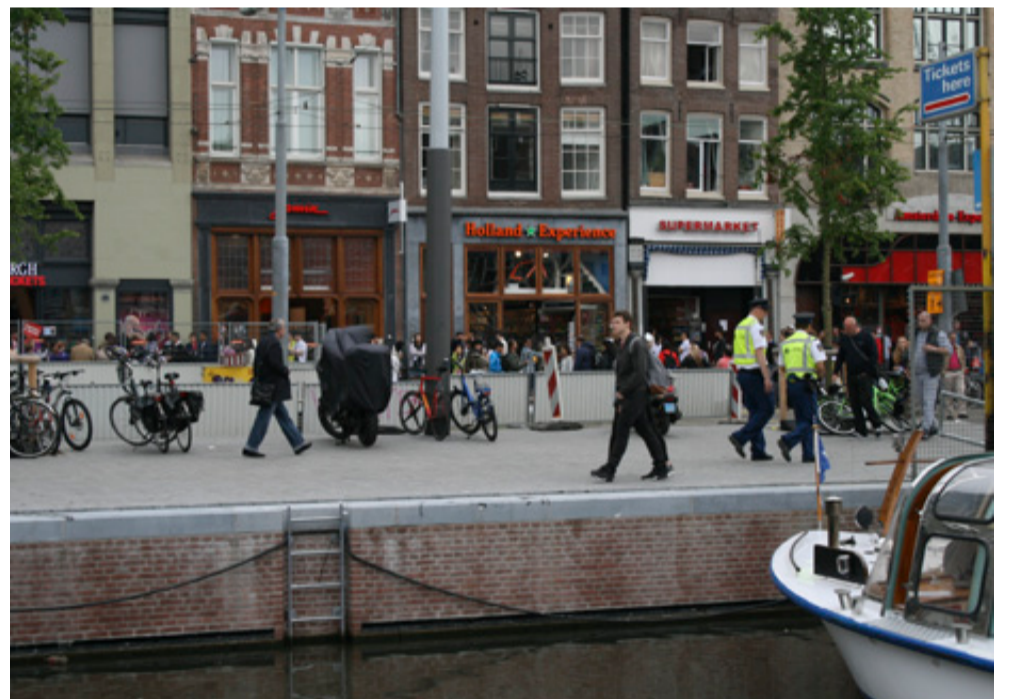
Waar je normaliter weken bezig bent met funderen, bekisten en betonstorten, hingen de prefab betonschorten in no time op hun plek.
