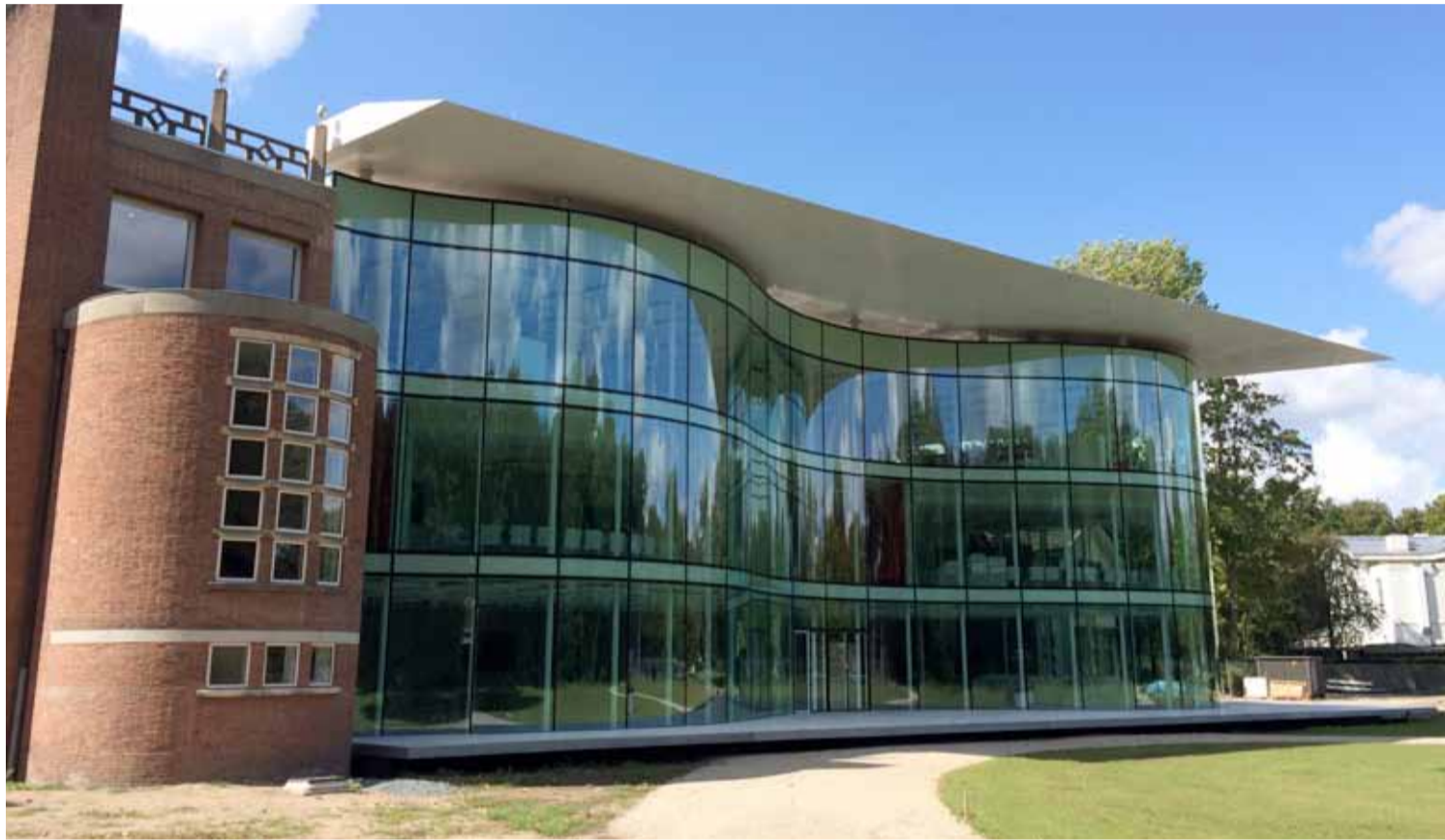
De slim ontworpen glazen gevel zorgt voor veel daglicht, zonder dat de temperatuur in de zomer hoog oploopt.
