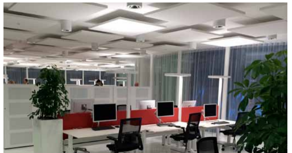
Het deels open plafond regelt zowel de directe warmte/koude-uitwisseling als verlichting en akoestiek.
