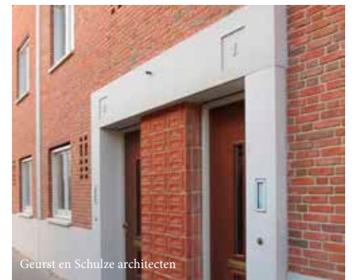
In het prefab beton zijn huisnummer, bel en waterafvoer slim opgenomen.
