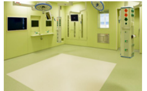
De constructie ter hoogte van operatiekamers en centrale as is toegesneden op belasting en flexibiliteit.
