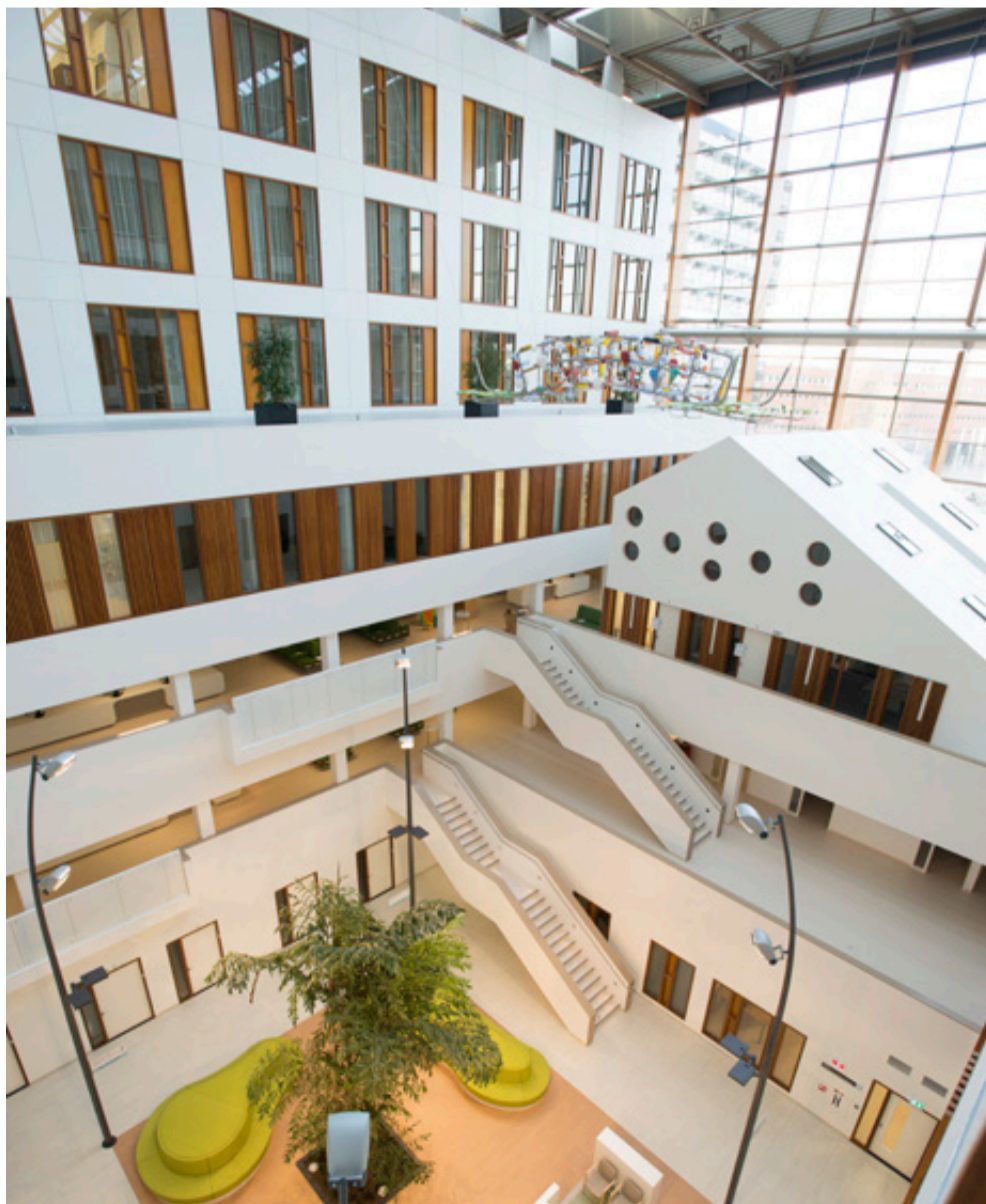
De vingers binnen de gebouwopzet, waar de beddenkamers aan de atria zijn gesitueerd, hebben een efficiënte opzet in prefab beton gekregen.
