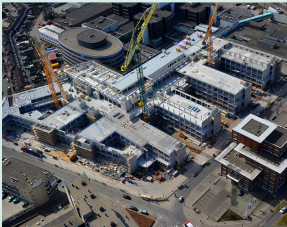
Doordachte gebouwstructuur met een centrale as en repeterende beddenvleugels die onder een grote 'stolp' zijn geplaatst.
